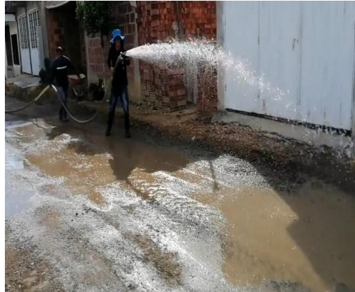
Figura 25. Humectación de la sub-base
