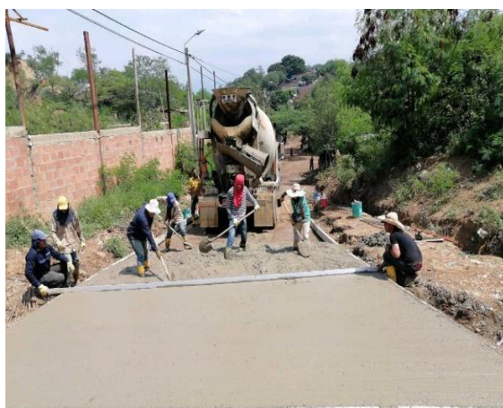
Figura 29. Una vez vaciado el concreto, los obreros van esparciendo la mezcla con ayuda de palas y con un codal de aluminio van perfilando la vía
