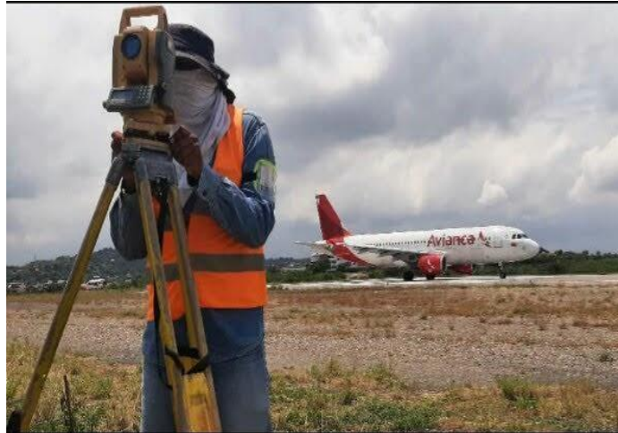
Figura 37. Realizando el proceso de nivelación del equipo
