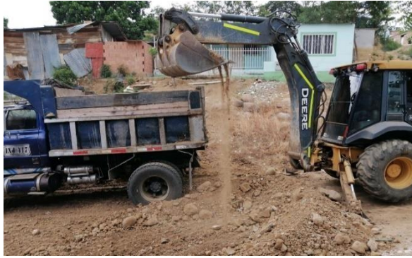
Figura 22. Retiro del material excavado
