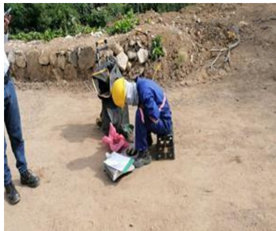
Figura 27. Una vez el terreno esta uniforme, se llama al laboratorista para que tome densidades
