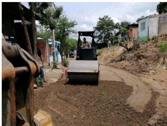
Figura 24. Proceso de compactación de la sub- base con el vibro compactador
