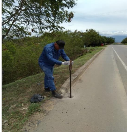
Figura 44. Realizando el proceso de excavación donde fundiremos los mojones
