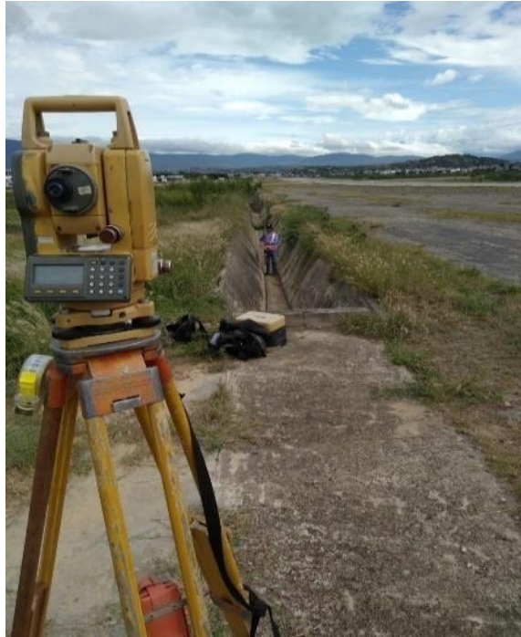
Figura 35. Iniciando el levantamiento de los canales adyacentes a las pistas del aeropuerto
