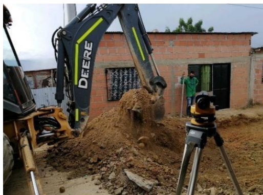
Figura 21. Inicio de excavación para el cajeo de vía
