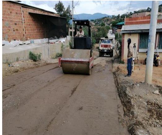
Figura 26. Se realiza una vez más el proceso de compactación con el vibro compactador
