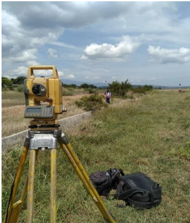
Figura 34. Se realizo uno poligonal hasta la pista del aeropuerto para iniciar a radiar los canales, puntos de nivel, antenas y demás datos importantes
