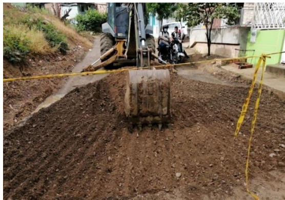
Figura 23. Instalación de la sub-base
