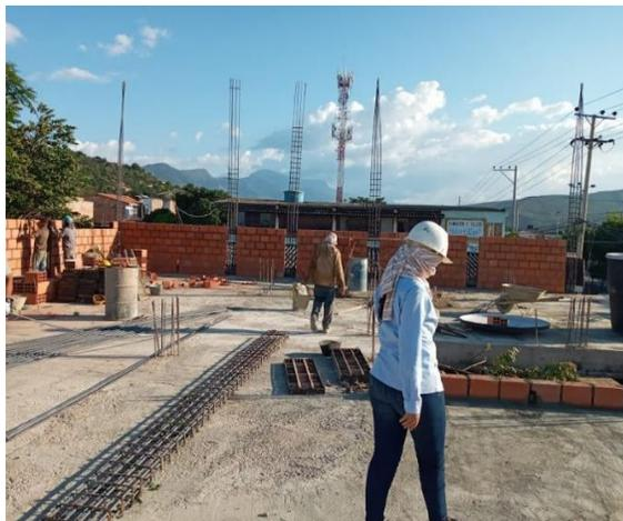
**Figura 3. Levantamiento de columnas**
