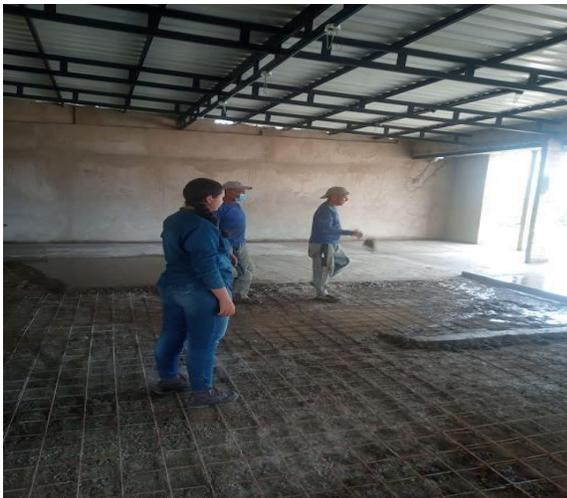
**Figura 37. Vaciado del mortero.**
