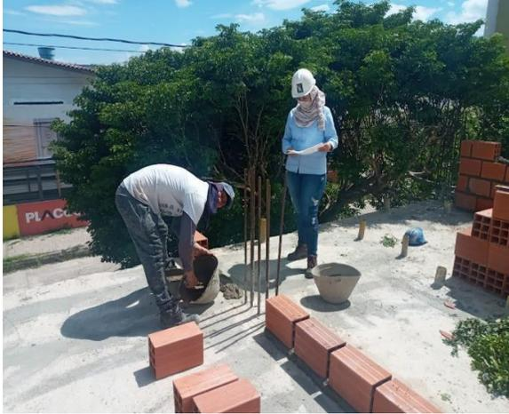
**Figura 12. Replanteo de muros**
