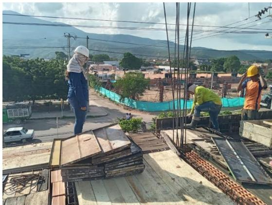
**Figura 19. Testereo de placa.**
