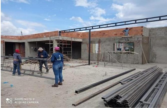
**Figura 26. Armado y monte de estructura metálica de cubierta.**
