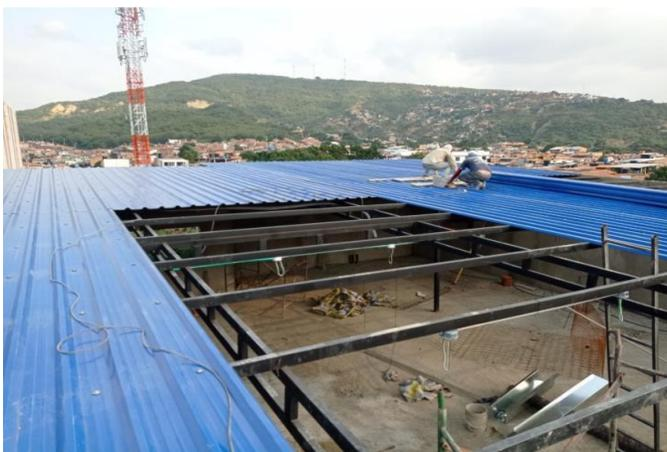
**Figura 28. Monte de láminas galvanizadas.**
