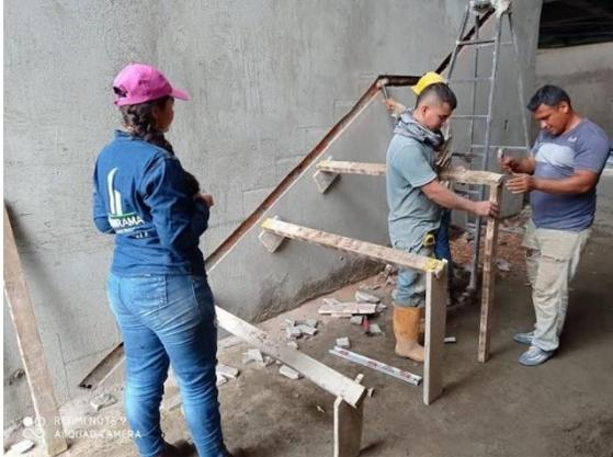
**Figura 22. Inicio de armado de encamillado de escalera.**
