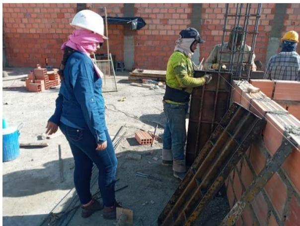
**Figura 4. Encofrado de columnas**
