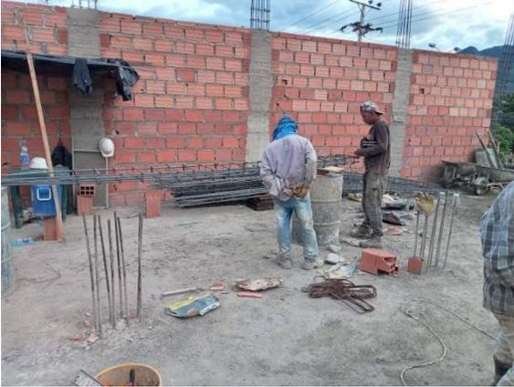
**Figura 6. Desencofre de columnas**
