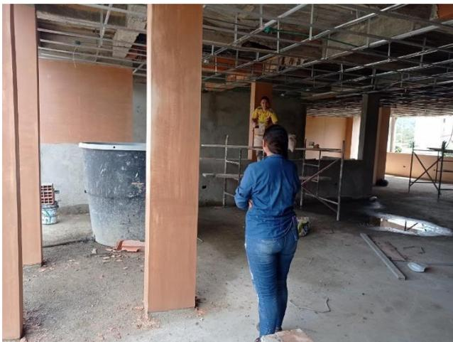
**Figura 33. Estuco de columnas y muros.**
