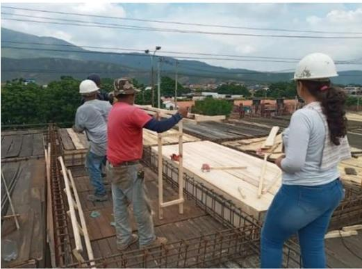
**Figura 17. Armado y ubicación de casetones de madera recuperables.**
