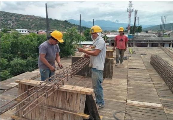
**Figura 7. Armado de vigas de entrepiso.**
