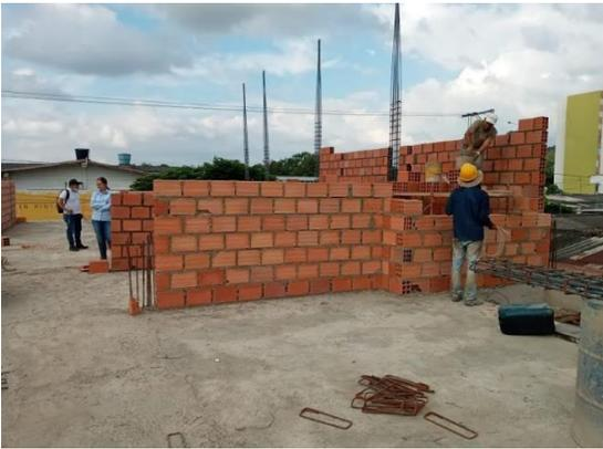
**Figura 14. Levantamiento de mampostería**
