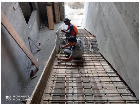
**Figura 23. Encamillado y armado de hierro de escalera.**
