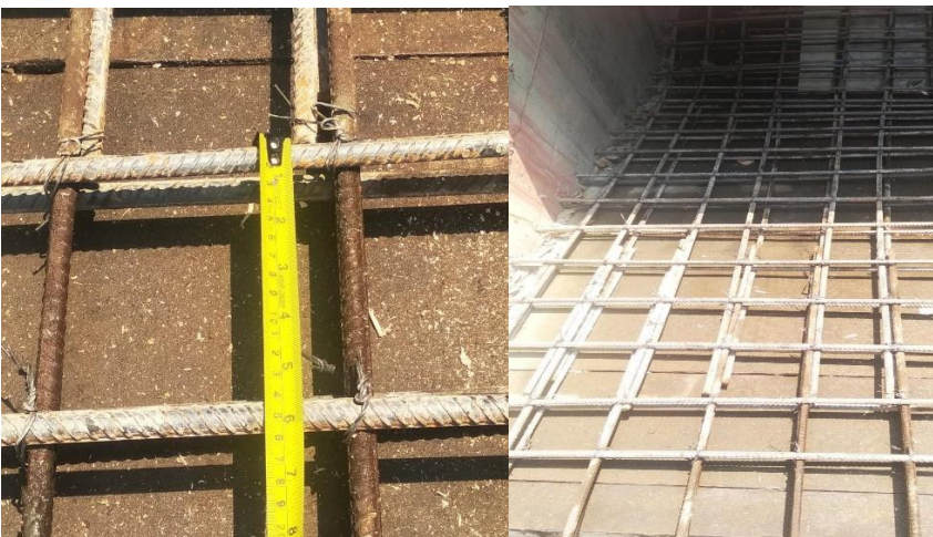
Figura 62. Instalación de los refuerzos horizontales
