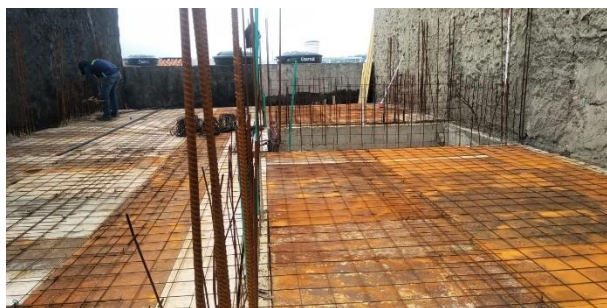
Figura 27. Malla de refuerzo inferior instalada
