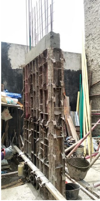
Figura 22. Desencofrando un muro
