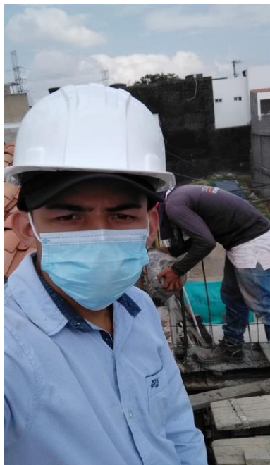
Figura 55. Supervisión de vaciado en concreto
