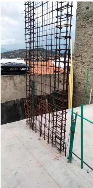
Figura 45. Malla de 9mm instalada
