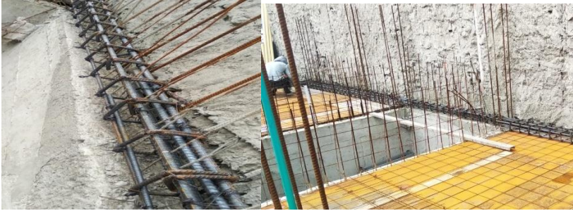
Figura 31. Instalación de los estribos especiales para la zona de la escalera
