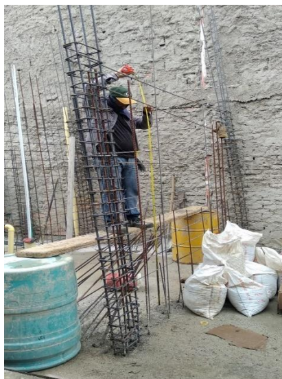
Figura 8. Colocación de las varillas horizontales y verticales
