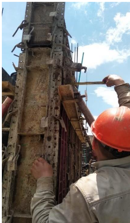
Figura 21. Rectificación de la plomada
