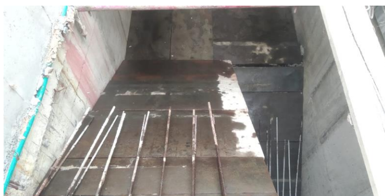
Figura 59. Formaleta inclinada
