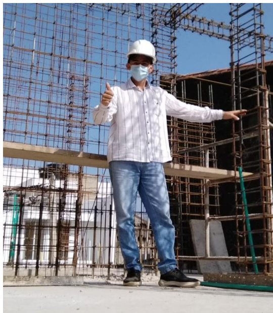
Figura 47. Supervisión de la instalación del tejido de 9mm y malla de 5mm
