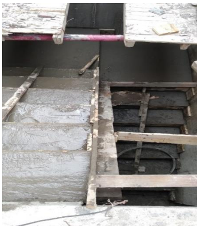
Figura 65. Escaleras fundidas
