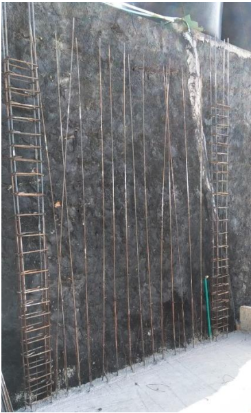
Figura 43. Varilla de 9mm instalada de forma vertical
