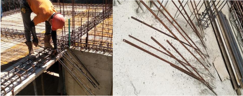
Figura 60. Arranques de la escalera
