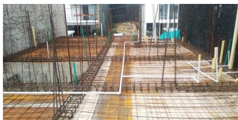
Figura 35. Instalación de la red hidráulica
