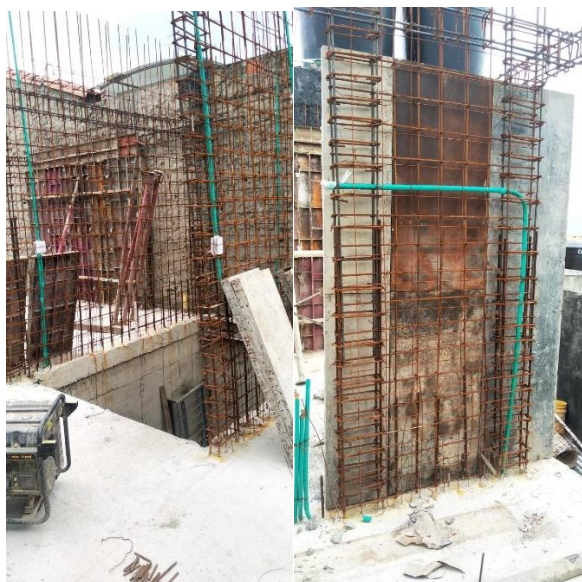
Figura 48. Instalación de los puntos eléctricos
