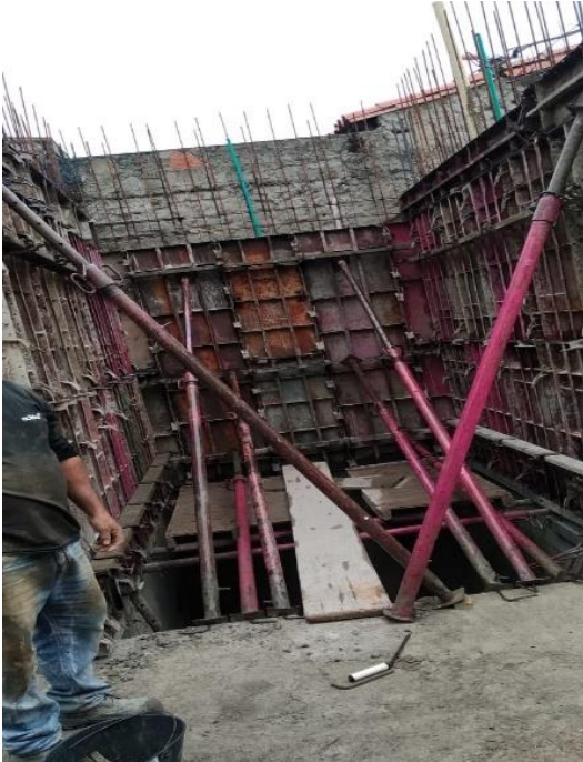
Figura 52. Muro listo para fundir
