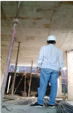
Figura 39. Inspección en el desencofrado de la placa de entre piso
