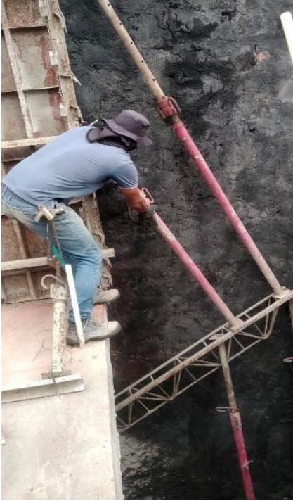
Figura 51. Asegurando los muros pantalla
