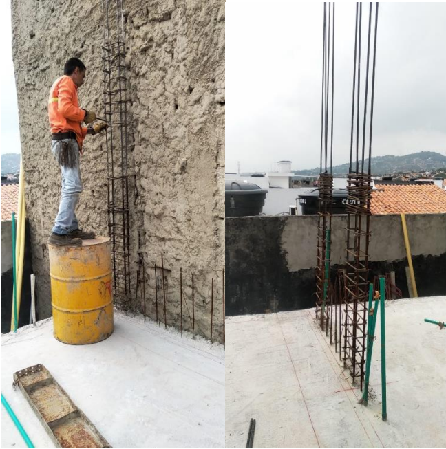
Figura 42. Armadura de las columnas de los muros pantalla
