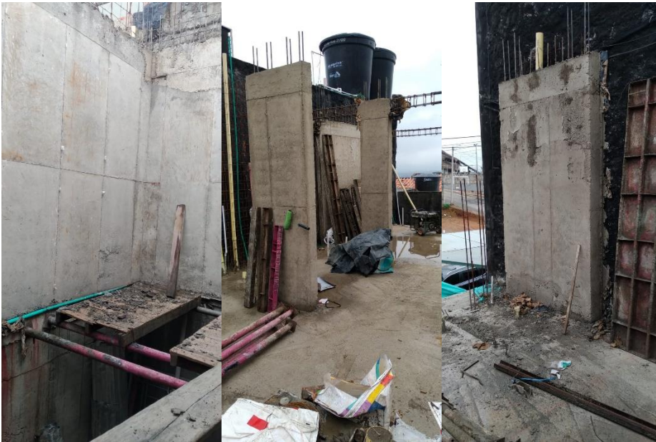
Figura 57. Muros segundo nivel terminados
