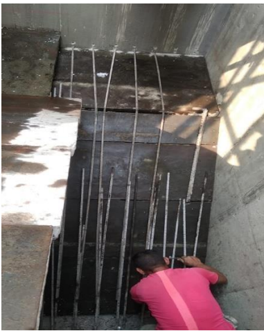
Figura 61. Ubicación de los refuerzos verticales
