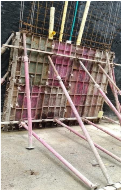
Figura 18. Muro encofrado listo para fundir
