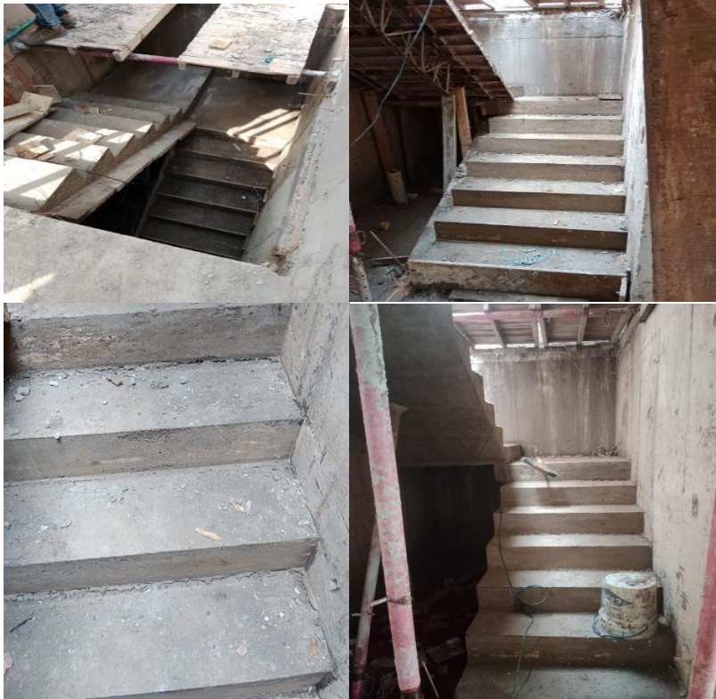
Figura 66. Desencofrado de la escalera y Escaleras terminadas
