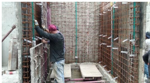
Figura 49. Encofrado industrializado de muros
