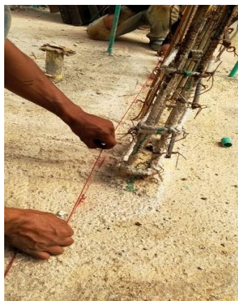
Figura 4. Cimbrar para la localización de los muros
