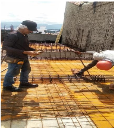
Figura 32. Armadura de las vigas
