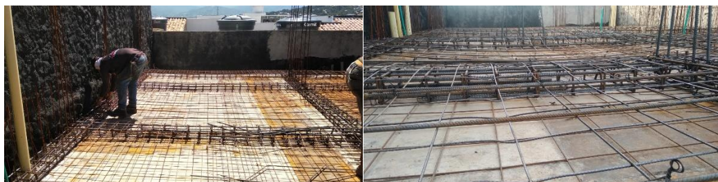
Figura 34. Instalación de la malla de refuerzo superior
