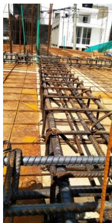
Figura 33. Vigas de la placa de la placa de entre piso armadas
