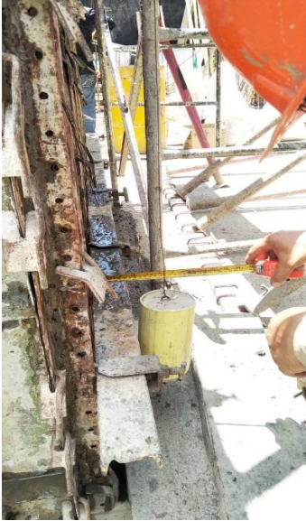
Figura 17. Muro aplomado listo para fundir
