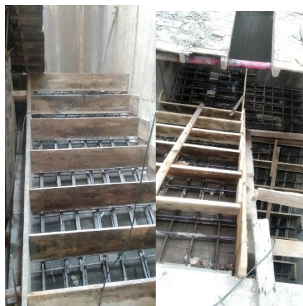
Figura 63. Instalación de las tablas laterales
