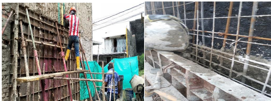
Figura 19. Vaciado en concreto
