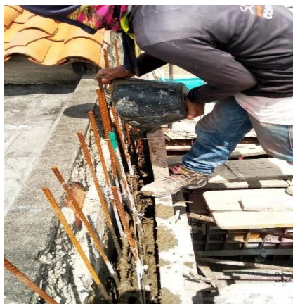
Figura 54. Vaciado en concreto de los muros pantalla
