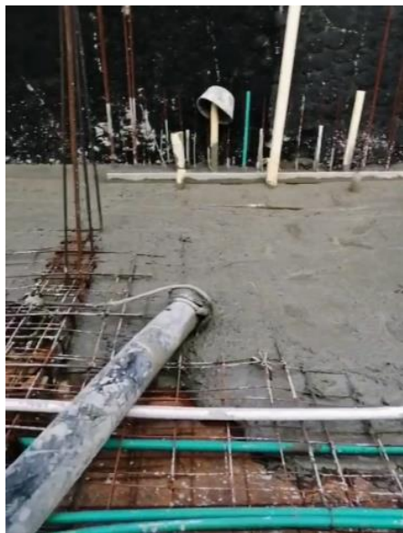
Figura 37. Fundición en concreto de placa entre piso
