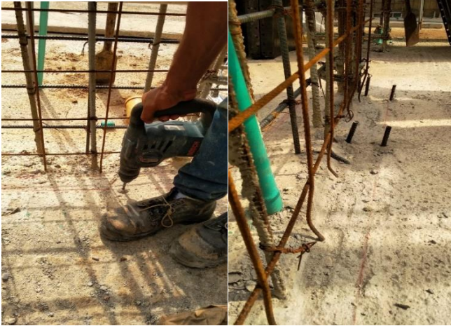
Figura 13. Instalación de los chazos para sostener las latas
