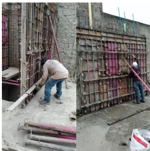
Figura 50. Instalación de los alineadores
