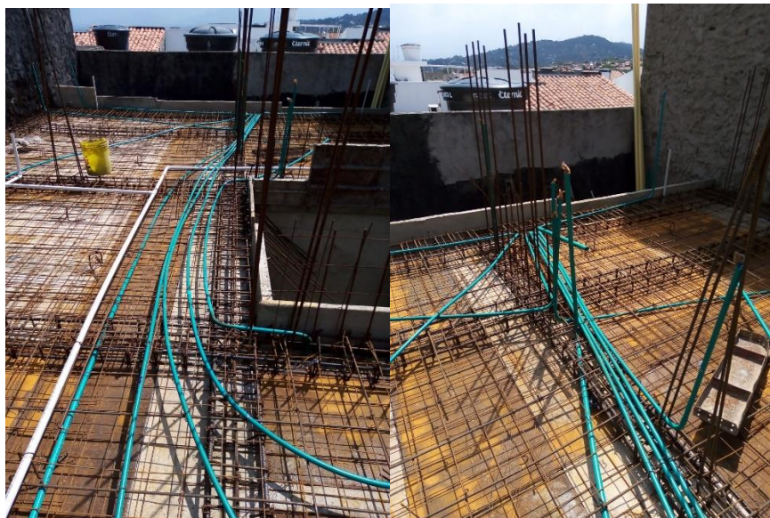
Figura 36. Instalación de la red eléctrica
