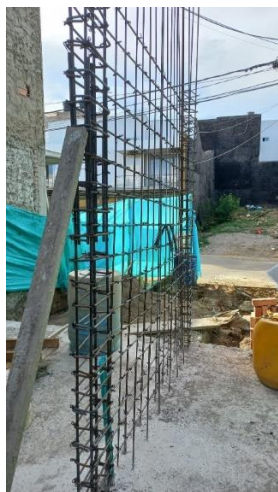
Figura 10. Muro armado con tejido de 9mm y malla de 5mm
