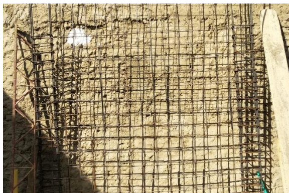
Figura 9. Tejido de muro completo
