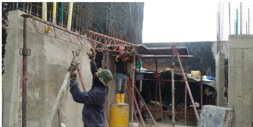
Figura 24. Instalación de parales y cerchas
