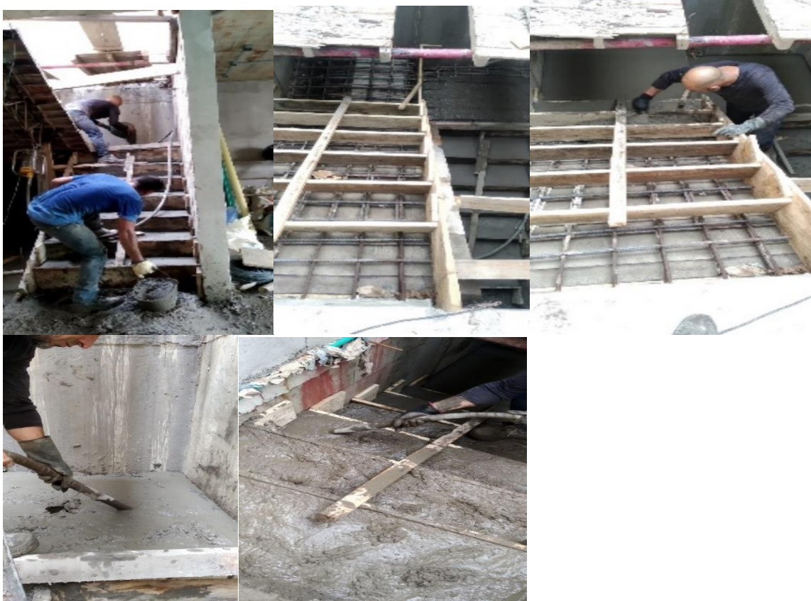
Figura 64. Vaciado en concreto de las escaleras y Vibración del concreto
