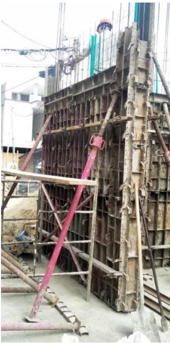
Figura 16. Muro asegurado, listo para aplomarlo y fundirlo
