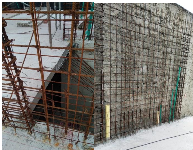
Figura 46. Muro terminado con sus dos mallas de 9mm y 5mm
