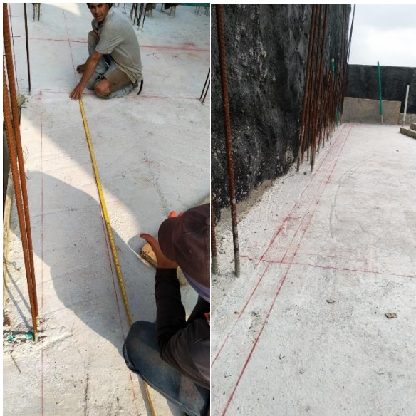
Figura 41. Cimbrar para localización de los muros de la segunda planta
