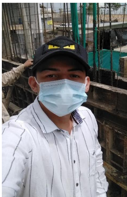
Figura 20. Supervisión - vaciado en concreto de los muros
