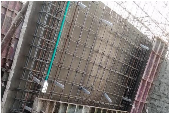
Figura 14. Muro encofrado por un solo lado con sus respectivas corbatas
