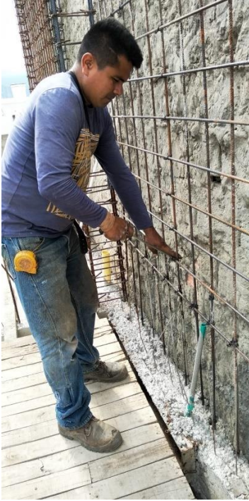
Figura 44. Instalación de la varilla de 9mm de forma horizontal, formando cuadrícula 15x15
