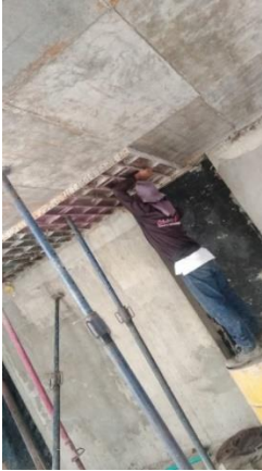
Figura 38. Desencofrado de la placa de entre piso
