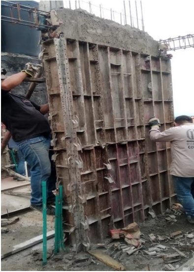
Figura 56. Desencofrado de los muros
