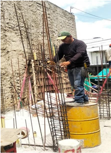
Figura 7. Armadura de las columnas de los muros
