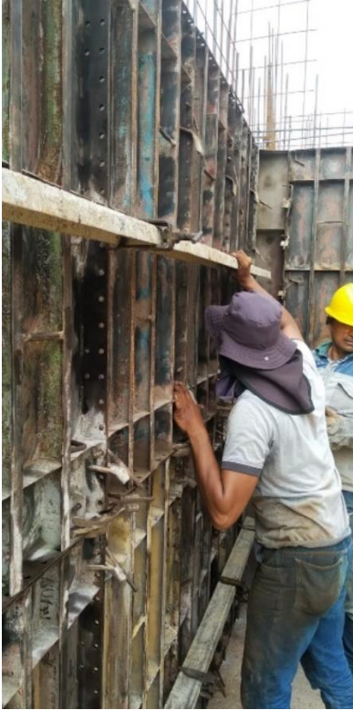
Figura 15. Instalacion de los alineadores
