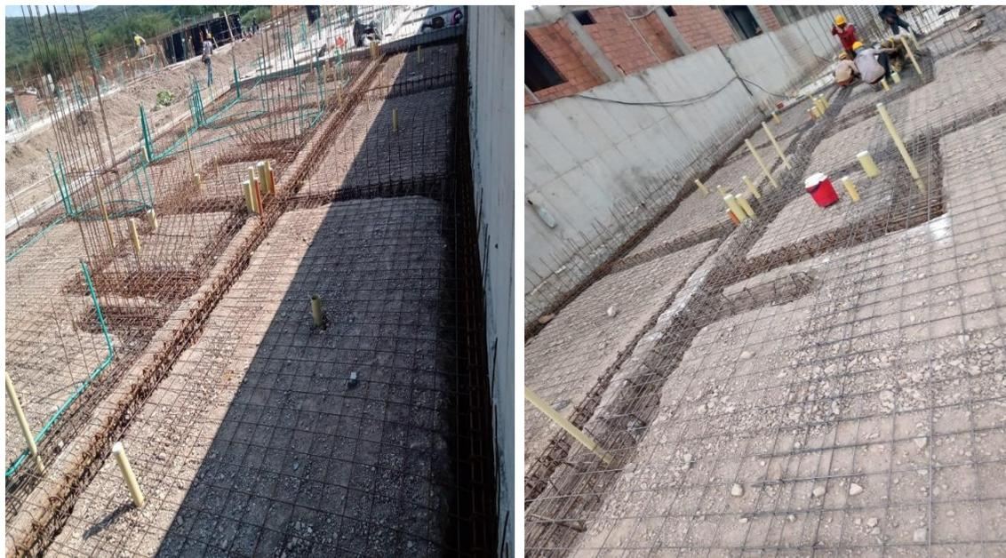
**Figura 16. Instalación malla electrosoldada**
