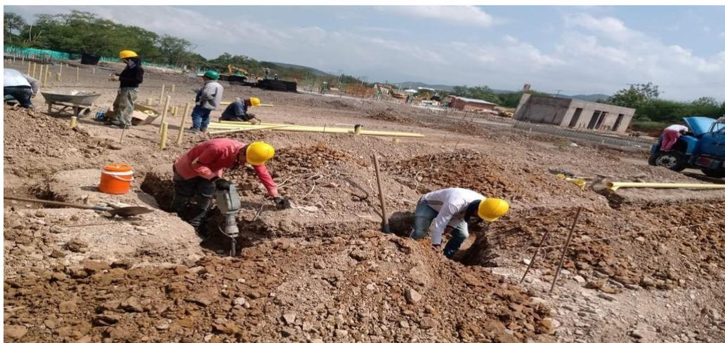
**Figura 6. Excavación para instalaciones subterráneas**
