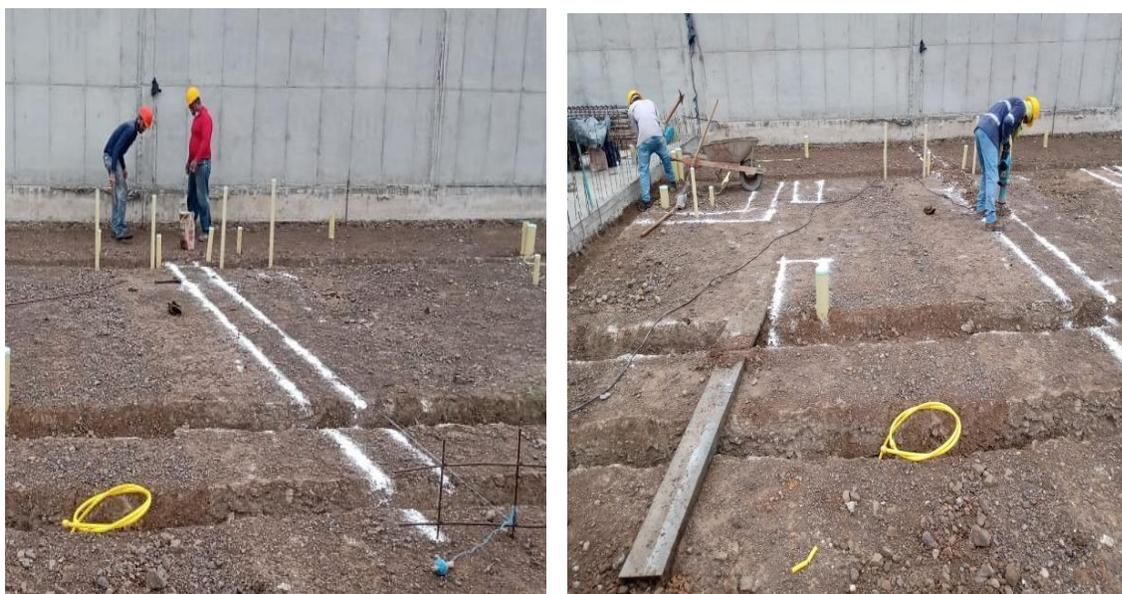
**Figura 11. Trazado y localización en cimentación**
