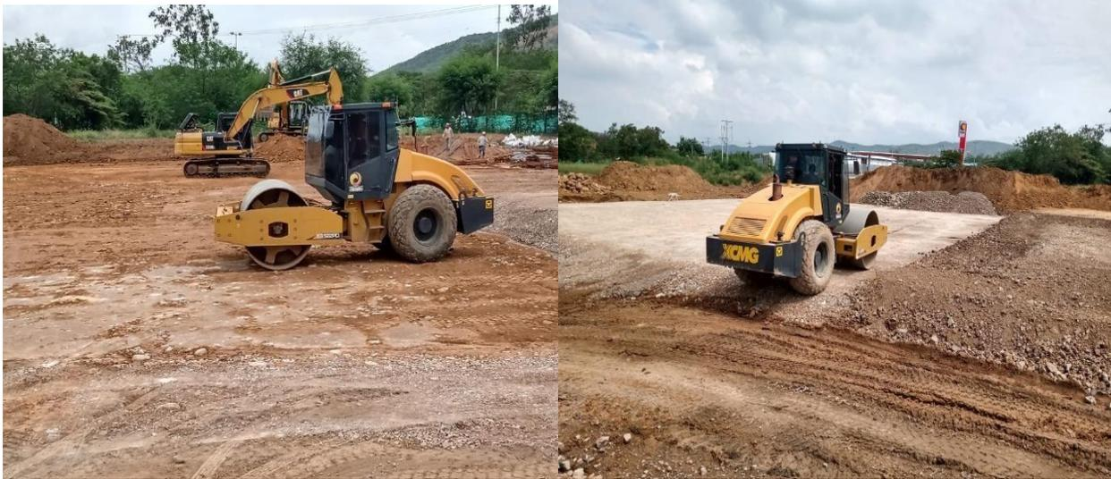
**Figura 3. Compactación y nivelación del terreno**
