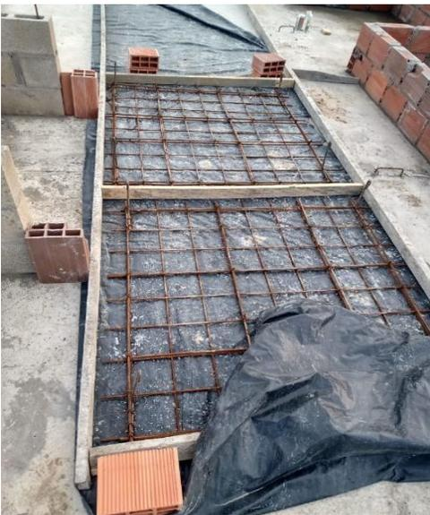
**Figura 60. Armado de hierro placa tanque**
