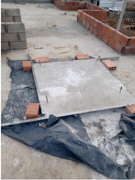
**Figura 61. Fundida placa tanque**
