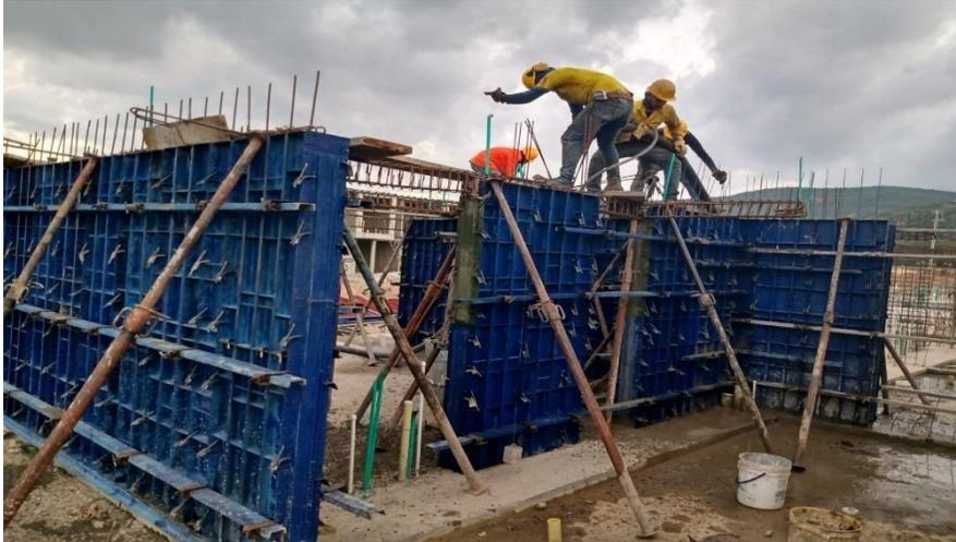
**Figura 30. Fundida de muros de primera planta**
