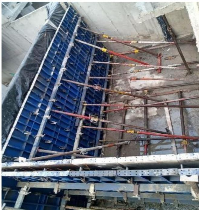
**Figura 28. Encofrado de muros de patio**
