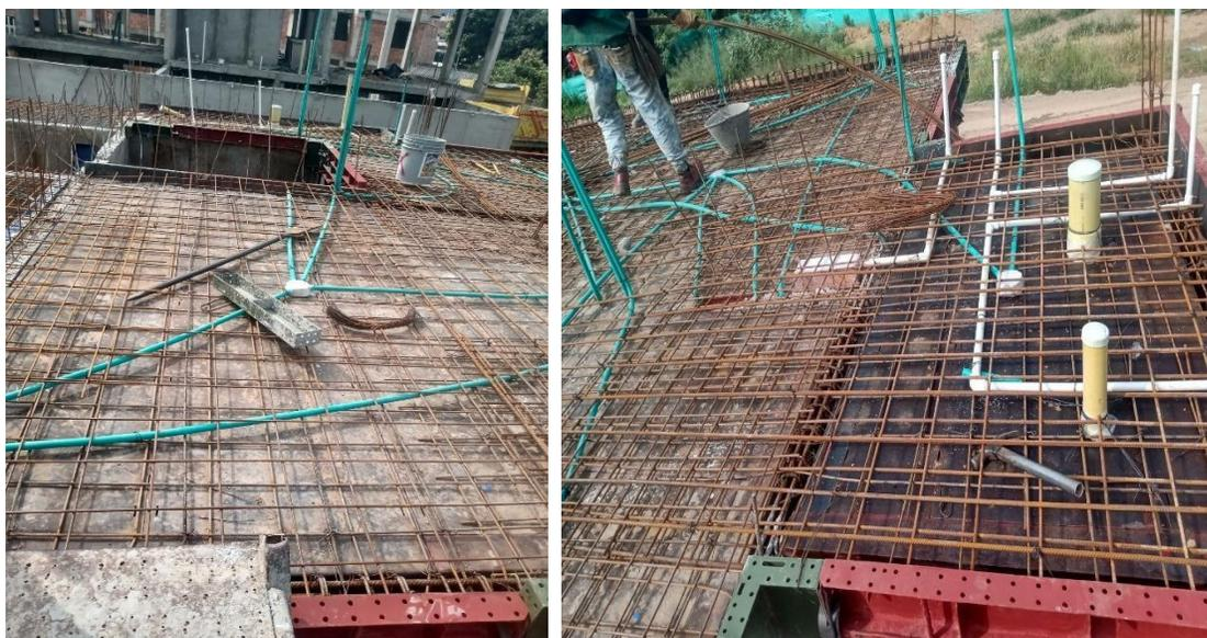
**Figura 38. Instalaciones de tubería eléctrica, instalaciones de tubería sanitaria en placa entre piso hidrosanitaria en placa entre piso**
