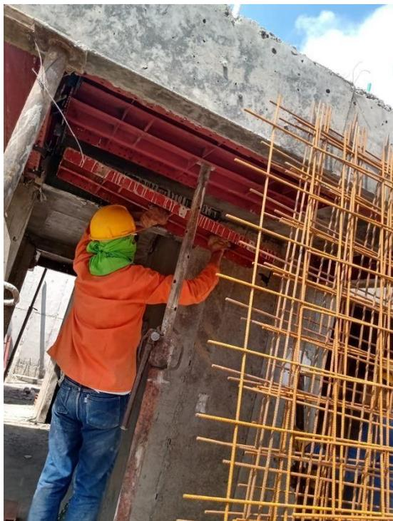
**Figura 41. Desenclavado de tableros metálicos en placa**
