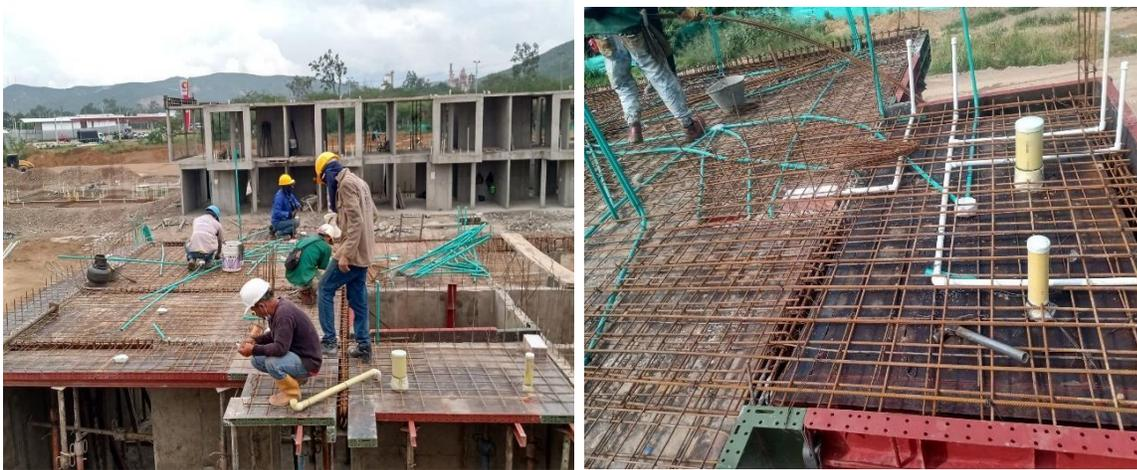
**Figura 36. Placa entre piso y vigas aéreas**
