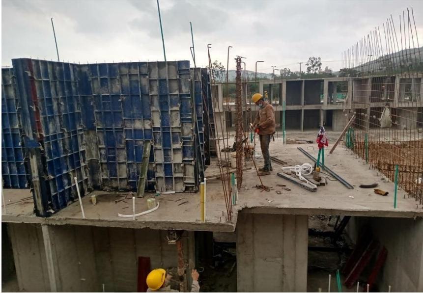
**Figura 42. Muros y columnetas en segunda planta**
