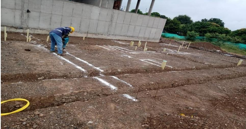
**Figura 12. Excavación vigas de cimentación**
