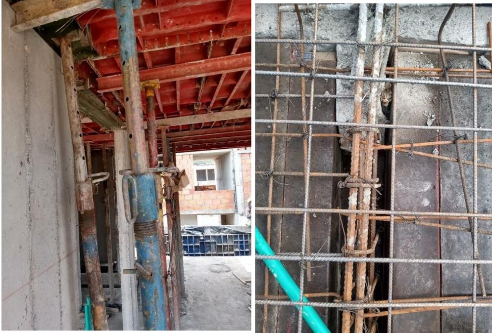
**Figura 48. Armado y colocación de formaleta para placa cubierta y vigas aéreas**
