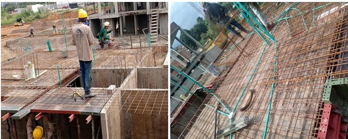
**Figura 37. Instalación malla electrosoldada y arranques en placa entre piso**
