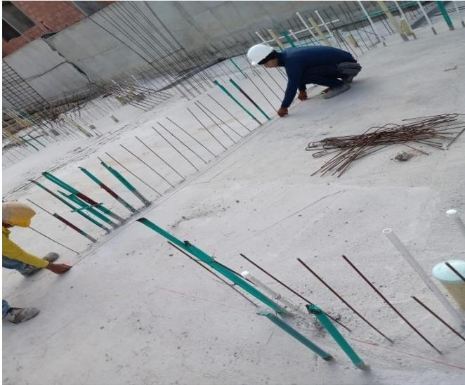
**Figura 27. Localización y replanteo en muros**
