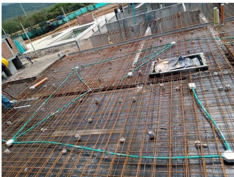
**Figura 50. Instalación malla electrosoldada y arranques en placa cubierta**
