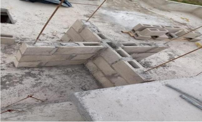
**Figura 59. Instalación bloques en concreto para placa tanque**
