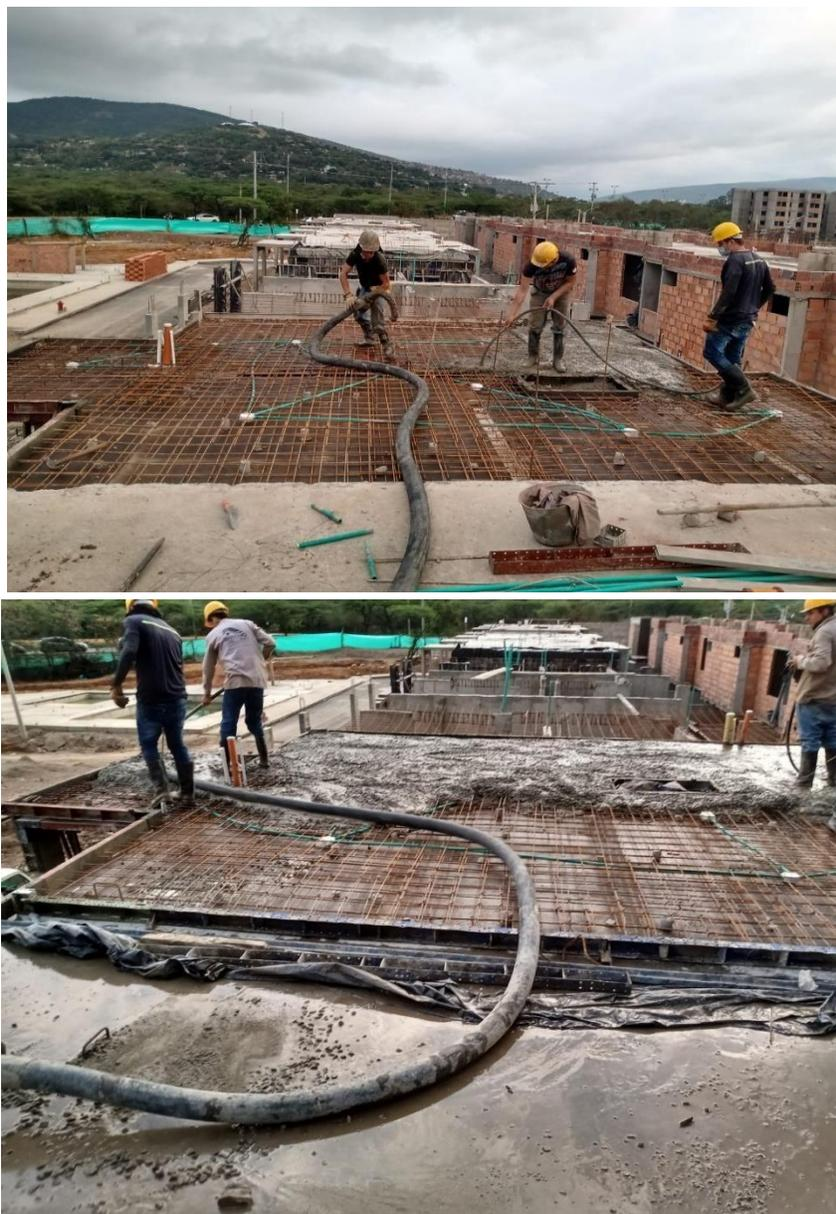
**Figura 52. Fundida placa cubierta**
