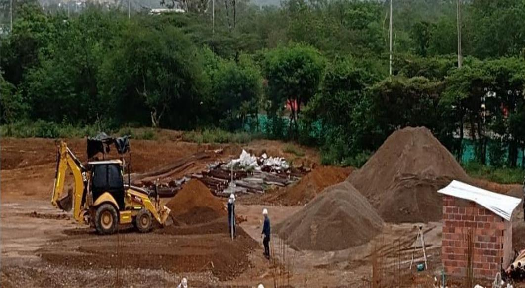
**Figura 4. Compactación y nivelación del terreno**
