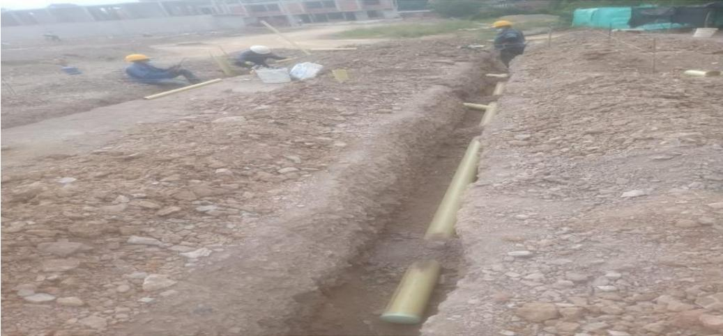
**Figura 8. Instalación de tubería sanitarias**
