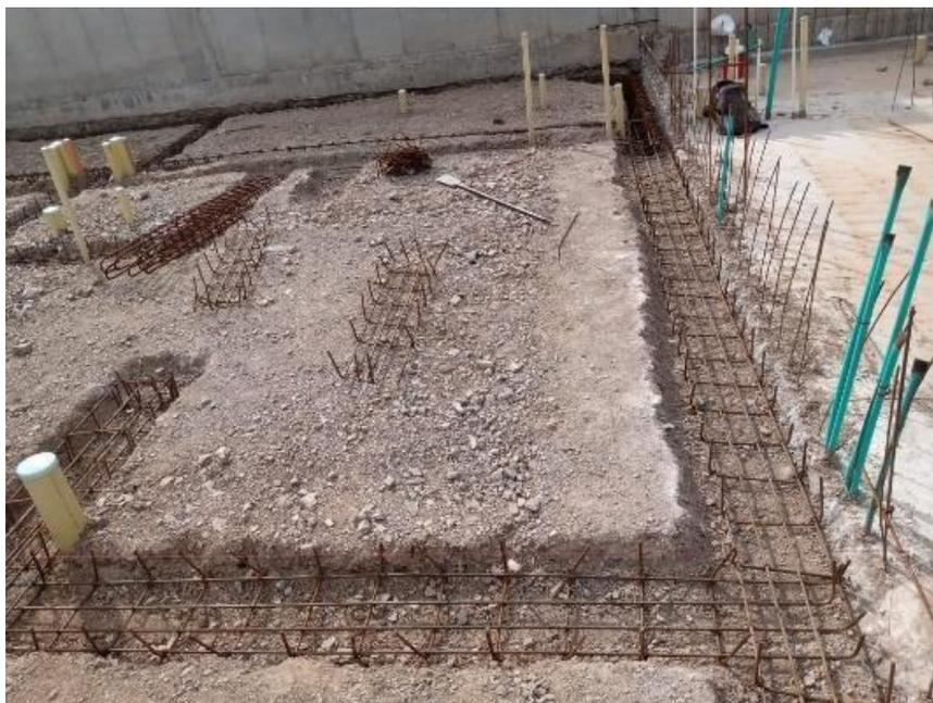
**Figura 15. Viga zapata de cimentación**
