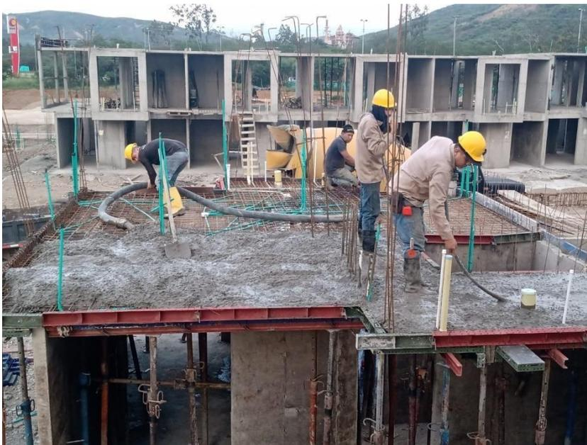
**Figura 39. Fundida placa entre piso**
