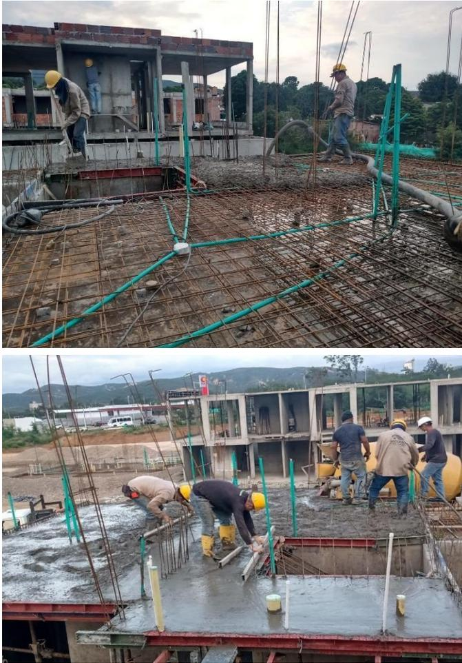
**Figura 40. Fundida y cepillado placa entre piso**
