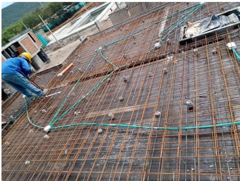
**Figura 51. Instalación de tubería eléctrica e hidrosanitaria en placa cubierta**
