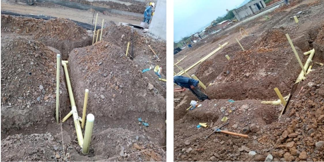
**Figura 7. Instalación de tubería sanitarias**
