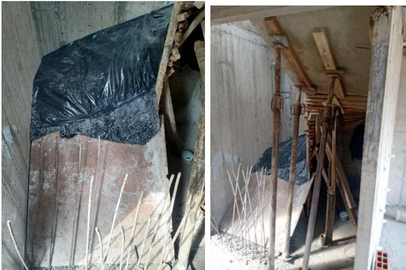
**Figura 56. Encofrado en escalera**
