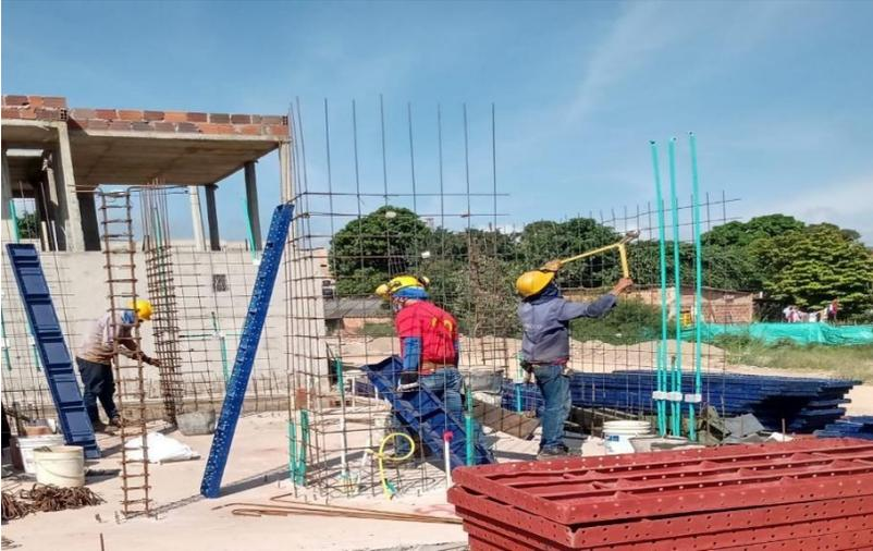
**Figura 25. Instalación malla y columnas**
