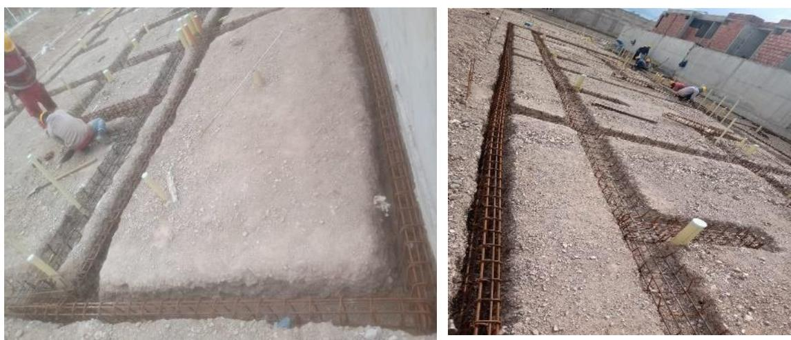
**Figura 14. Armado vigas de cimentación**
