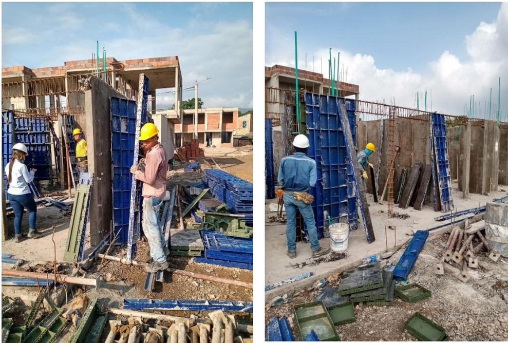
**Figura 31. Desencofrado de tableros metálicos**
