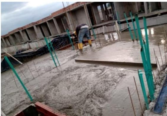
**Figura 33. Placa entre piso y vigas aéreas**
