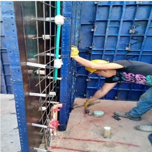
**Figura 26. Instalación de separadores para muros**
