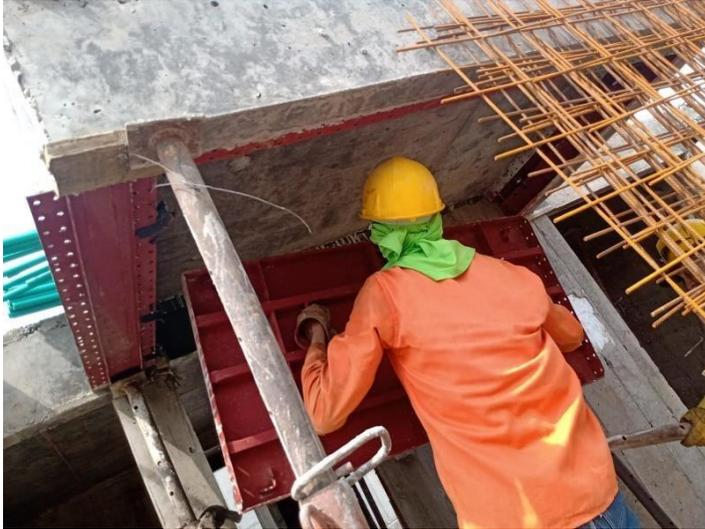
**Figura 54. Desenfofrado de tableros metálicos en placa cubierta**
