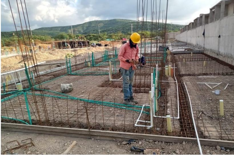
**Figura 18. Instalación de tubería eléctrica e hidrosanitaria en cimentación**
