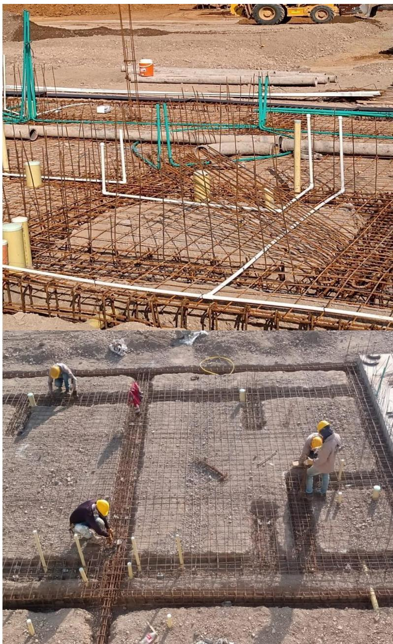
**Figura 17. Instalación de arranques en cimentación**
