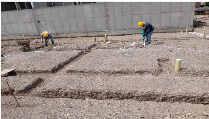
**Figura 13. Excavación vigas de cimentación**
