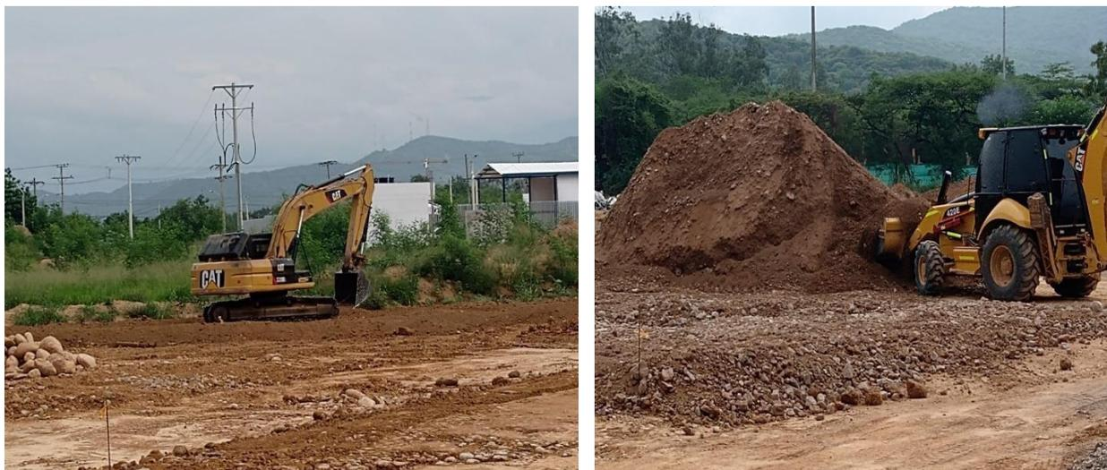
**Figura 2. Movimiento de tierras y aplicación de capas granulares**
