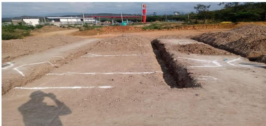
**Figura 5. Cimbrado para excavación de tubería**
