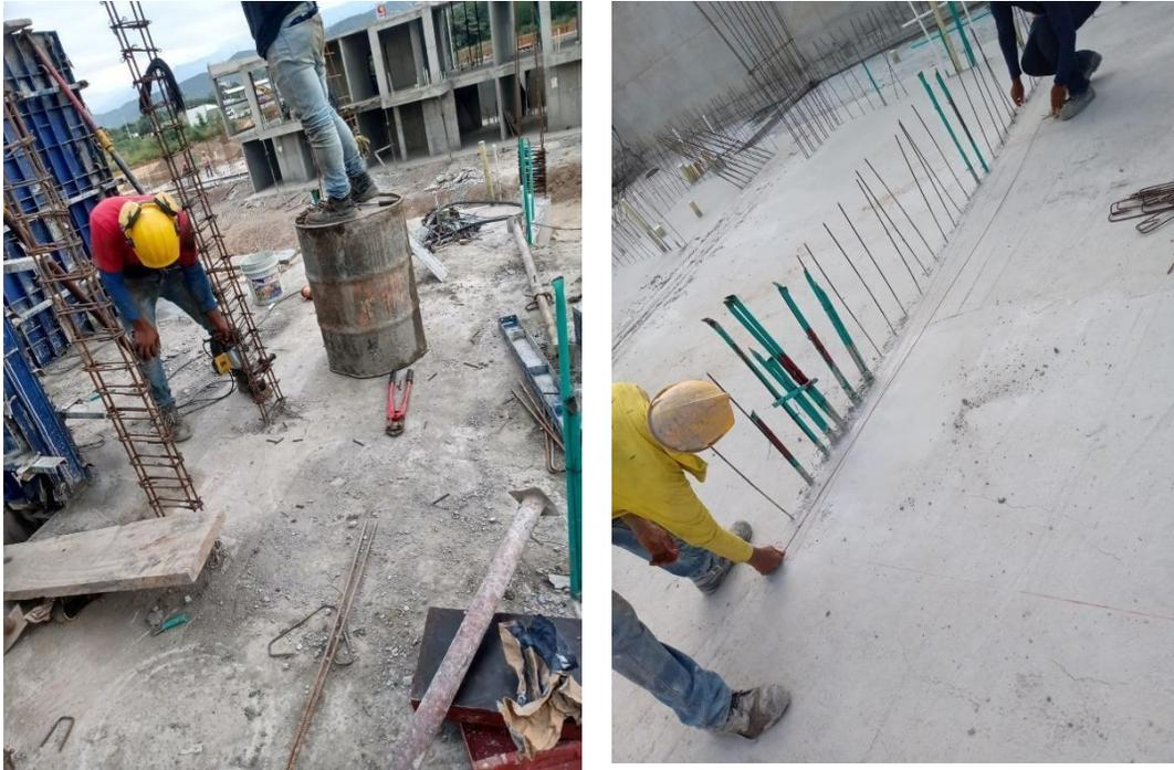
**Figura 44. Cimbrado y colocación de taches para muros y columnas**
