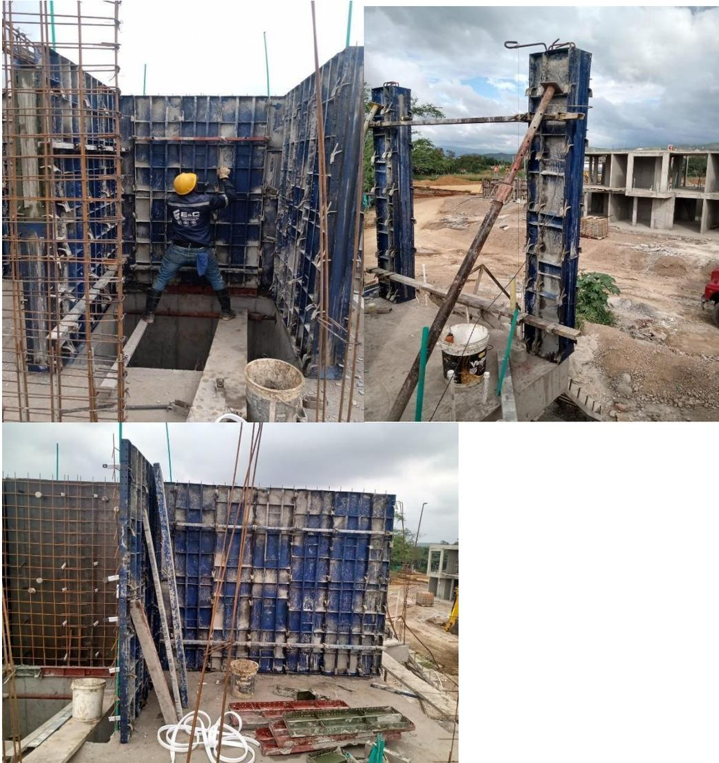
**Figura 45. Instalación de formaleta para muros y columnetas de segunda planta**
