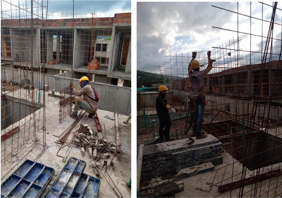
**Figura 43. Instalación malla electrosoldada y estibos en columnetas en segunda planta**
