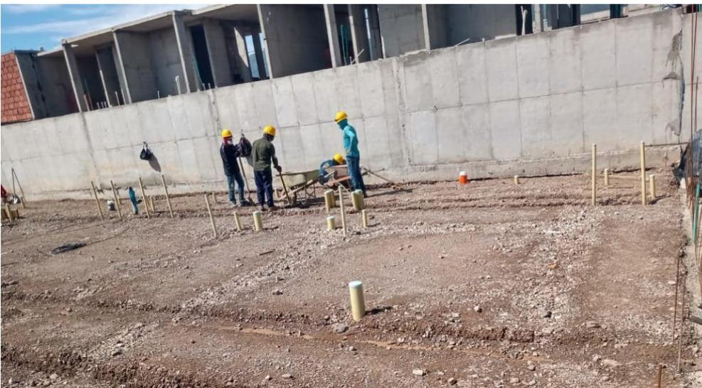
**Figura 9. Relleno de excavación con mismo material**
