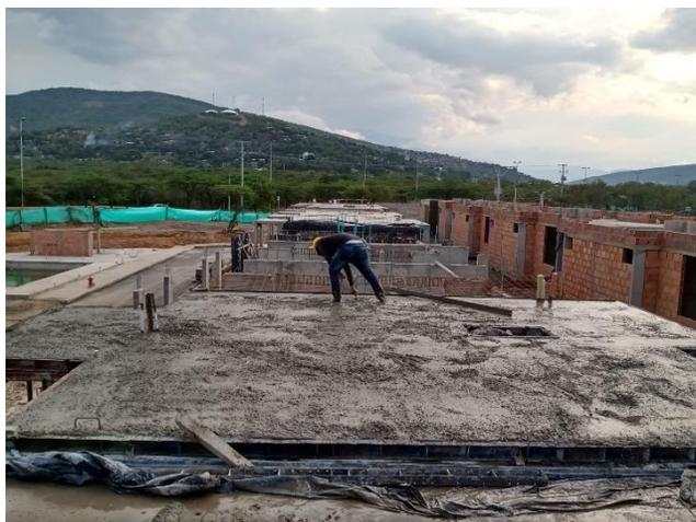
**Figura 53. Afinado y alisado placa cubierta**
