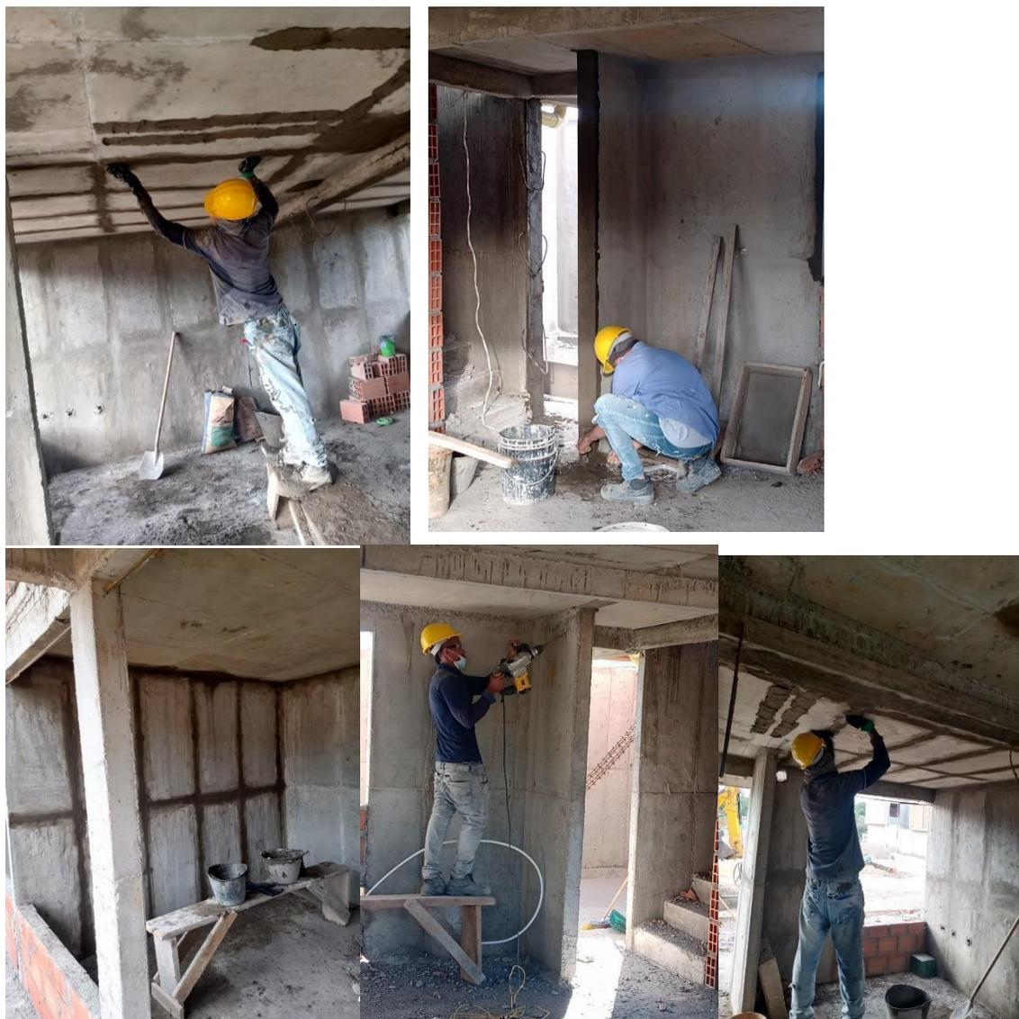
**Figura 65. Maquillajes en muros y filos en columnas y vigas**
