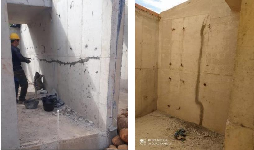
**Figura 32. Resanes en muros**
