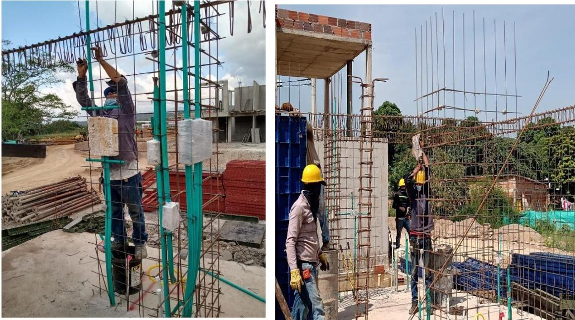
**Figura 24. Instalación eléctrica y de malla en muros**
