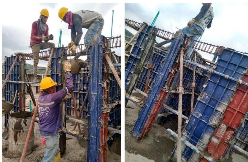
**Figura 46. Fundida de muros y columnas en segunda planta**
