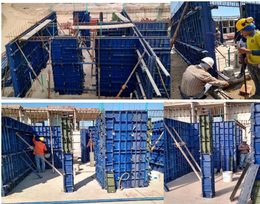
**Figura 29. Encofrado de muros y columnas**
