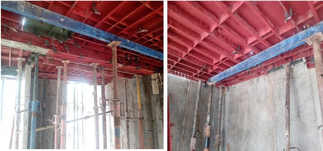
**Figura 34. Armado y colocación de formaleta para placa de entrepiso y vigasaéreas**
