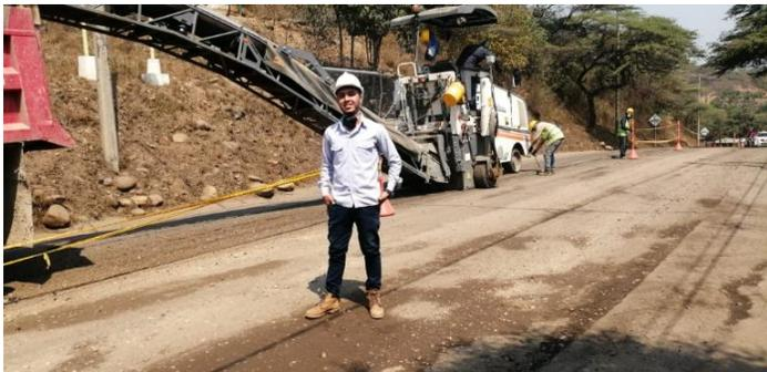
**Figura 3. Fresado kilómetro 55+700**
