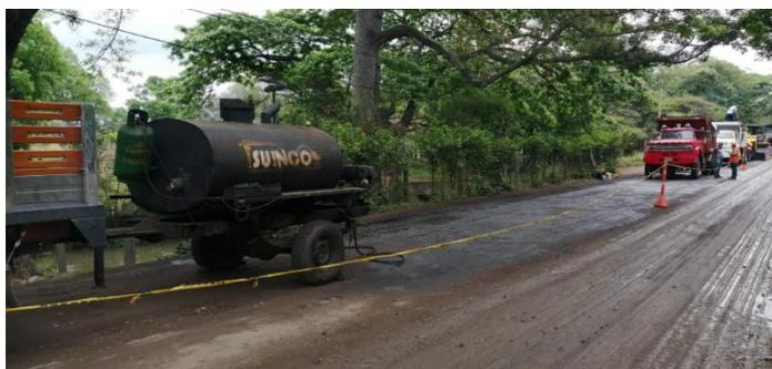
**Figura 5. Imprimación en kilómetro 56+200**
