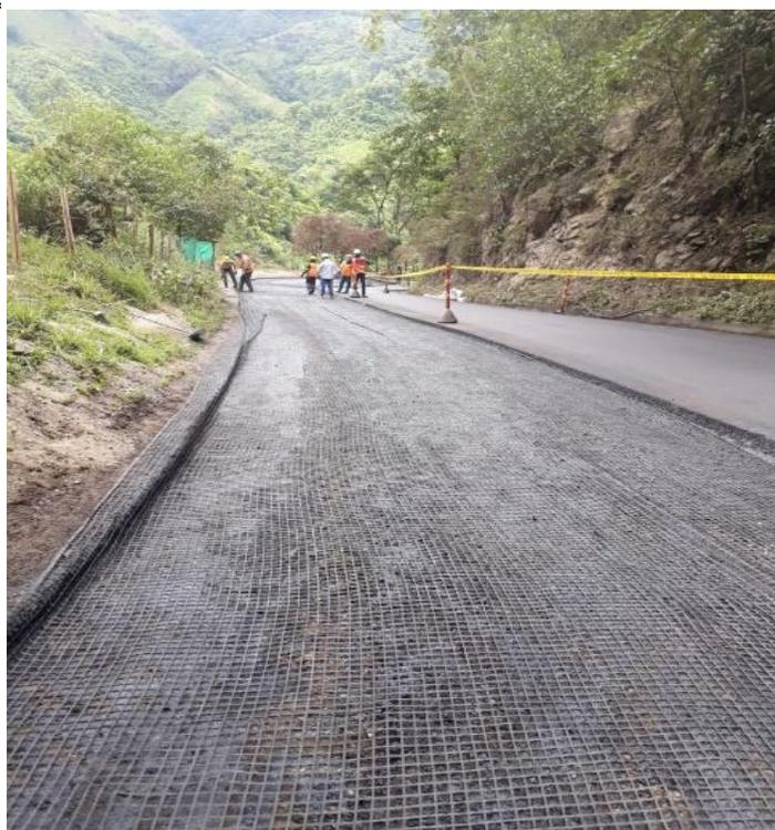
**Figura 7. Geo malla kilómetro 110+900.** |
