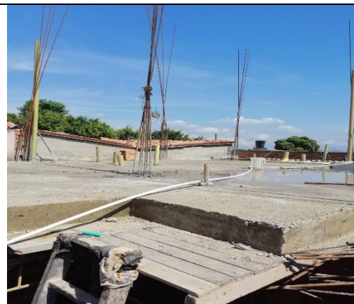
Fundida de placa de entreslo
