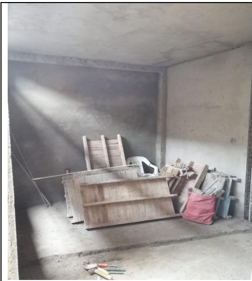
Pañete 1:5 de 1 piso
