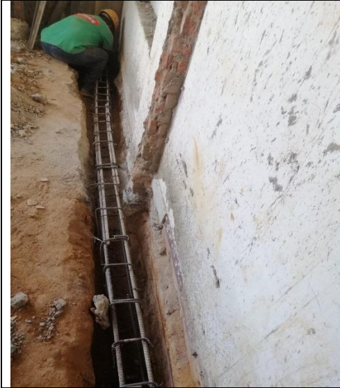
Instalacion de vigas de cimentacion
