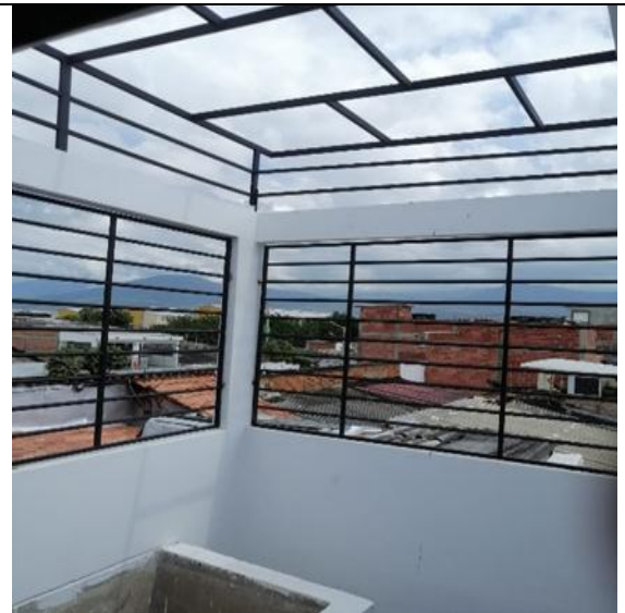
Cubierta de policarbonato
