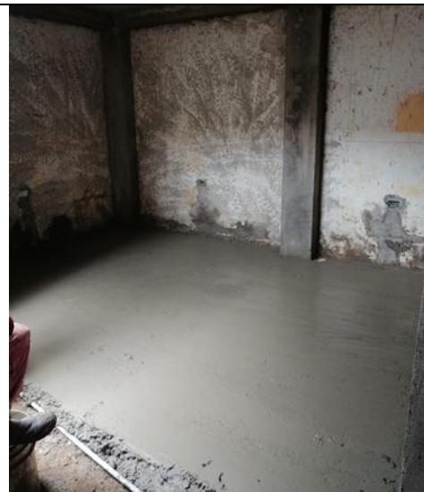
Fundida de la losa
