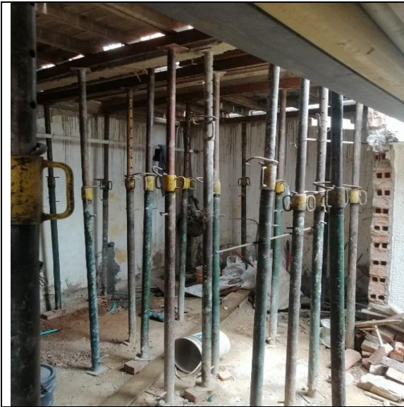
Armado de formaleta para placa
