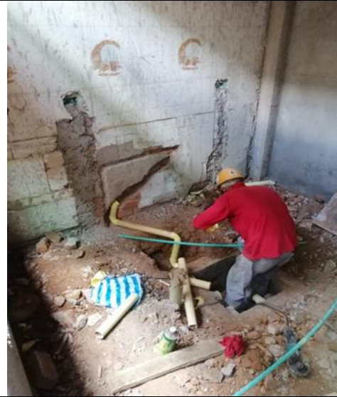
Instalacion de tuberia de cimentacion
