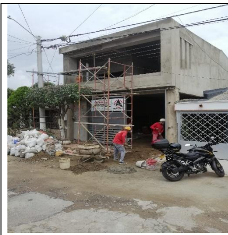
Terminacion en obra negra
