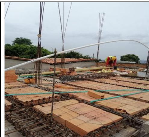
Distribucion de redes: sanitarias, electrica, agua
