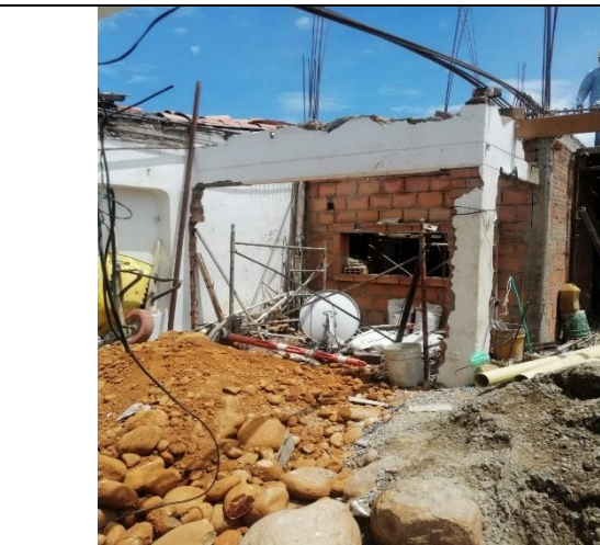
Demolicion de muros
