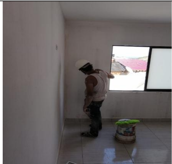
Acabados de pintura
