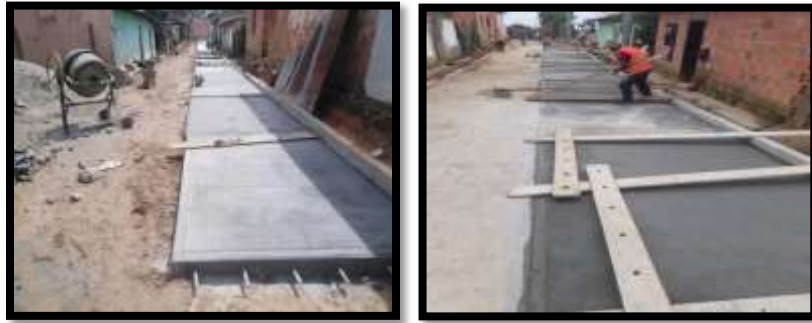
Figura 12. Armado, encofrado y fundida de losas en concreto
