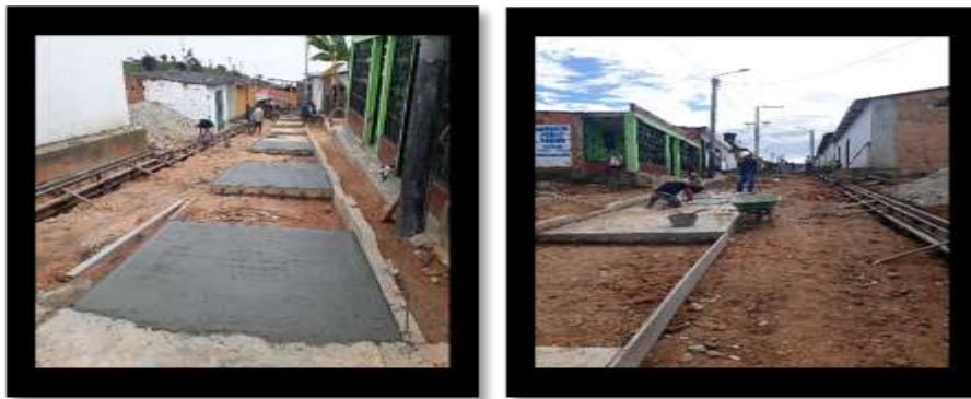
Figura 16. Armado, encofrado y fundida de losas en concreto
