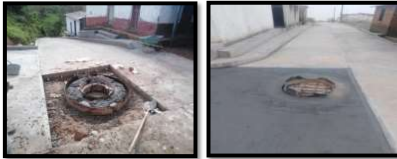
Figura 14. Elaboración y fundida de pozo
