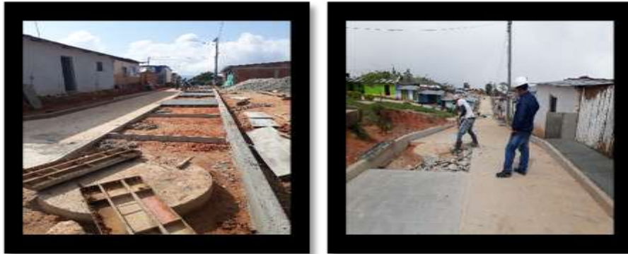
Figura 18. Terminación de losas en concreto y realce de pozos
