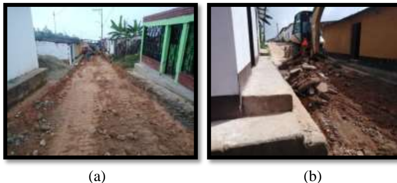
Figura 8. Descapote, limpieza manual y mecánica. (a) tramo 5; (b) tramo 1.
