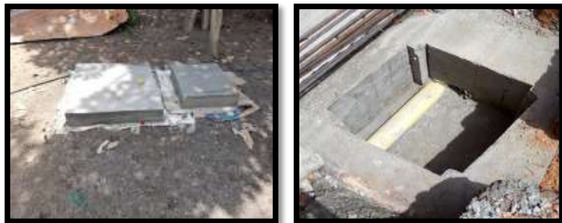
Figura 20. Procedimiento constructivo caja de inspección
