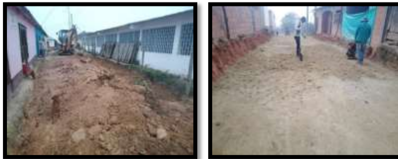
Figura 7. Localización y replanteo. Calles del centro poblado león XIII
