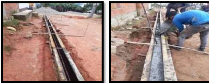
Figura 10. Acero de refuerzo y fundición de sardineles
