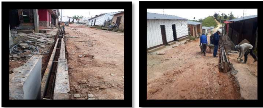
Figura 15. Acero de refuerzo y fundición de sardineles
