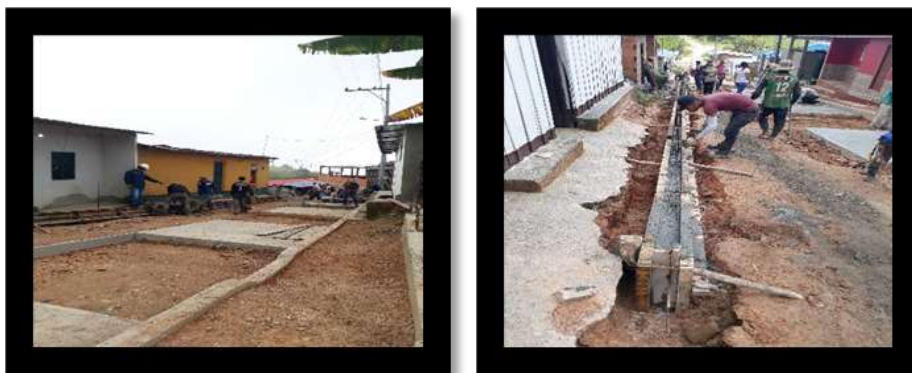
Figura 19. Fundido de sardineles del tramo 5
