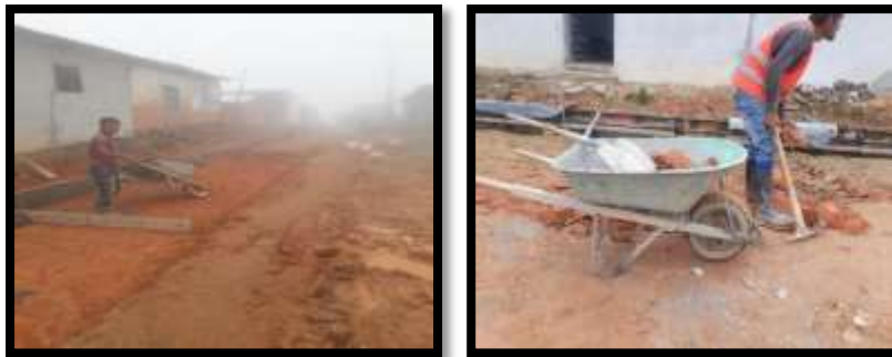
Figura 9. Excavación para la fundición de losas de concreto
