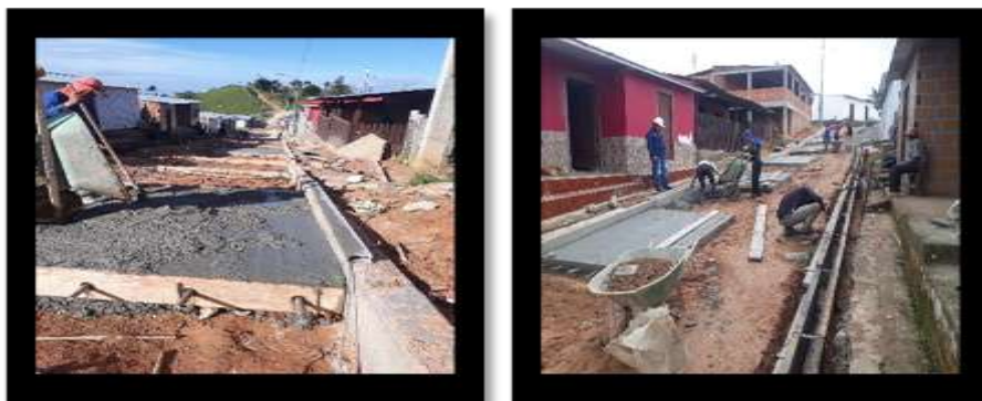
Figura 17. Armado y fundido de losas en concreto de 26 Mpa en forma de ajedrez
