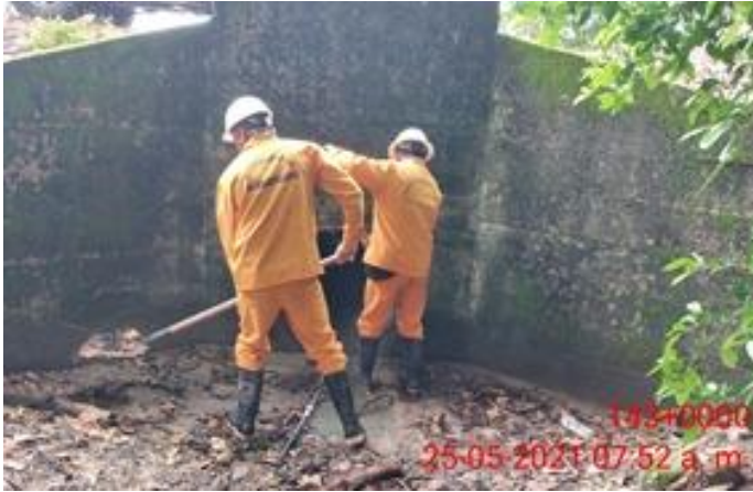
Figura 9. Actividad limpieza en encole y/o descole. Fuente: COOTRASCUB
