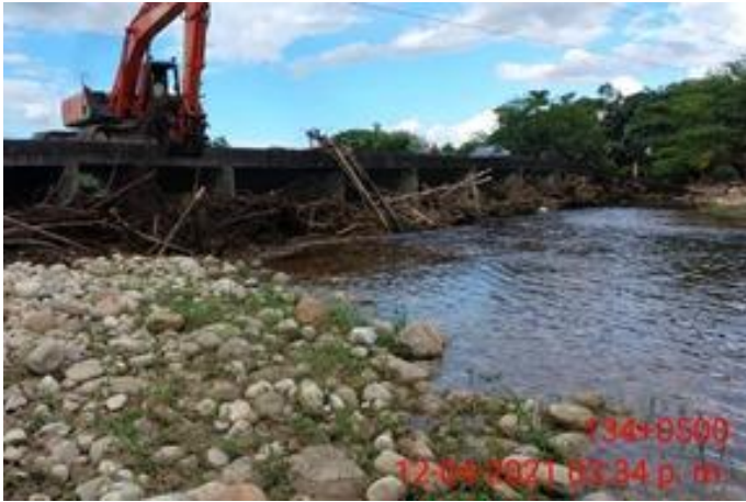
Figura 11. Actividad mantenimiento de puentes y pontones. Fuente: COOTRASCUB
