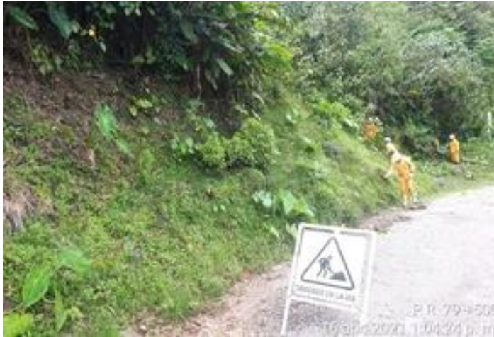
Figura 12. Actividad rocería y desmonte manual. Fuente: COOTRASMEZA
