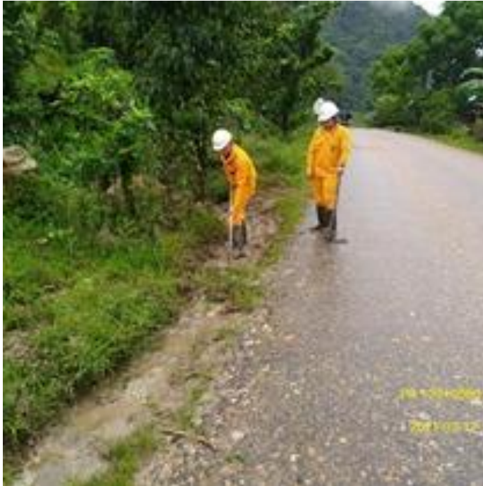
Figura 8. Actividad limpieza manual de cunetas. Fuente: COOTRASEMULPAC
