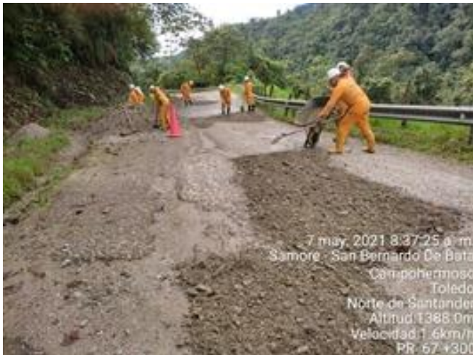
Figura 14. Actividad bacheo en la vía. Fuente: COOTRASMEZA
