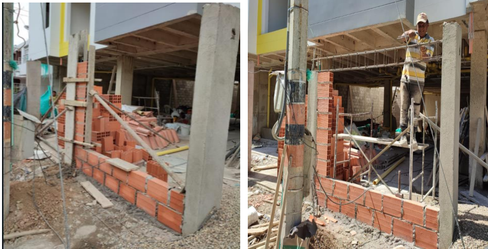
Figura 41. Fundición de columnas y viga corona
