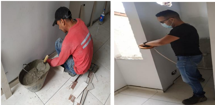
Figura 13. Instalación de guarda escoba en apartamentos
