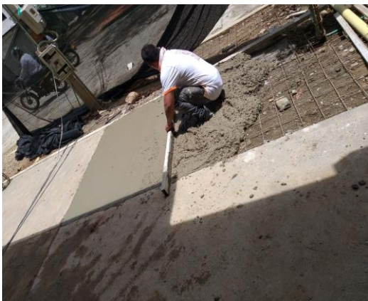
Fundición de pisos de parqueadero y paso peatonal
