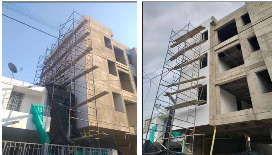
Figura 26. Aplicación de pasta en fachada
