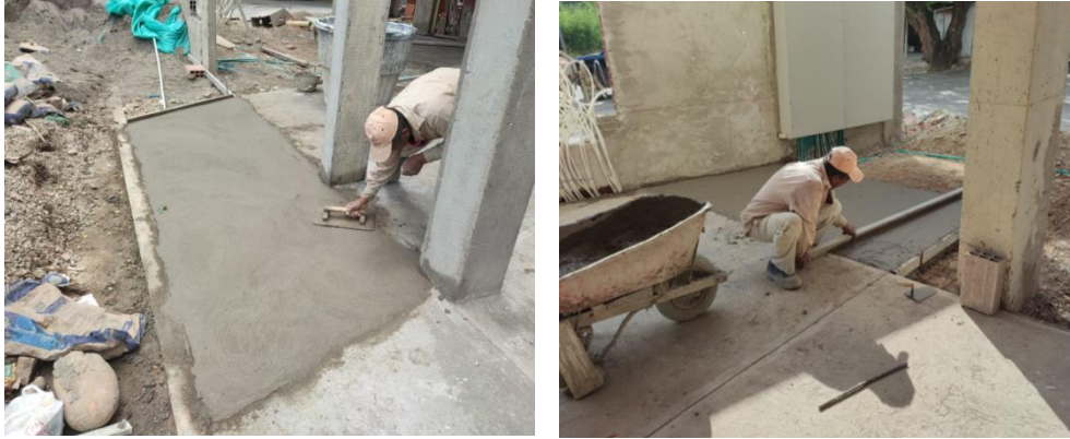
Figura 9. Nivelación del concreto con codal de aluminio
