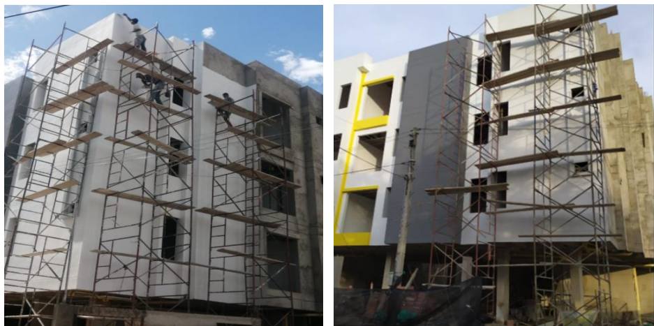
Figura 29. Pasta y pintura en fachada
