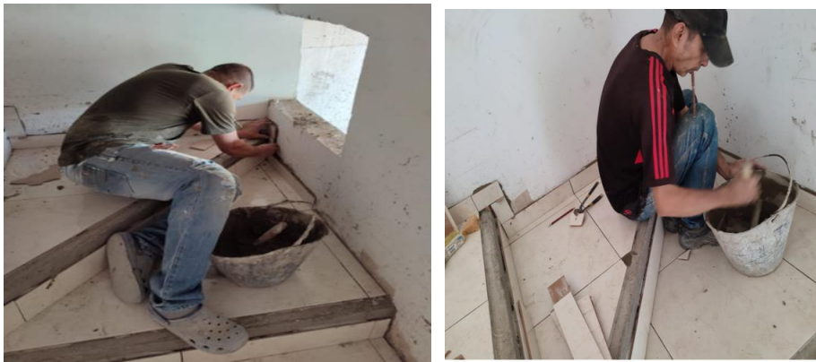
Figura 52. Enchape de guarda escoba a escaleras
