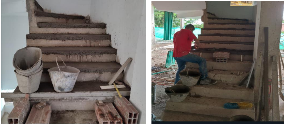
Figura 49. Afinado de escaleras
