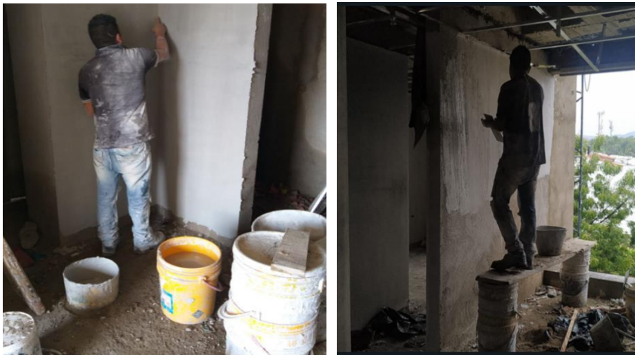
Figura 18. Aplicación de estuco
