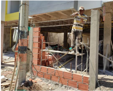
Figura 44. Muro en bloque para cerramiento
