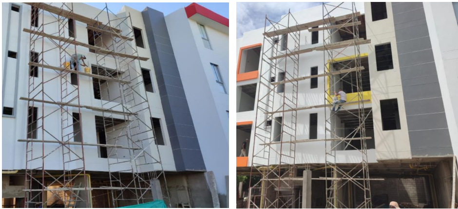
Figura 31. Pasta y pintura en fachada
