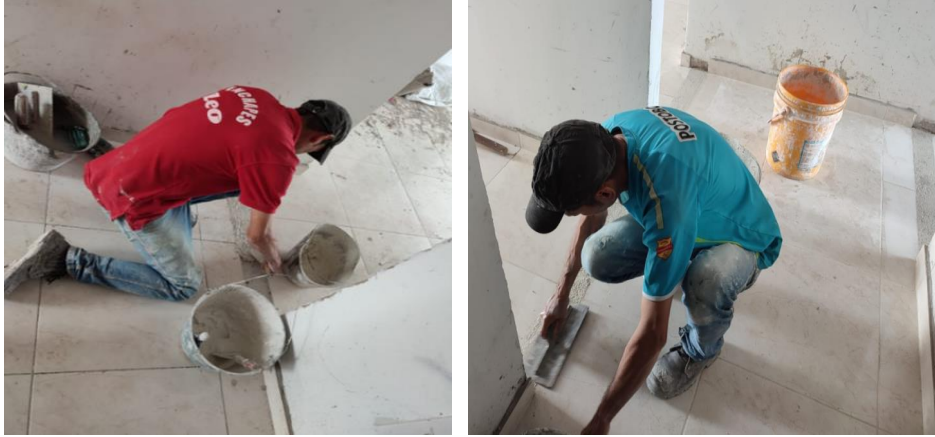
Figura 53. Aplicación de granito en franjas de puertas
