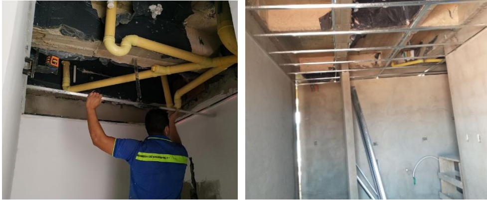
Figura 34. Instalación de estructura para Drywall
