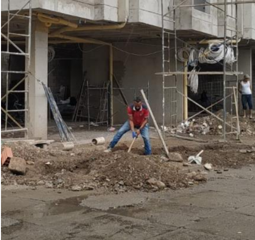
Figura 36. Excavación para zapatas
