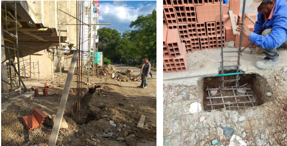
Figura 38. Fundición de zapatas en concreto
