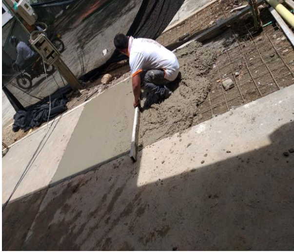
Figura 3. Fundición de losa en concreto e=10cm
