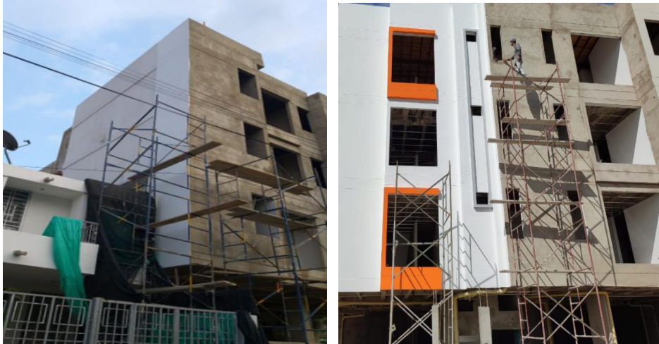
Figura 32. Desarme de andamios
