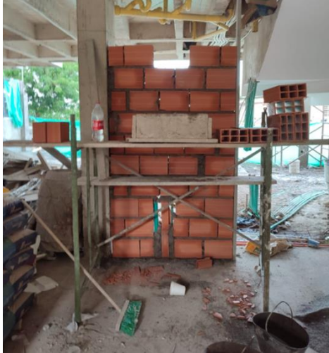
Figura 43. Muro en bloque para ubicar caja de paso
