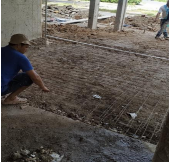
Figura 2. Postura de malla electrosoldada
