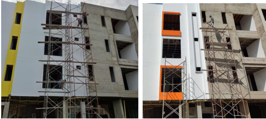
Figura 30. Pasta y pintura en fachada
