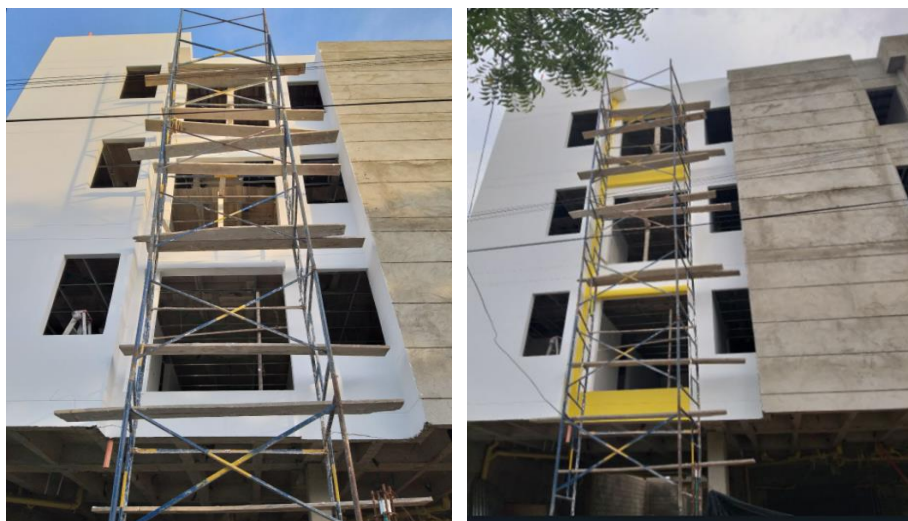
Figura 27. Pasta y pintura en fachada
