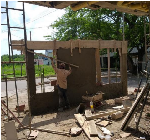
Figura 46. Empañetado de muros
