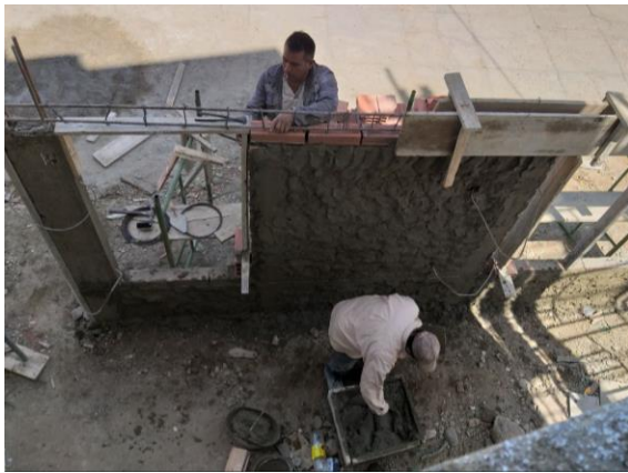
Figura 40. Fundición de viga corona
