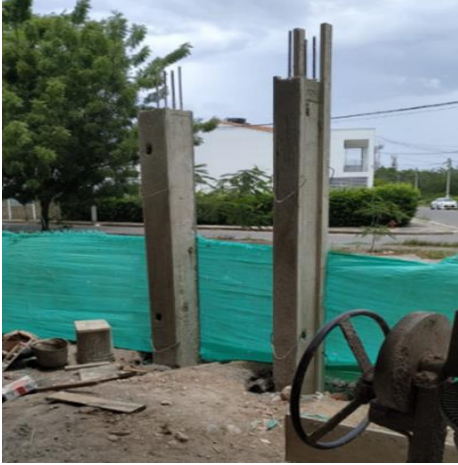
Figura 47. Pañete lineal en columnas
