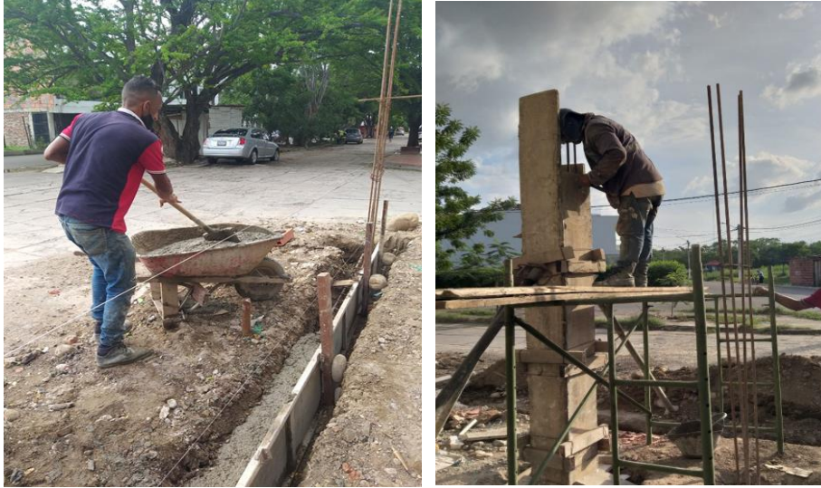
Figura 39. Fundición de viga y columnas
