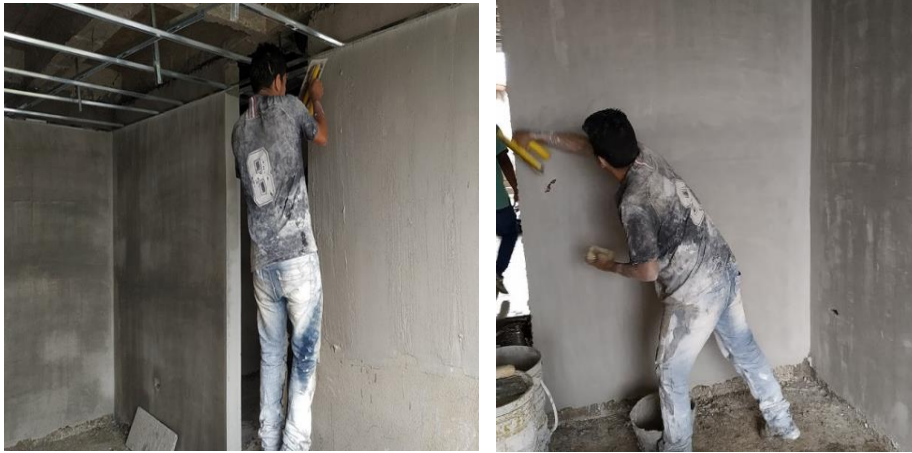
Figura 17. Aplicación de estuco en muros
