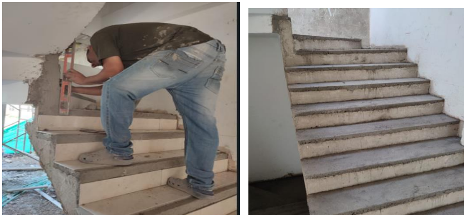
Figura 50. Afinado de escaleras
