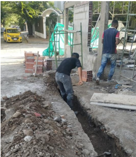
Figura 37. Excavación para sardinel
