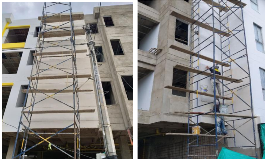
Figura 28. Pasta y pintura en fachada
