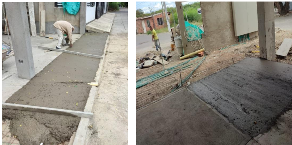
Figura 5. Fundición de piso en concreto para parqueadero
