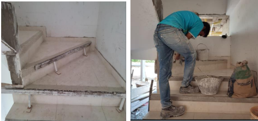
Figura 54. Aplicación de granito es escalones
