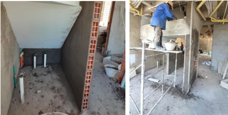
Figura 48. Empañetado de muros y filos
