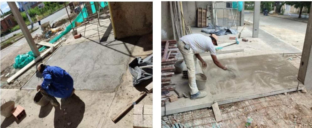
Figura 8. Texturizado a losa de concreto
