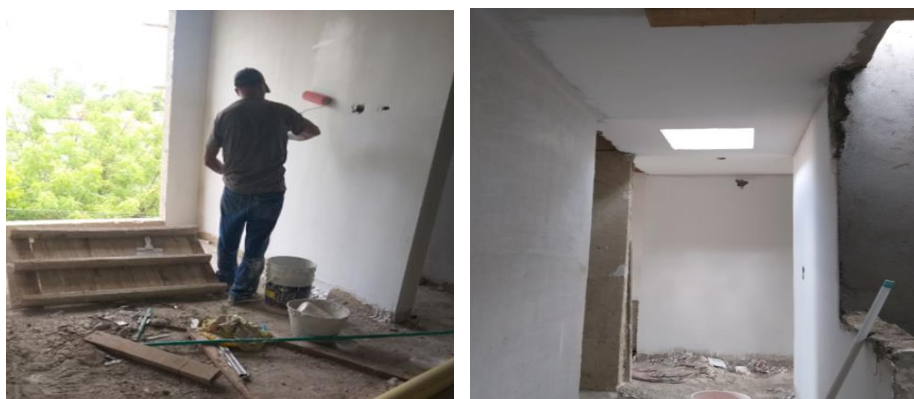
Figura 22. Primera mano de pintura en muros
