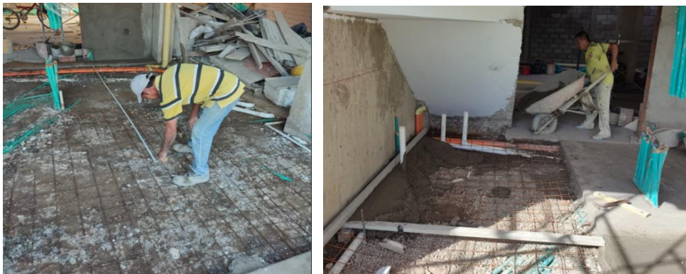
Figura 4. Fundición de piso en concreto e=10cm
