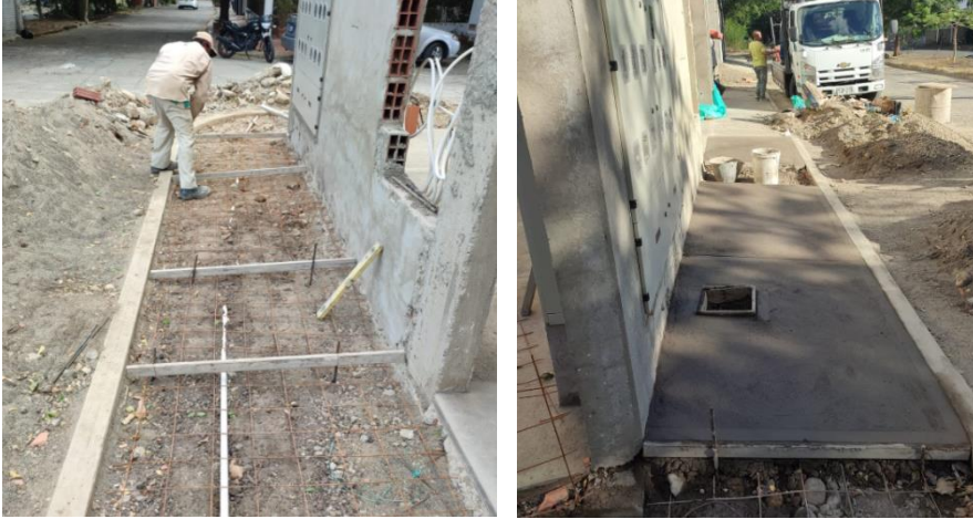
Figura 7. Fundición de piso para paso peatonal
