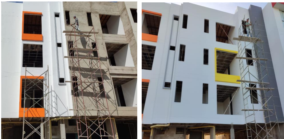
Figura 33. Desarme de andamios
