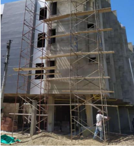
Figura 25. Armado de 2 torres de andamios
