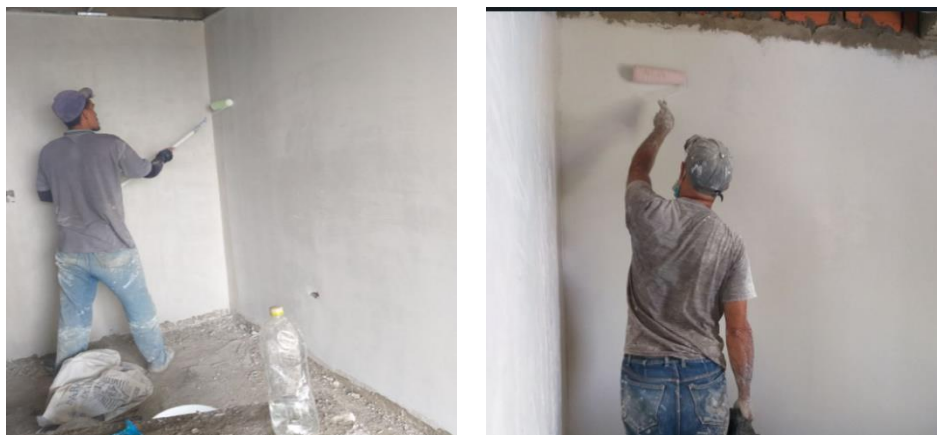
Figura 21. Primera mano de pintura en muros
