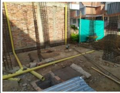
Conexión de tubería a cajas de inspección.
