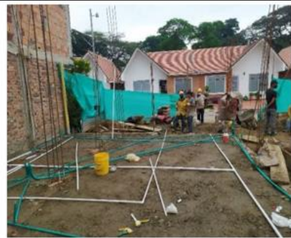
Instalacion de tuberia electrica y sanitaria.
