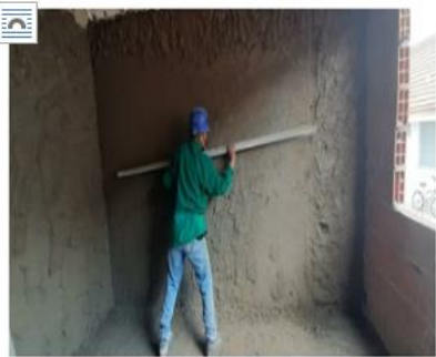
Pañete en muros.
