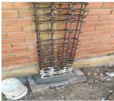
Fundida de pedestal, y cubrida de relleno.
