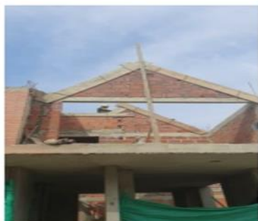
Encofrado de viga cinta.
