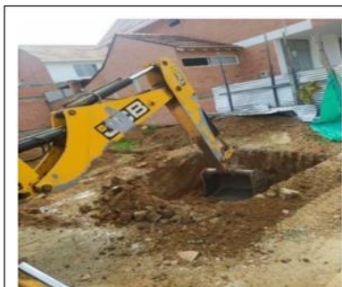
Excavacion de tanque subterraneo.
