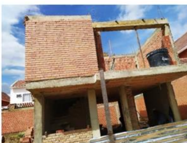
Encofrado viga corona.
