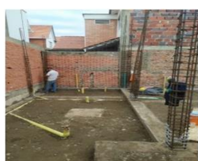
Instalacion de tuberia sanitaria.
