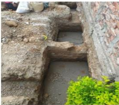
Solado de zapata.
