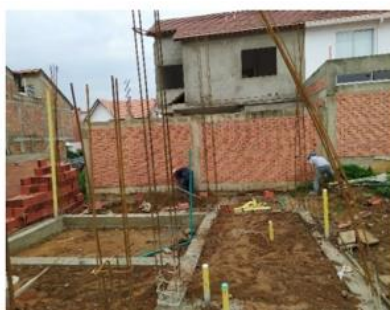
Viga de cimentacion fundida.
