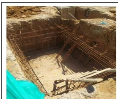
Armado de hierro de paredes tanque subterraneo.
