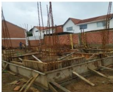
Encofrado de vigas de cimentacion.
