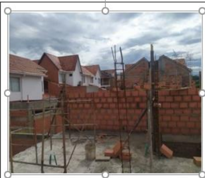
Mamposteria en bloque segundo piso.
