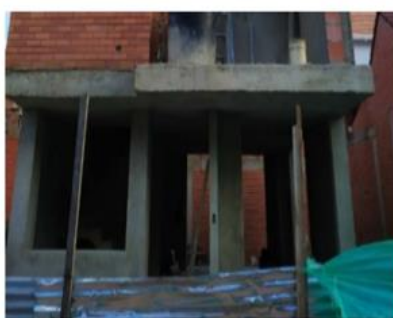
Pañete de primer piso muros y placa.
