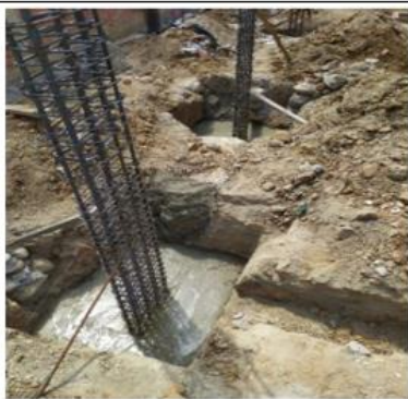
Concreto de zapata.
