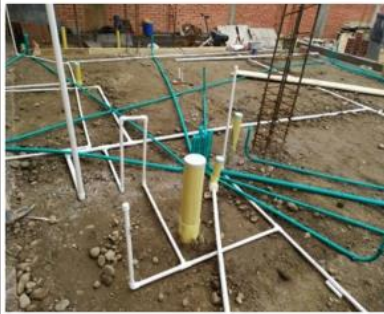
Instalación de tubería hidráulica.
