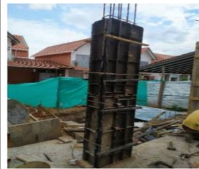
Encofrado de columnas.
