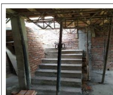
Desencofrada de escalera.
