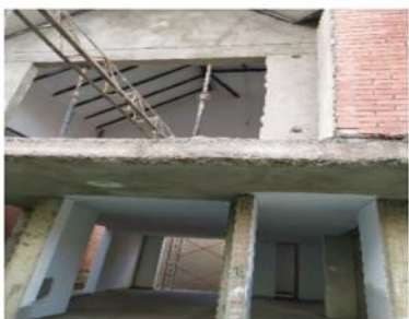
Aplicación de estuco.
