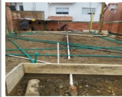
Tubería eléctrica.
