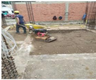
Compactacion de rellenos.
