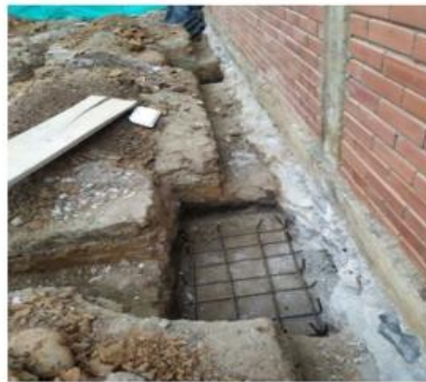
Parilla para zapata.
