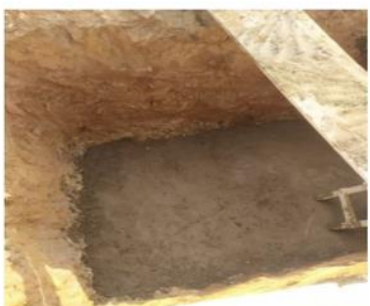
Solado de tanque subterraneo.
