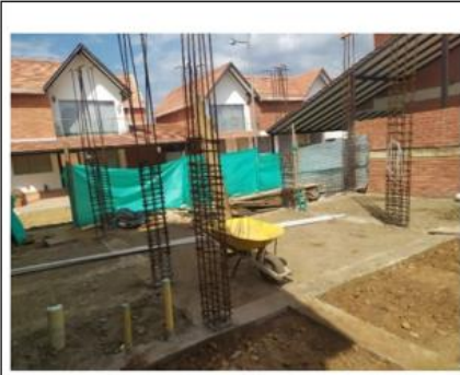
Aplicación de relleno de porticos.
