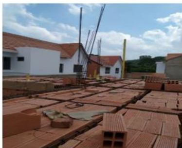
Instalacion de tuberia y bloque.
