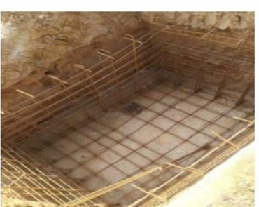
Armada de hierro piso tanque subterraneo.
