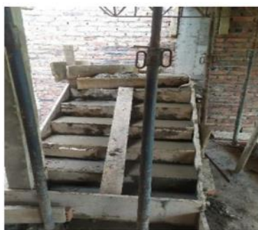
Fundida de primer tramo de escalera.
