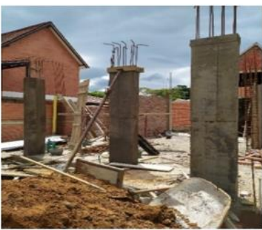
Vaciado y desencofrado de columnas.
