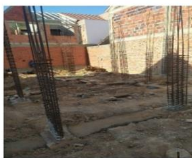
Armado de columnas.
