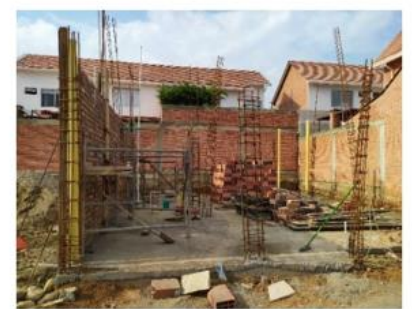
Mamposteria en ladrillo de obra primer piso.
