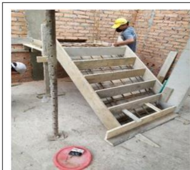
Encofrada de escalera.
