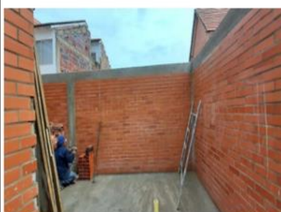
Mamposteria en ladrillo limpio primer piso.
