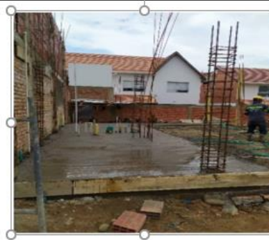
Fundida de losa de cimentacion.
