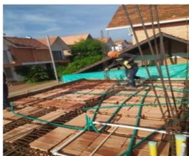
Riego de agua para empezar a fundir vigas y viguetas.
