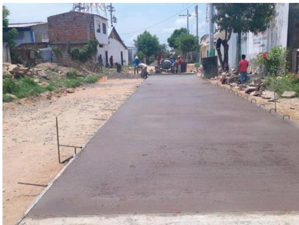
**Figura 7. Fundida de losa de concreto**
