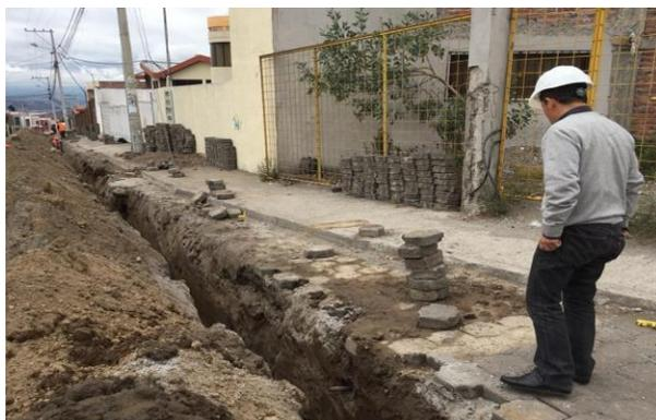
**Figura 2. Excavación que alojara a las guarniciones**
