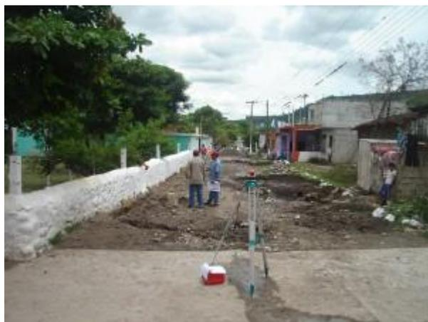
**Figura 1. Trazo y nivelación marcando ejes de referencia**
