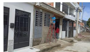
Resolución 3. Se observa personal de trabajo sin cumplir con las medidas mínimas de protección.
