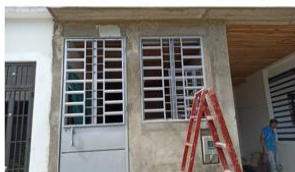
Resolución 2. Se detectó una apertura visual desde existe una obstrucción visual.
