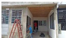
Resolución 1. Se observó una obra en movilidad cerramiento.
