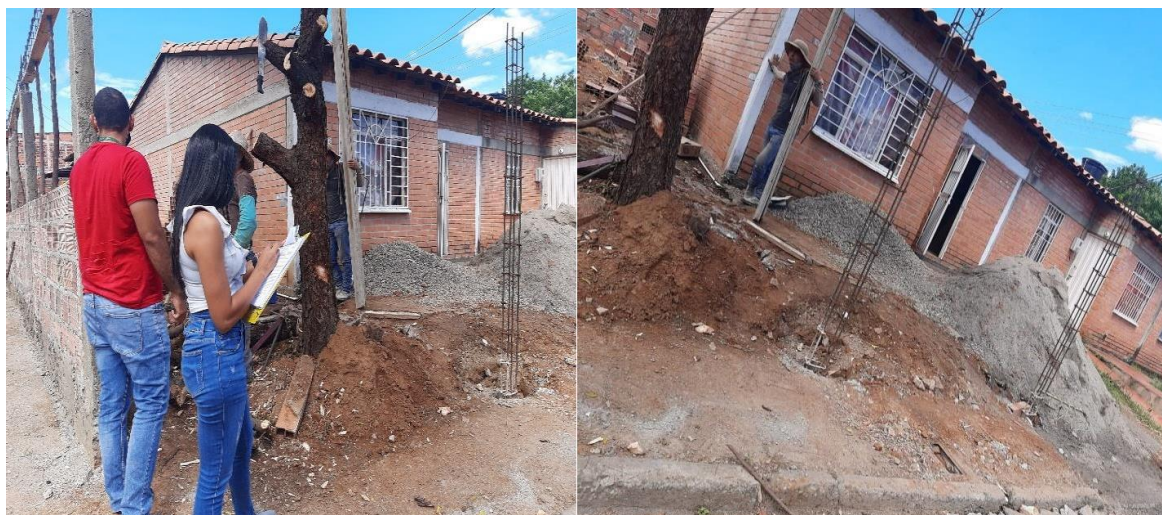
Figura 29. Realización de visita de inspección ocular
