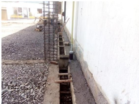
**Figura 48. Viga auxiliar totalmente vaciada de concreto.**
