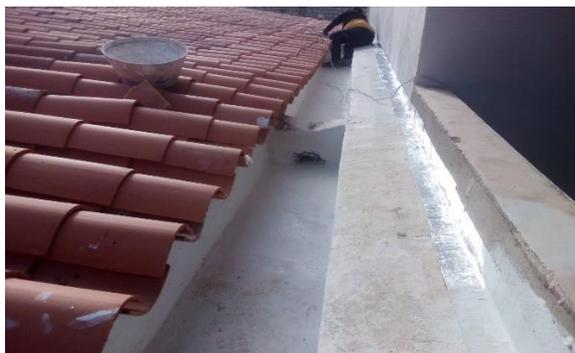
**Figura 94. Impermeabilización de viga canal**
