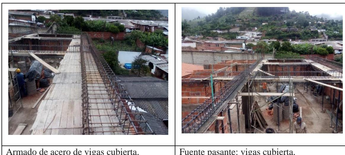
**Figura 69.** Armado de acero de vigas cubierta
