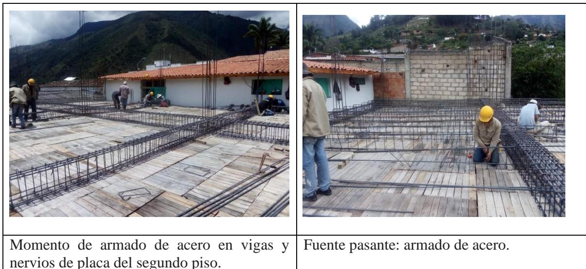
**Figura 57. Momento de armado de acero en vigas y nervios de placa del segundo piso.**
