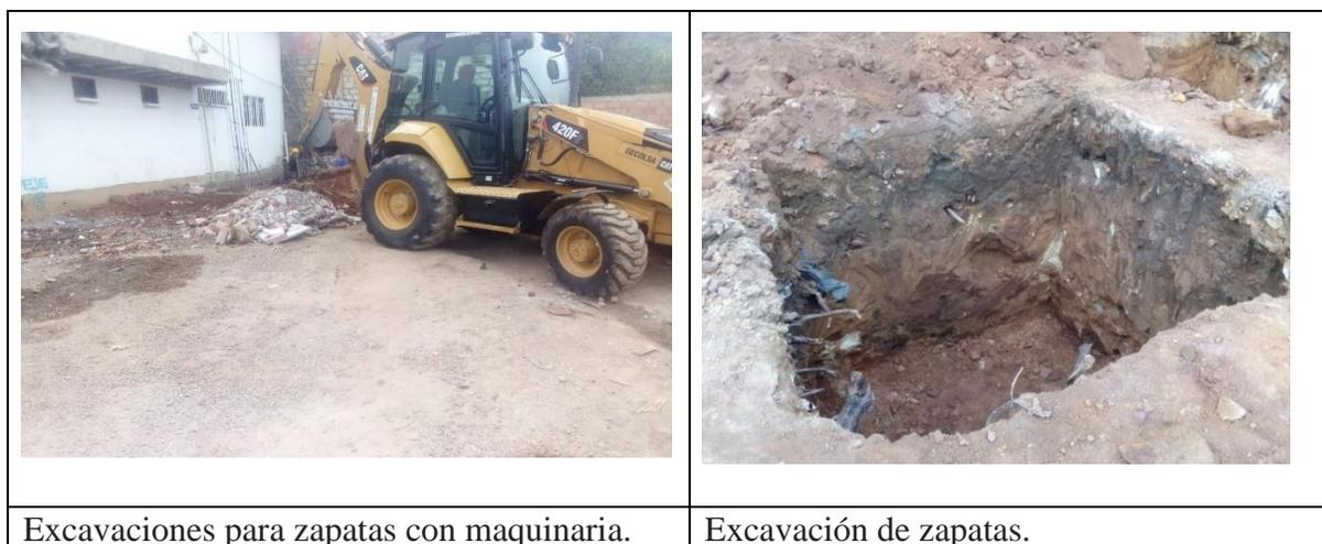
**Figura 27. Excavaciones para zapatas**
