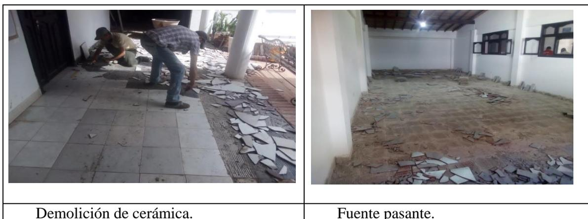
**Figura 105. Demolición de cerámica**
