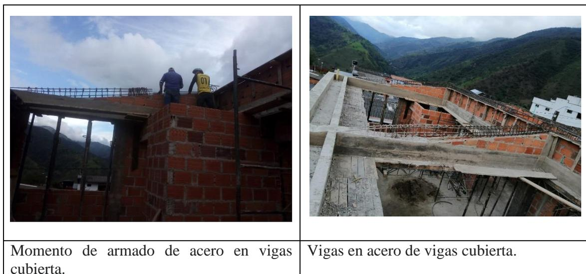
**Figura 75. Momento de armado de acero en vigas cubierta**
