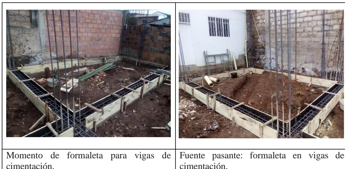
**Figura 40. Instalación de formaletas**
