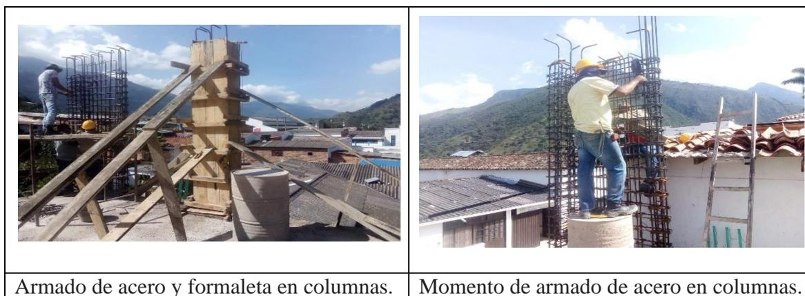
**Figura 61. Armado de acero y formaleta en columnas**
