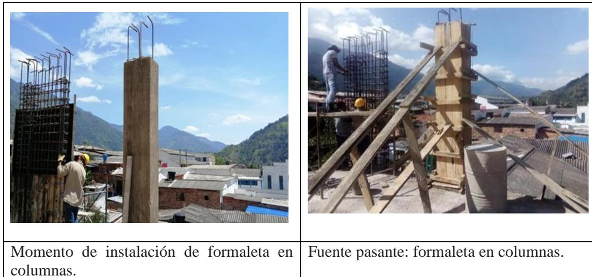
**Figura 62. Momento de instalación de formaleta en columnas**
