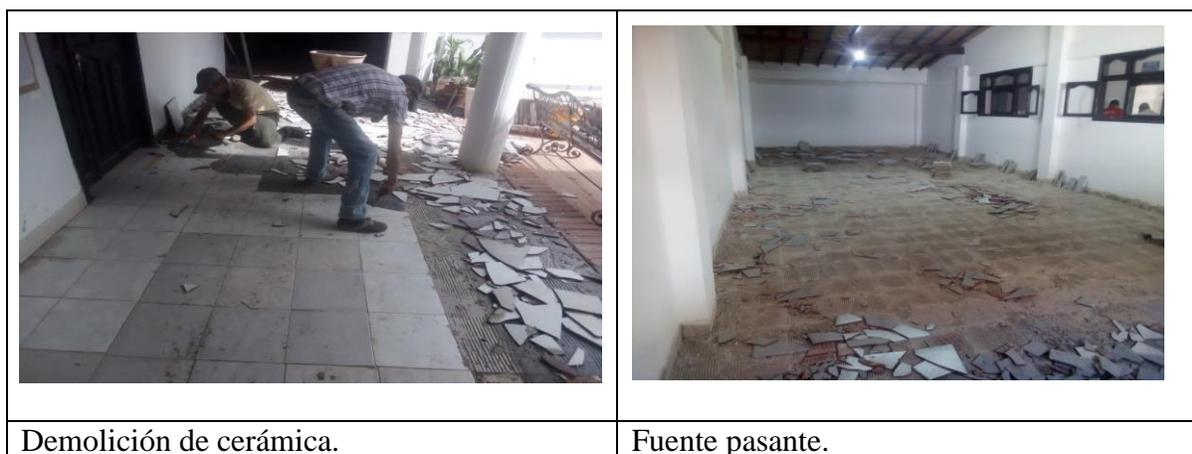
**Figura 107. Demolición de cerámica**
