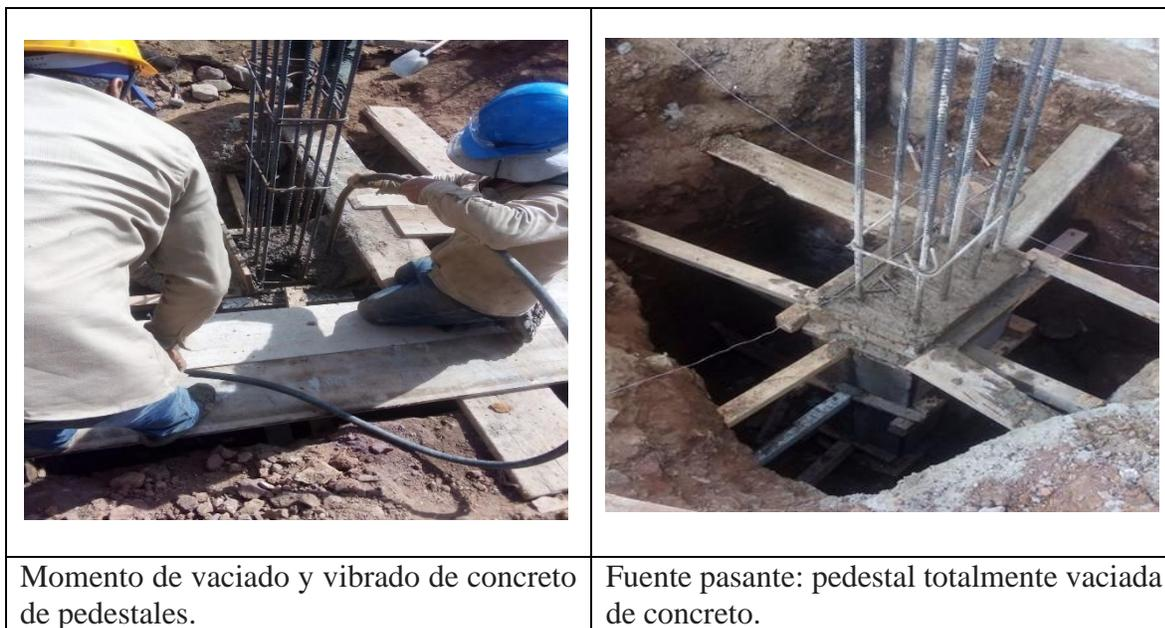
**Figura 33. Vaciado de concreto para pedestales**
