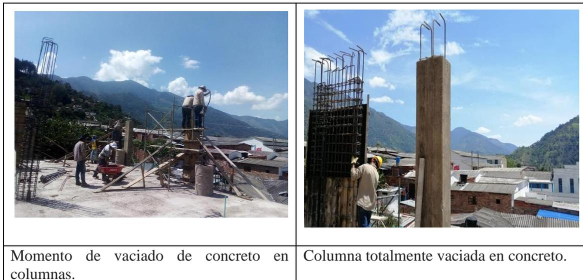
**Figura 63. Momento de vaciado de concreto en columnas**
