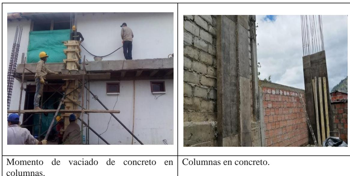
**Figura 50. Vaciados de concreto**
