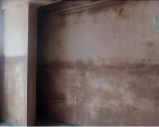
**Figura 89. Estuco para muros interiores**
