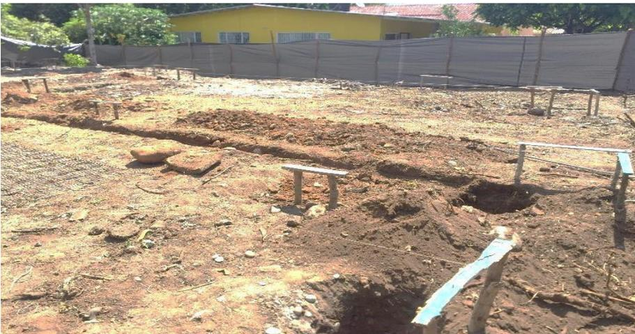
**Figura 3. Excavaciones para las vigas de cimentación y las zapatas de la vivienda**
