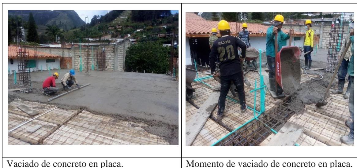
**Figura 60. Vaciado de concreto en placa**
