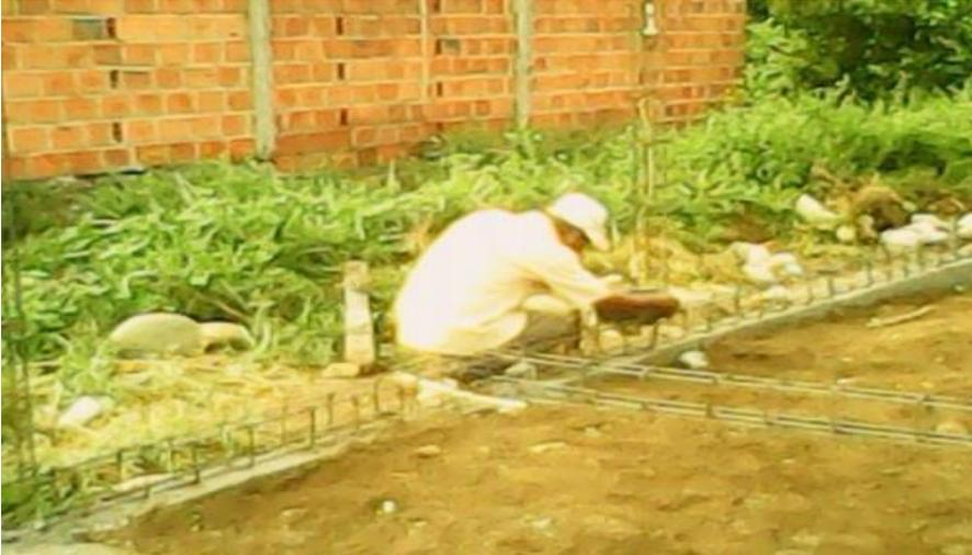
**Figura 5. Construcción de las vigas de cimentación**
