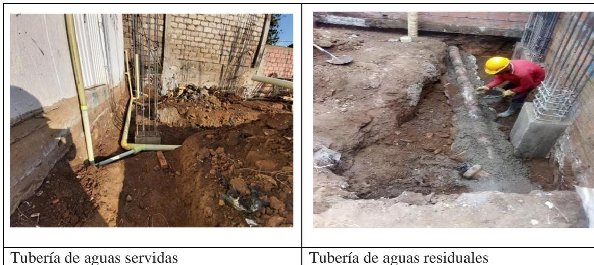
**Figura 37. Tubería de aguas servidas y residuales**
