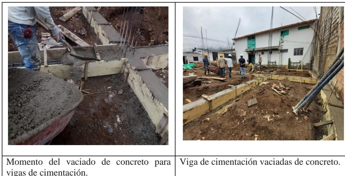
**Figura 41. Momento del vaciado de concreto para vigas de cimentación**
