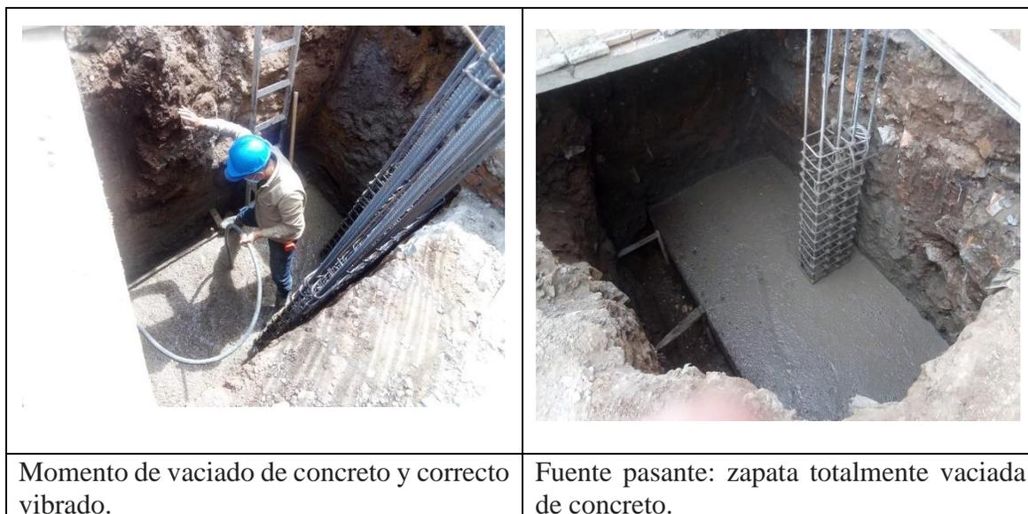
**Figura 31. Vaciado de concreto para Zapatas**
