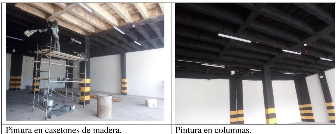
**Figura 95. Pintura para casetones de madera y columnas del parqueadero**
