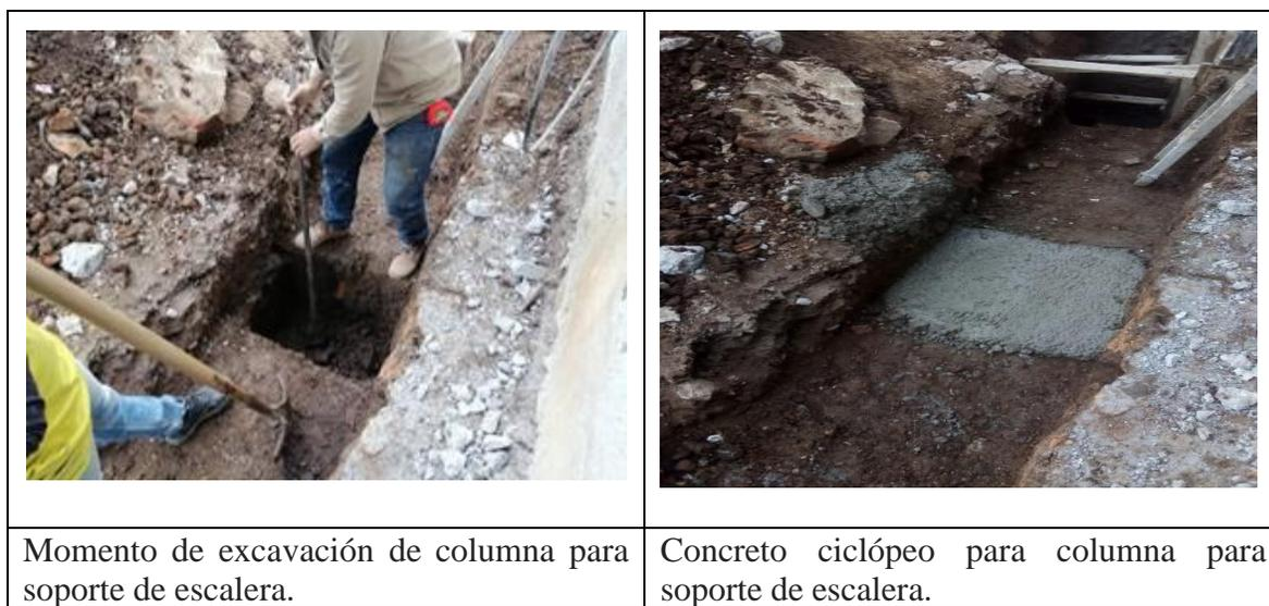
**Figura 44. Momento de excavación de columna para soporte de escalera**
