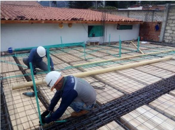
**Figura 59. Instalación de tubería eléctrica a cargo del ingeniero eléctrico**
