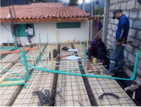
**Figura 58. Instalación de tubería a cargo del plomero.**
