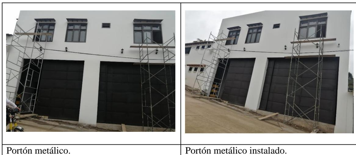
**Figura 104. Instalación de portón metálico**
