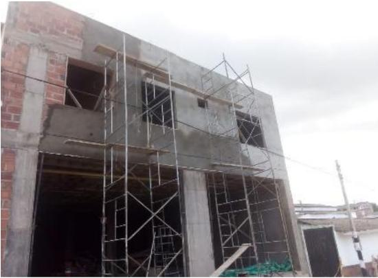
**Figura 86. Pañete sobre muros exteriores**
