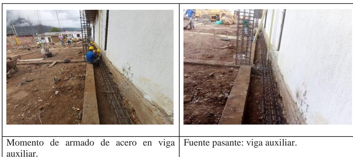
**Figura 45. Armado de acero**
