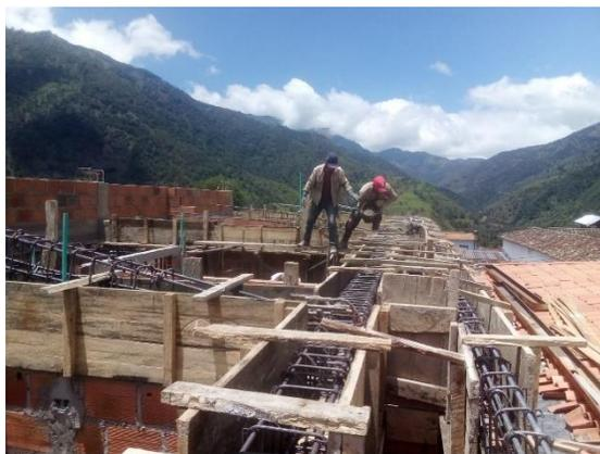
**Figura 76. Formaleta para vigas cubierta**
