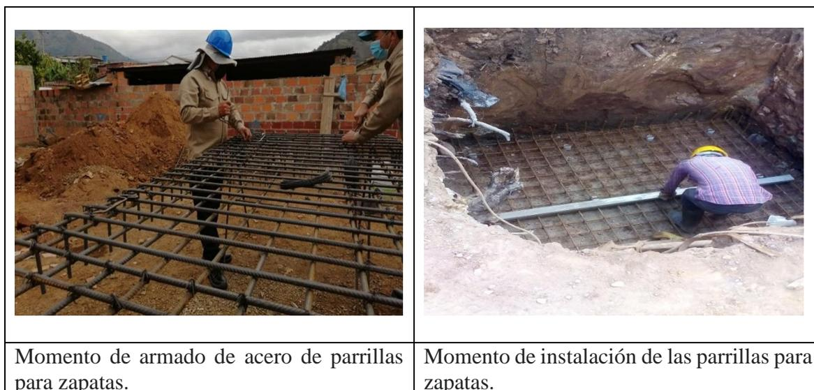
**Figura 24. Armado de acero para Zapatas**
