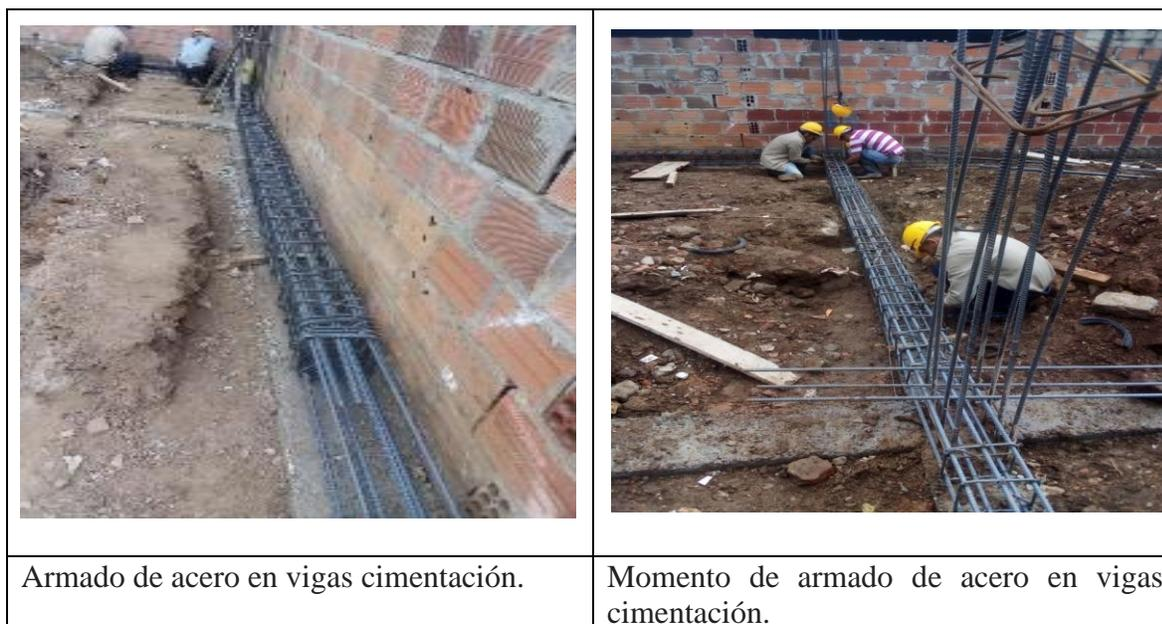
**Figura 39. Armado de acero en vigas cimentación**
