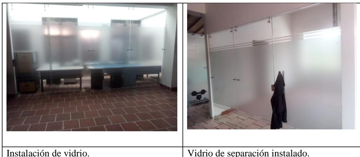
**Figura 103. Instalaciones de separaciones en vidrio**
