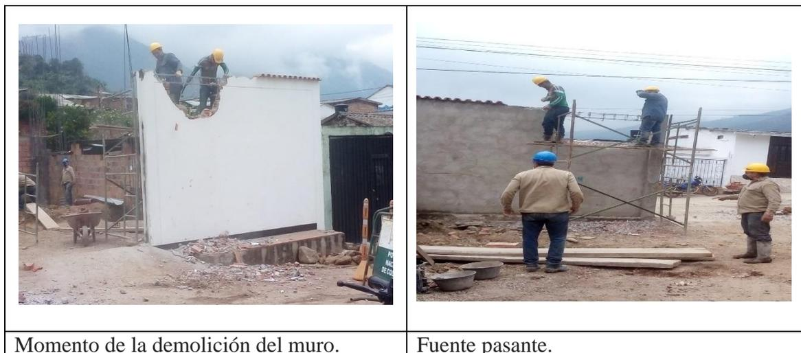
**Figura 26. Demolición del portón y muro de fachada**
