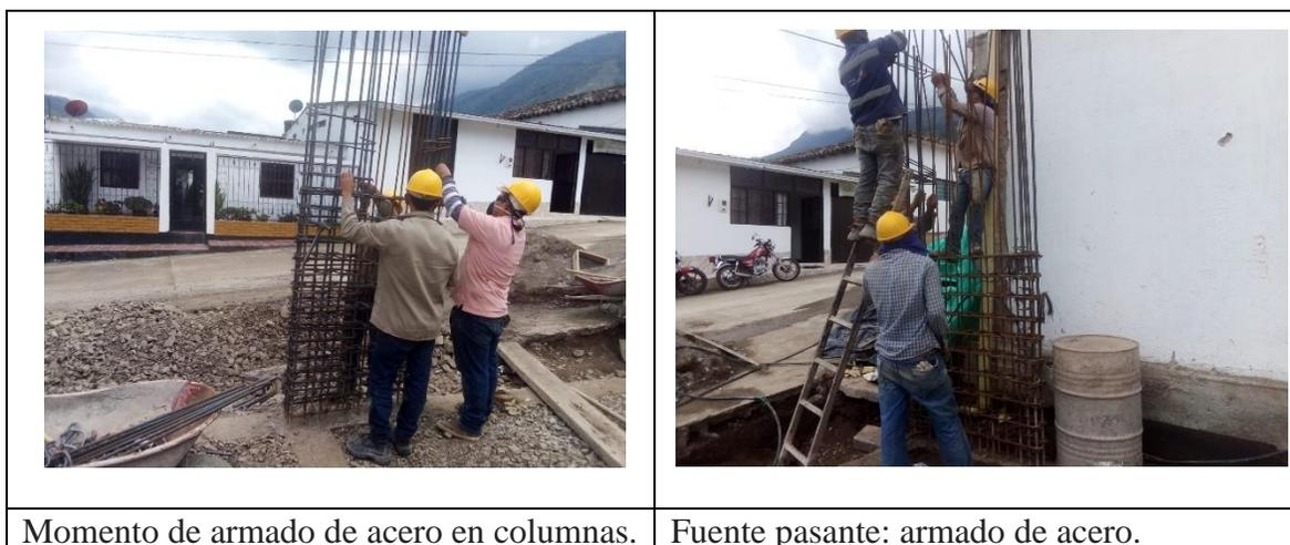
**Figura 46. Armado de acero en columnas**
