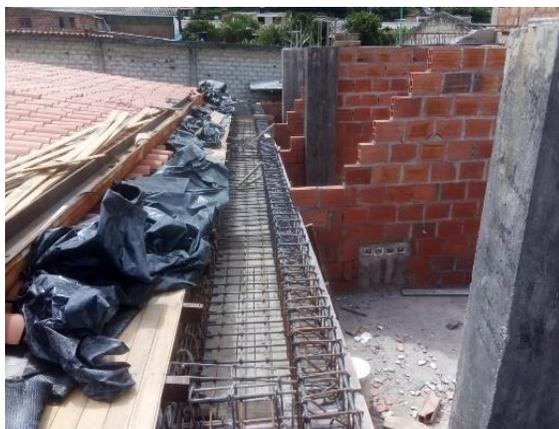
**Figura 67. Viga canal armada en acero**
