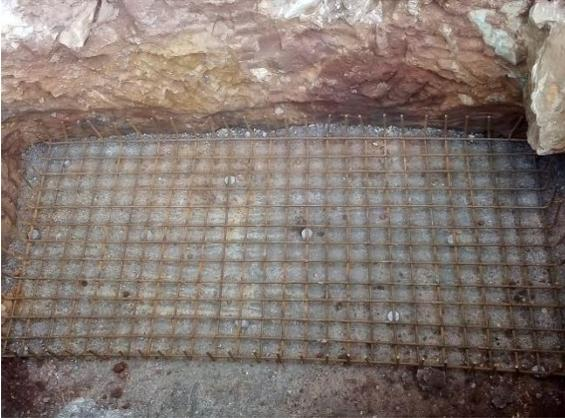
**Figura 29. Momento de instalación de las parrillas para zapatas**
