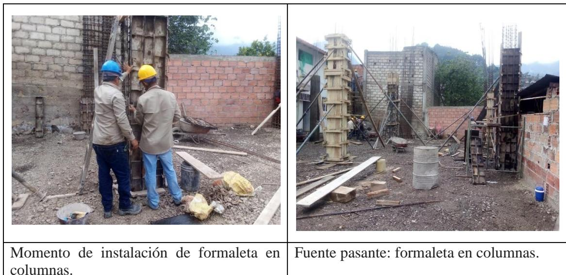
**Figura 49. Instalación de formaletas**
