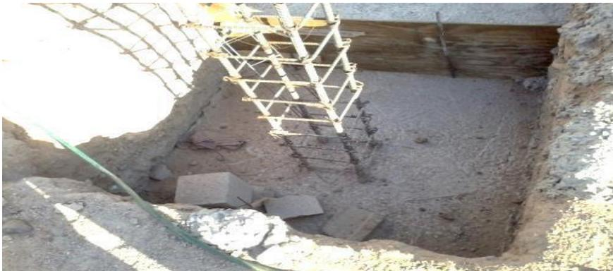
**Figura 4. Construcción de las zapatas**
