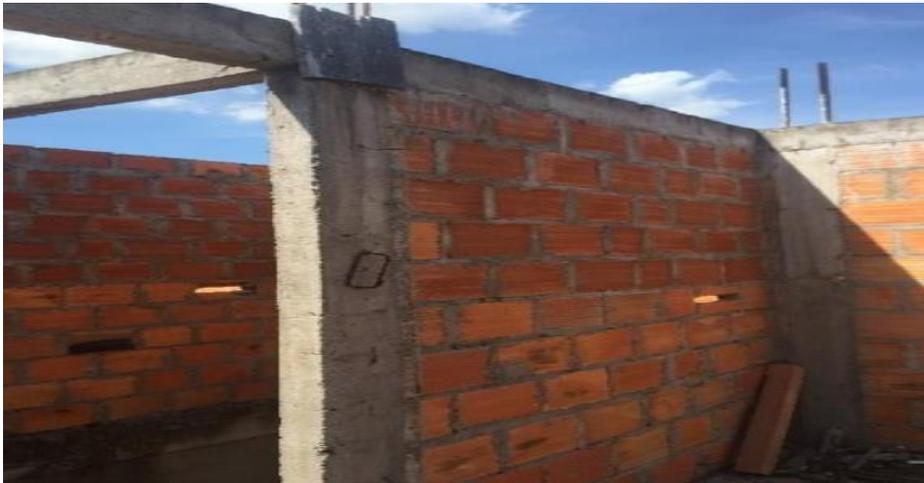
**Figura 7. Columnas se realizan en concreto**
