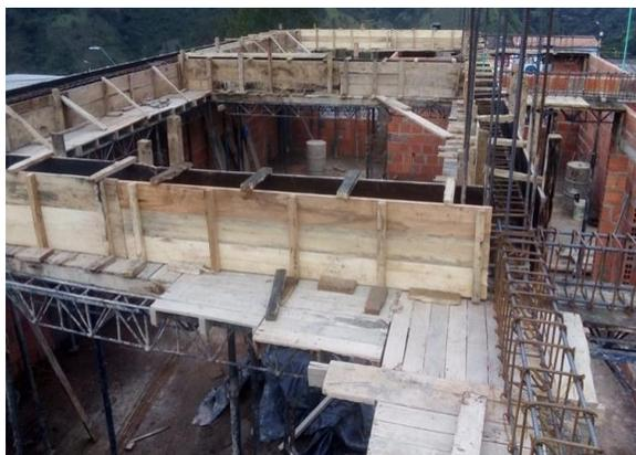
**Figura 70. Formaleta para vigas cubierta**
