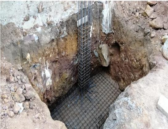
**Figura 30. Momento de instalación de la columna**
