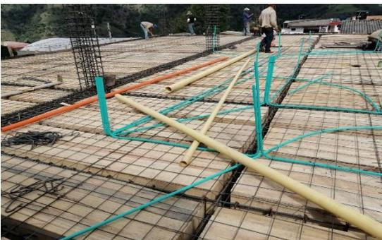
**Figura 81. Tubería eléctrica**
