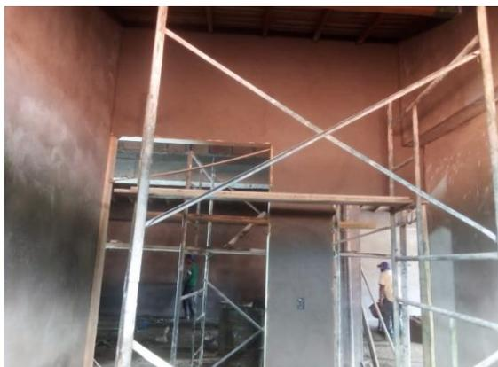
**Figura 83. Pañete sobre muros interiores**
