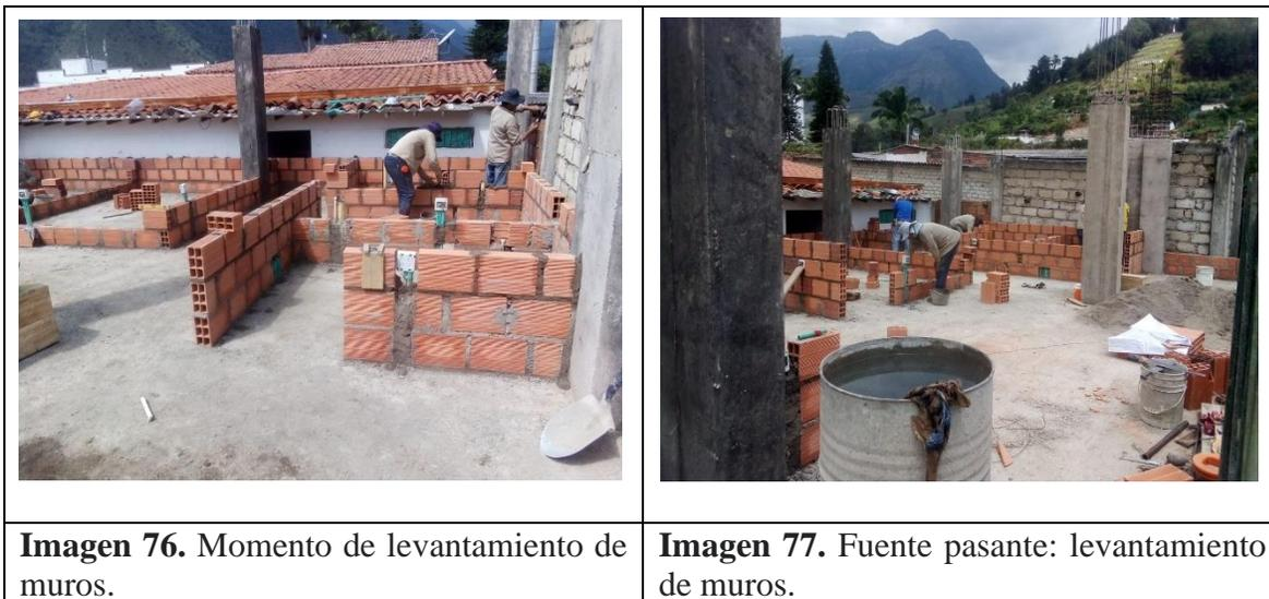
**Figura 65.** Momento de levantamiento de muros.
