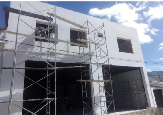
**Figura 92. Pasta para muros exteriores**
