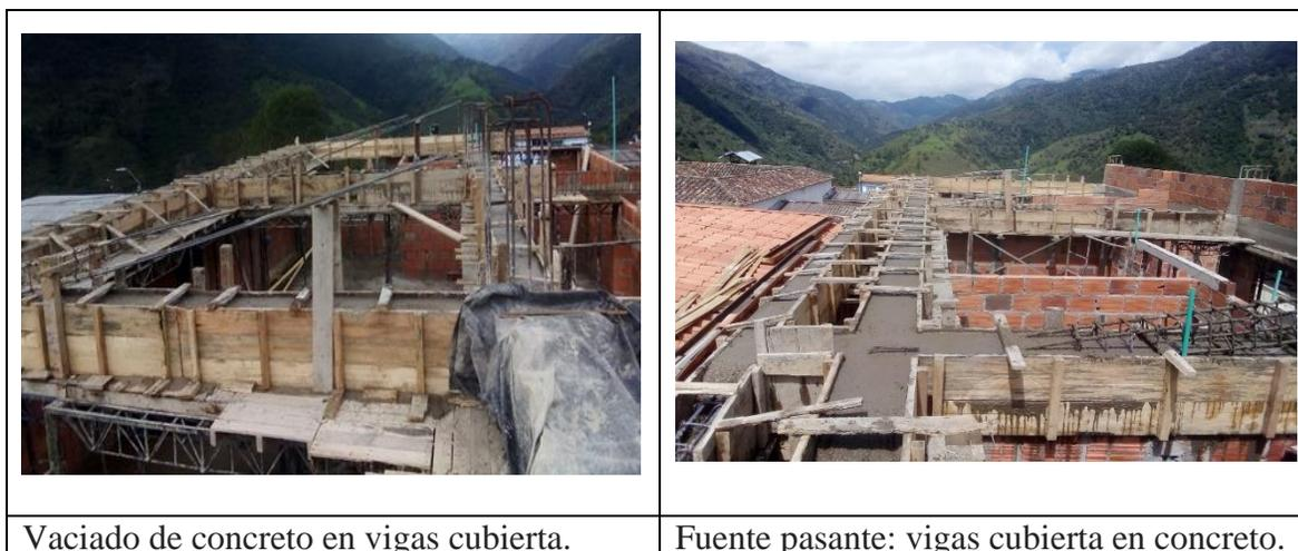
**Figura 71. Vaciado de concreto en vigas cubierta**
