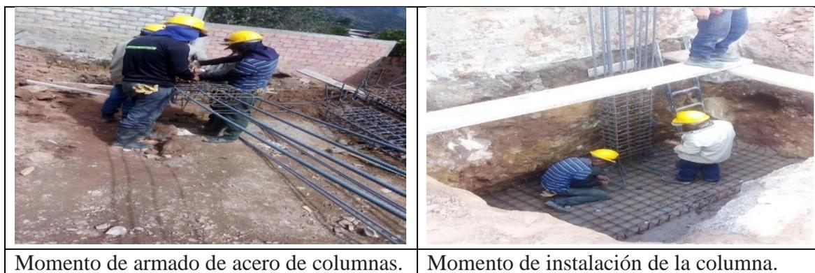
**Figura 25. Armado de acero para Columnas**
