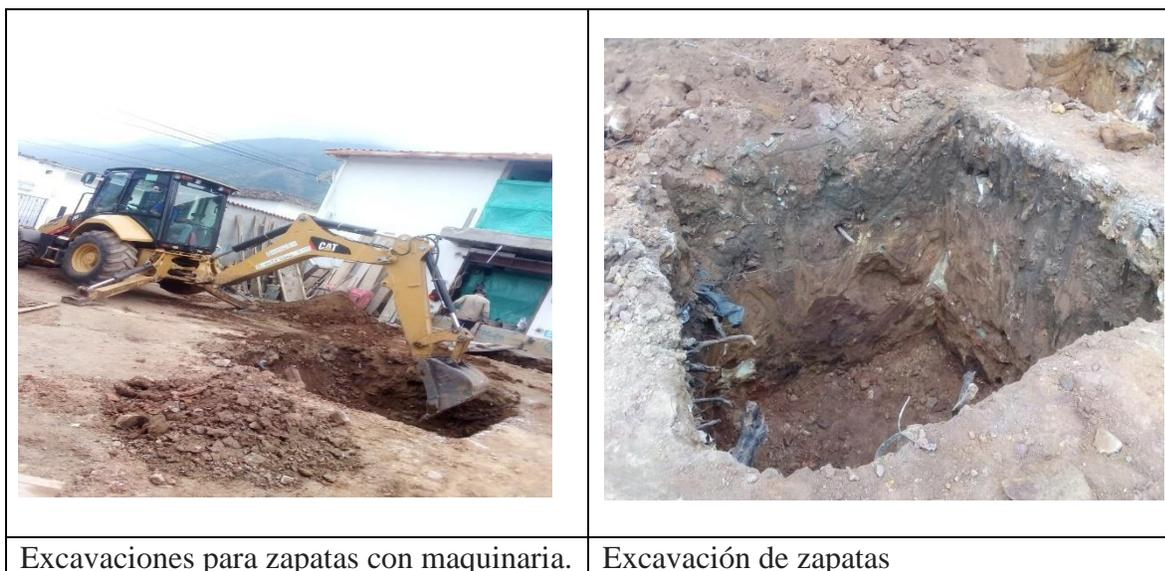
**Figura 22. Excavaciones para zapatas**
