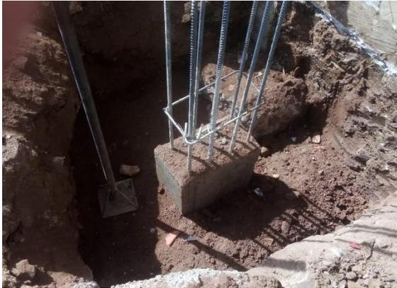
**Figura 34. Momento del relleno con material de excavación**
