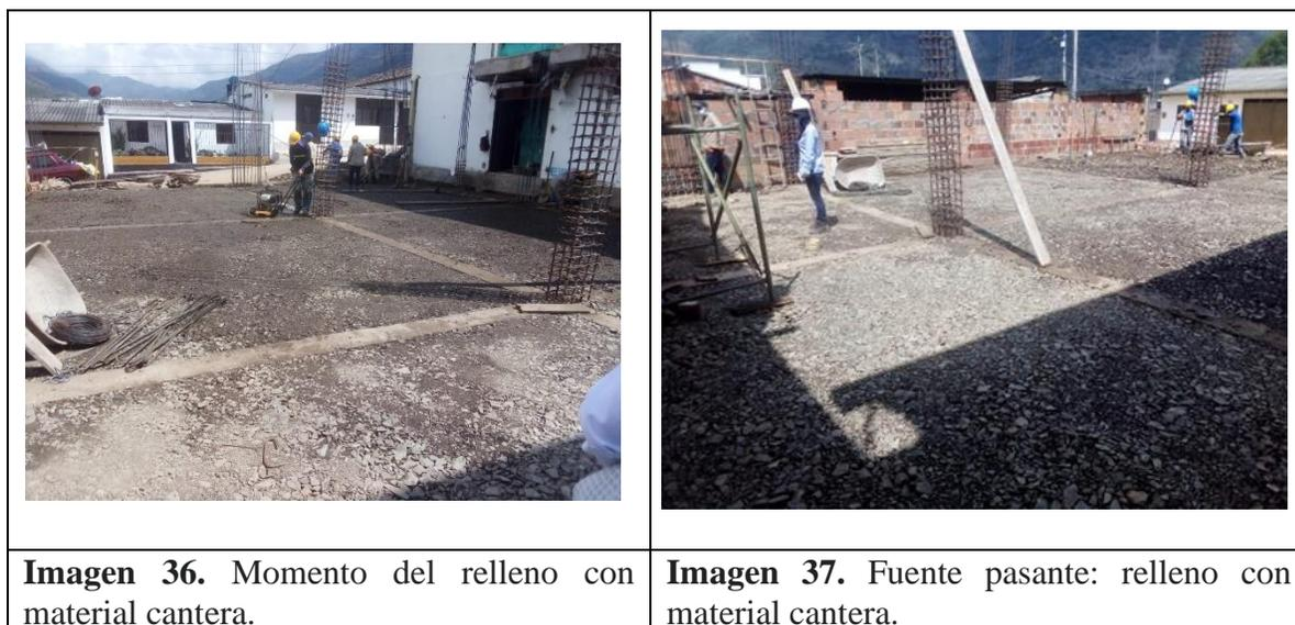
**Figura 42. Relleno con material de cantera**
