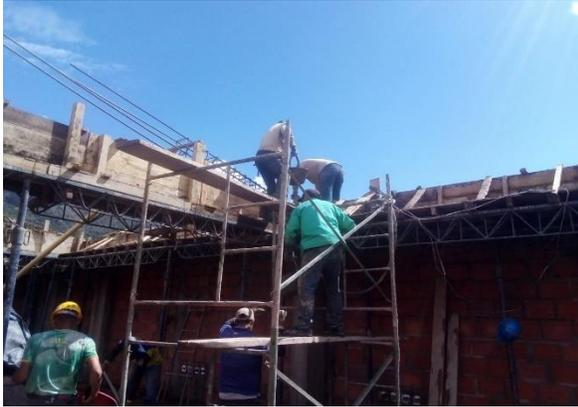
**Figura 77. Vaciado en vigas cubierta**
