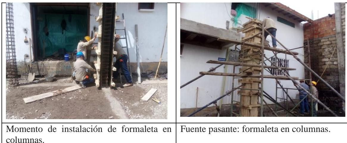
**Figura 47. Instalación de formaletas**
