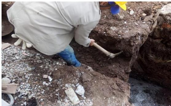
**Figura 36. Momento de excavación para vigas de cimentación**
