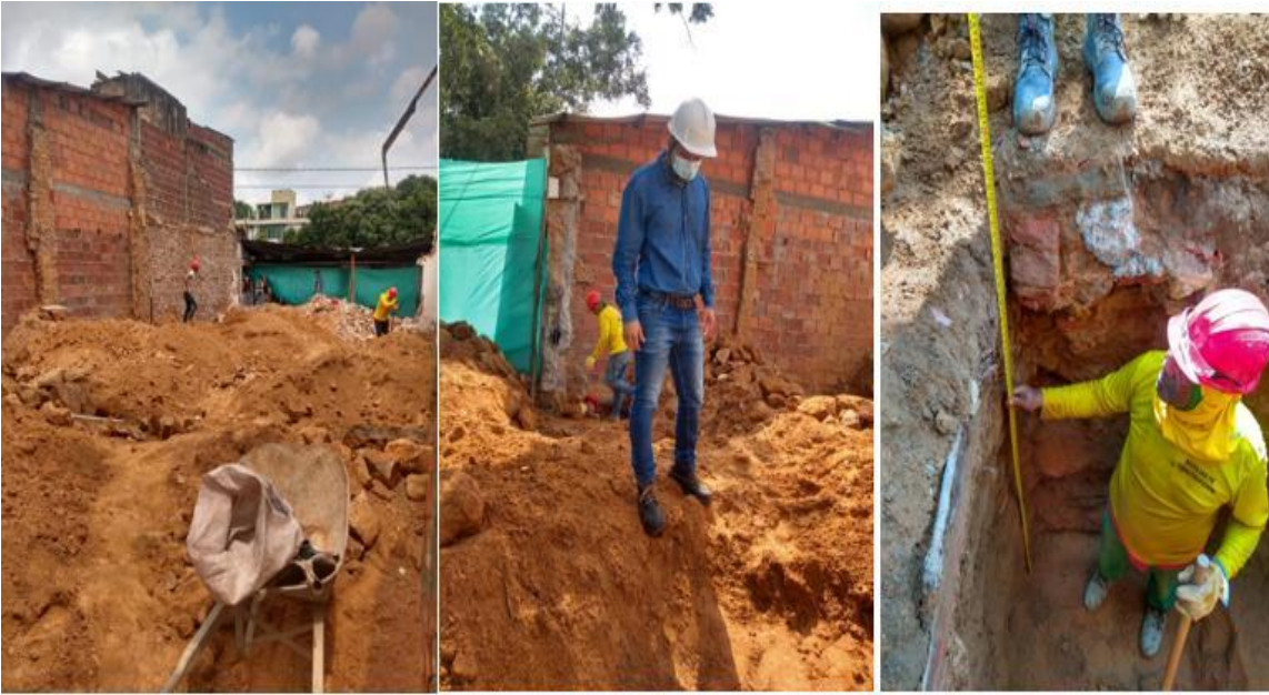
Figura 13. Movimiento de tierras y excavación
