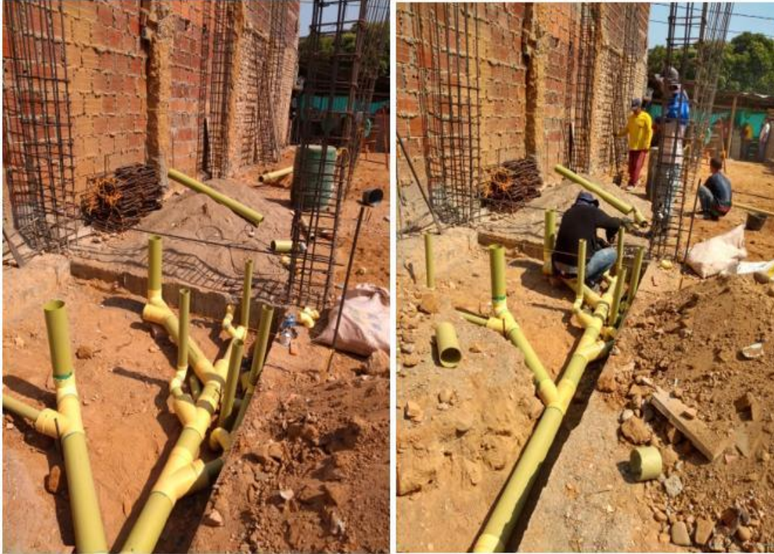
Figura 19. Instalación de tubería hidrosanitaria
