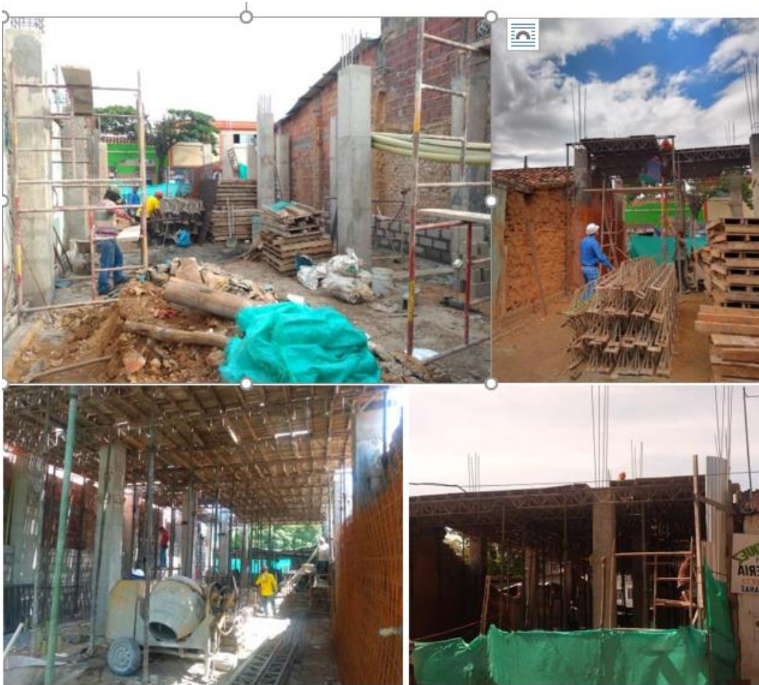
Figura 24. Armado de andamios para armar la estructura de encofrado para la placa del segundo piso
