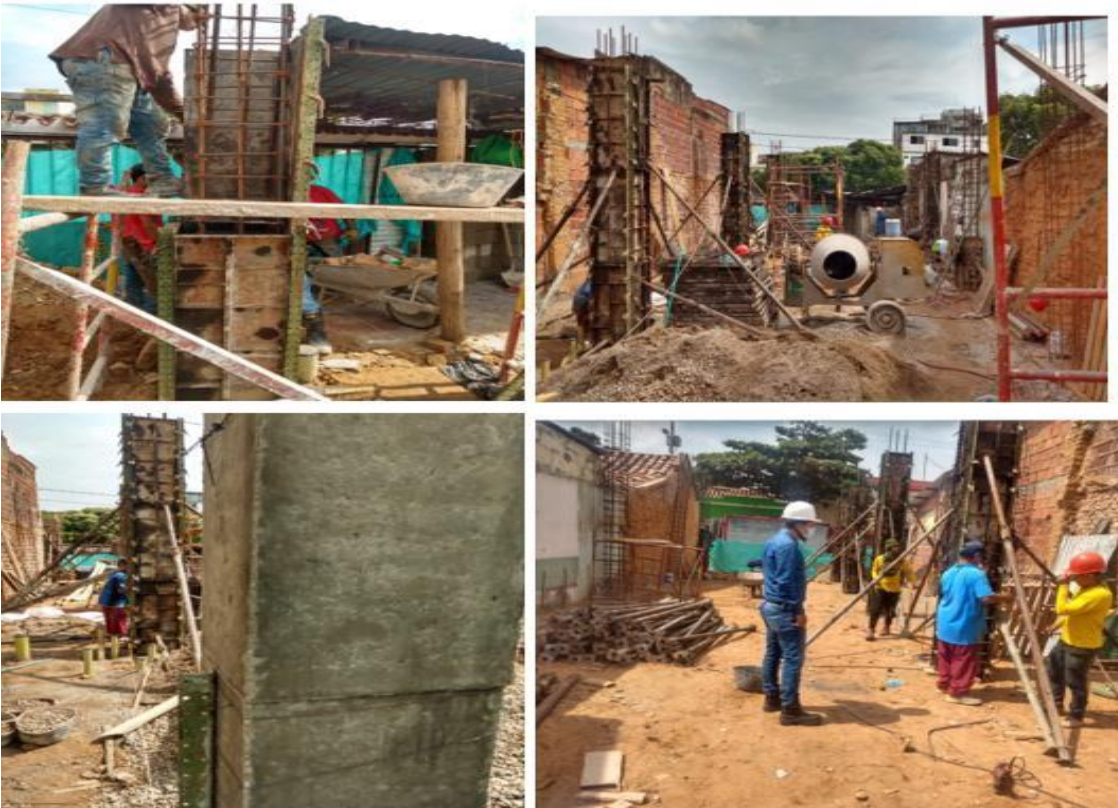
Figura 21. Armado y fundición de columnas
