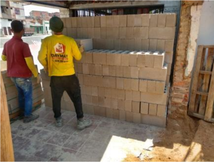
Figura 20. Llegada de ladrillos para relleno de muros
