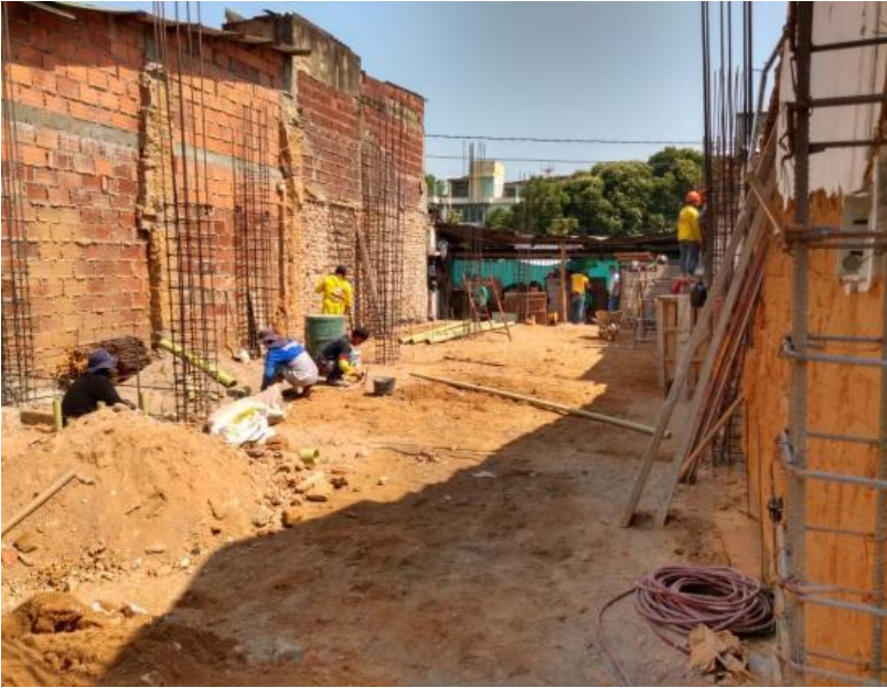
Figura 18. Armado de columnas del primer piso
