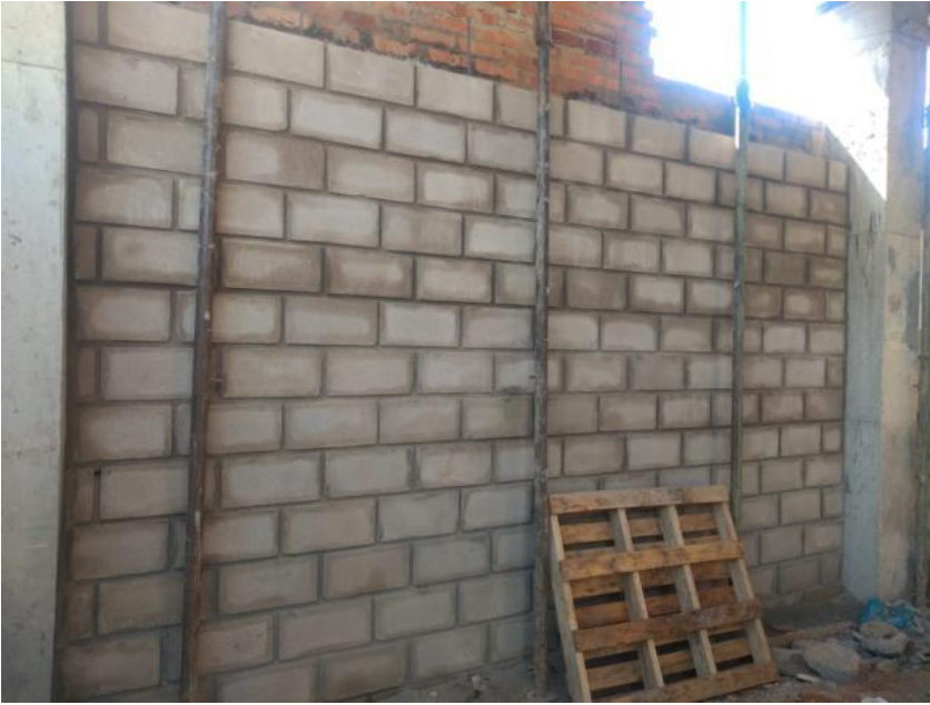
Figura 22. Trabajo de mampostería de llenado de los muros y llenado de muros final
