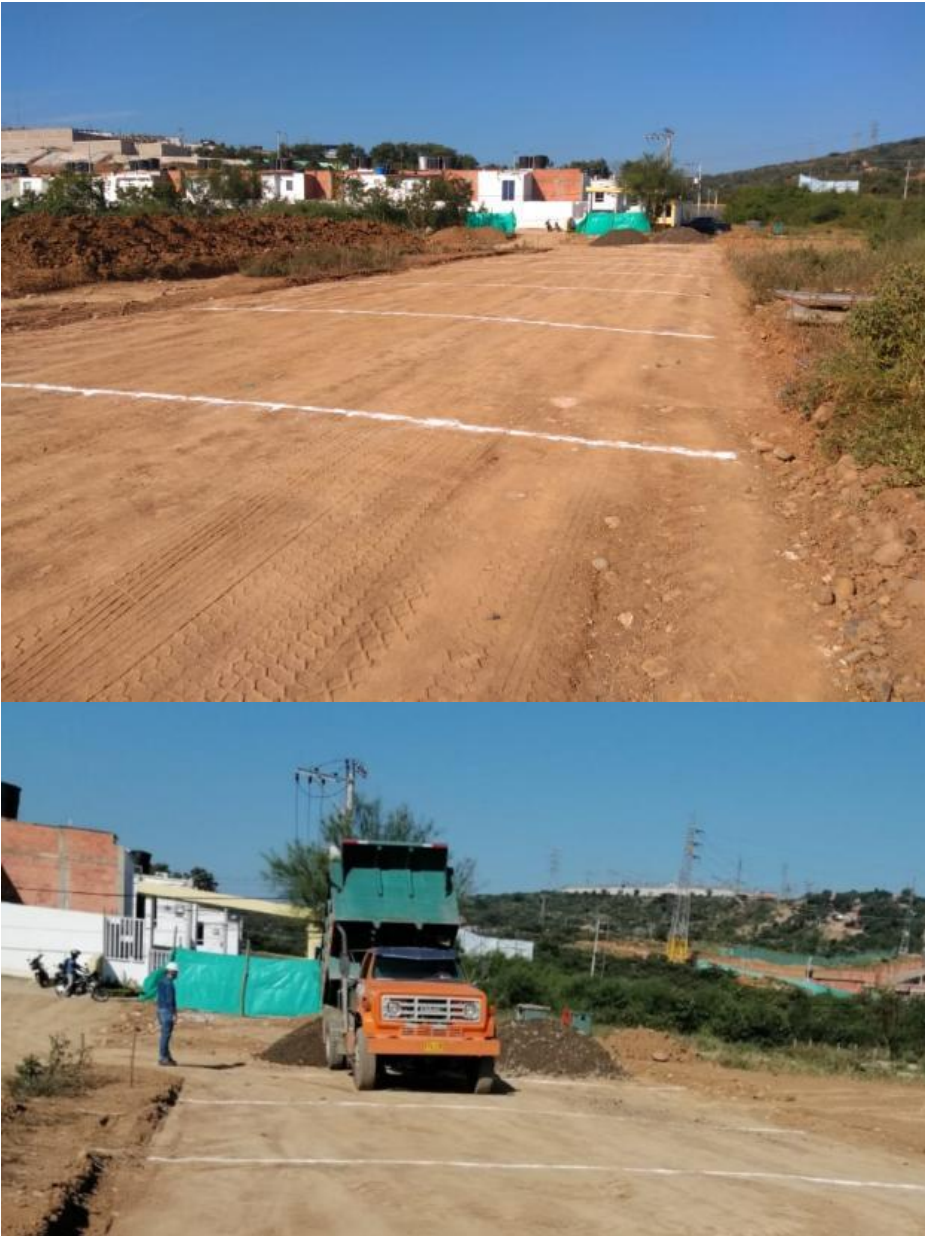
Figura 4. Replanteo de las terrazas.
