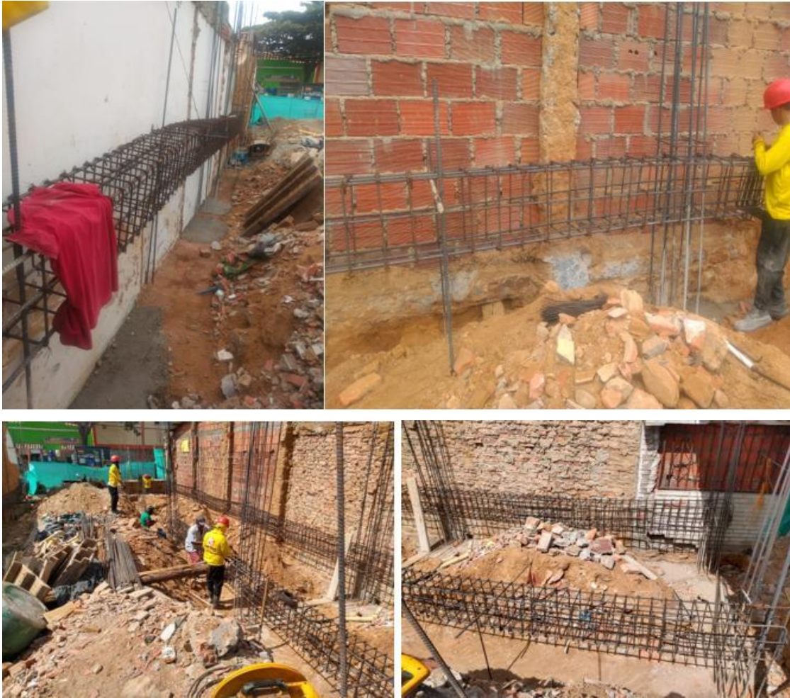
Figura 16. Armado de las vigas 1 y armado de las vigas 2
