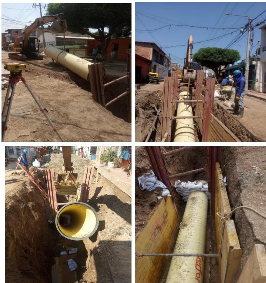
**Figura 15. Tubo atado con una eslinga, Inserción del tubo e instalado correctamente**
