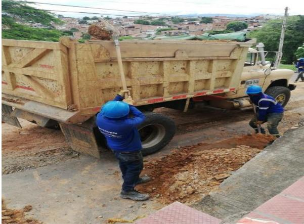
**Figura 35. Retiro de escombros manualmente**
