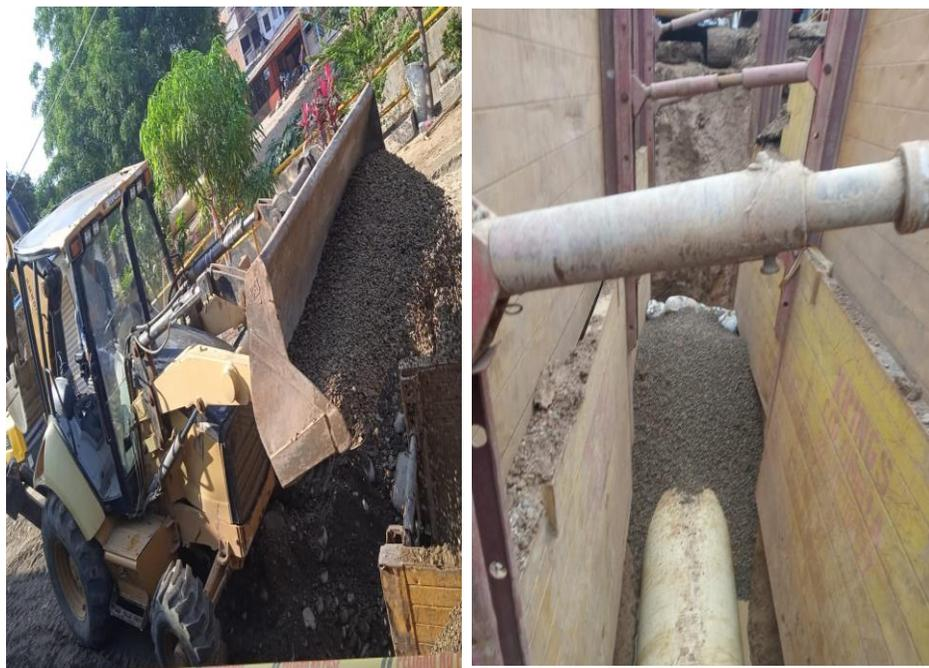
**Figura 21. Pajarita relleno con triturado y Relleno con triturado**
