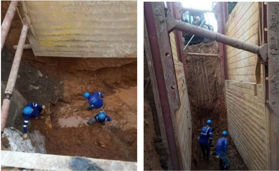
**Figura 11. Excavación manual dentro de la zanja y Replanteo manual para obtención de la pendiente**
