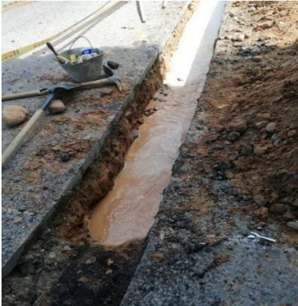
**Figura 37. Tubo de asbesto fracturado**
