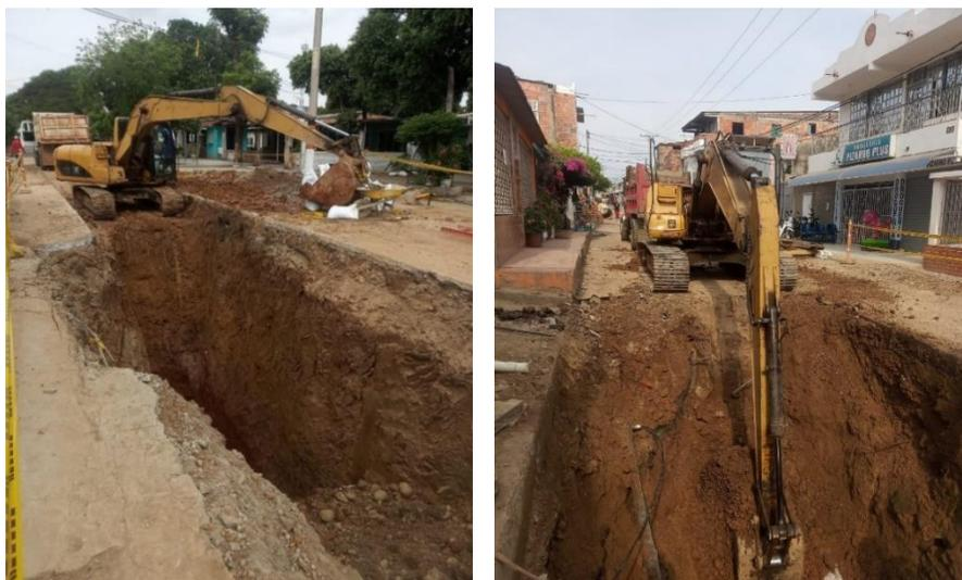
**Figura 9. Excavación mecánica para la zanja con retroexcavadora 312 y para pozo**
