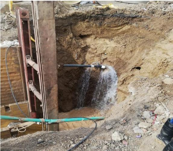
**Figura 14. Fractura del tubo de acueducto**
