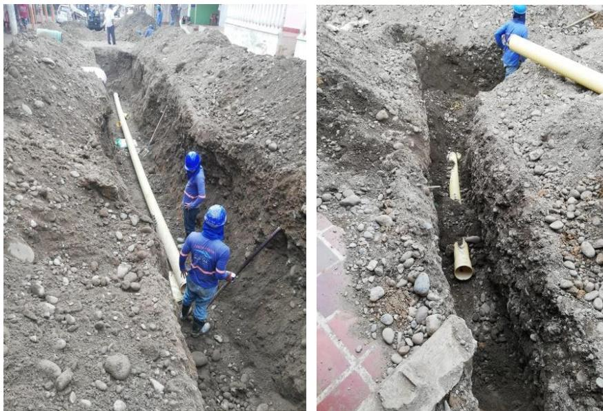
**Figura 19. Instalación tubo 8, Acometida tubo de 6**
