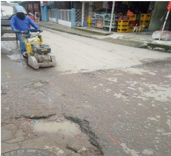
**Figura 7. Corte de pavimento**
