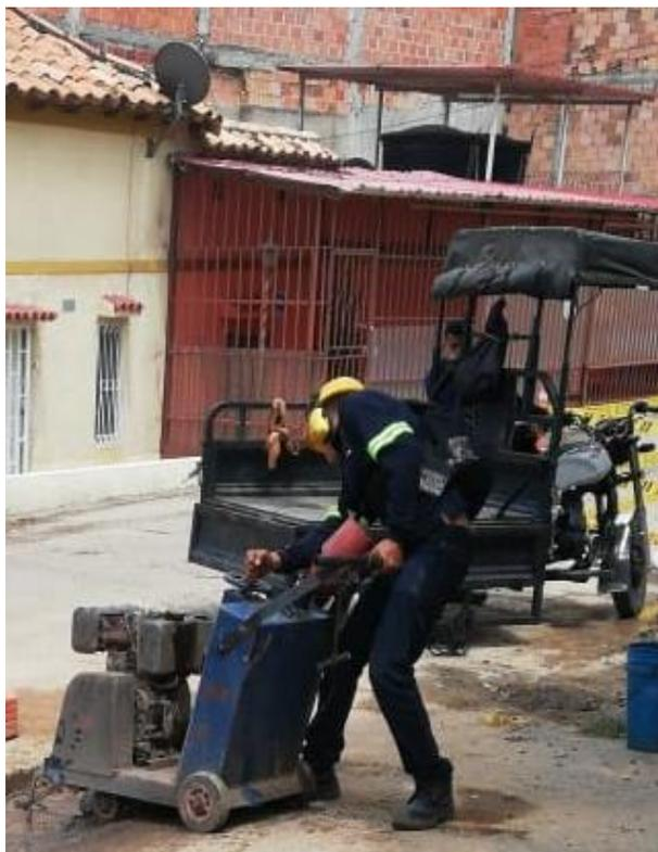
**Figura 32. Corte para zanja**
