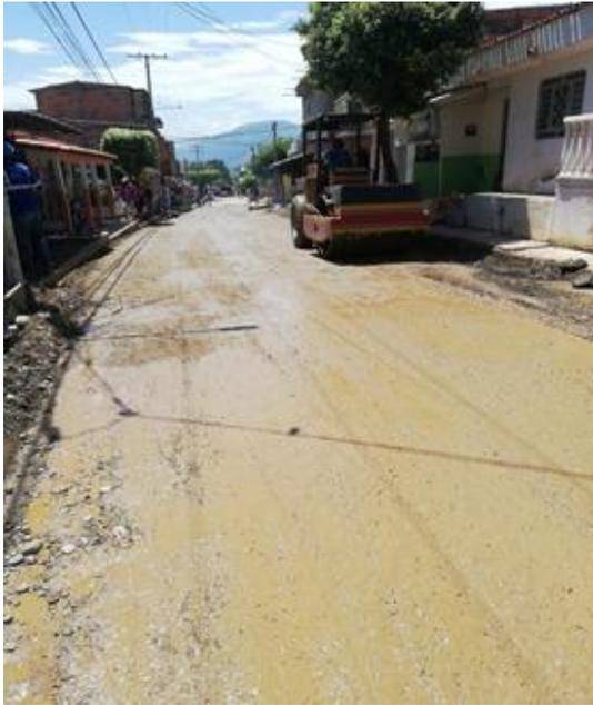
**Figura 26. Compactación de la base con vibro compactador**
