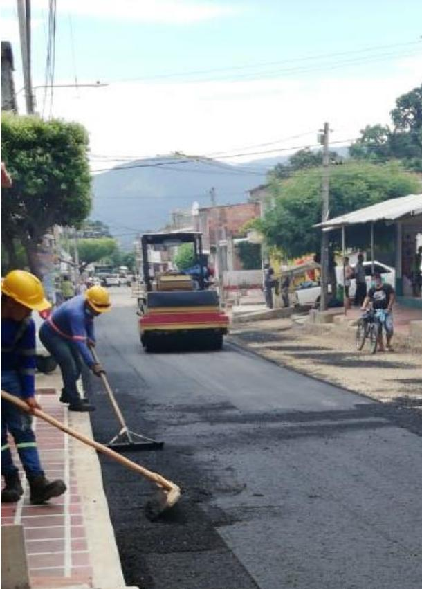
**Figura 29. Sellamiento de pavimento asfáltico**
