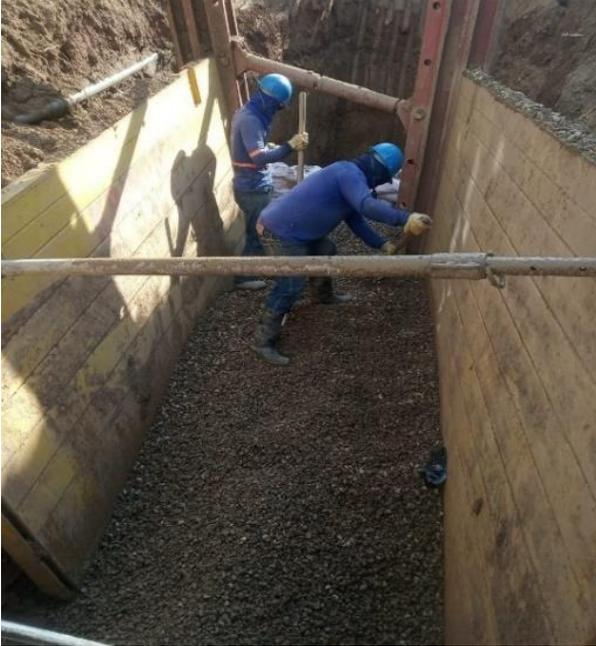
**Figura 22. Replanteo manual de triturado**
