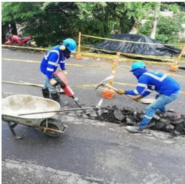
**Figura 33. Demolición capa pavimento**
