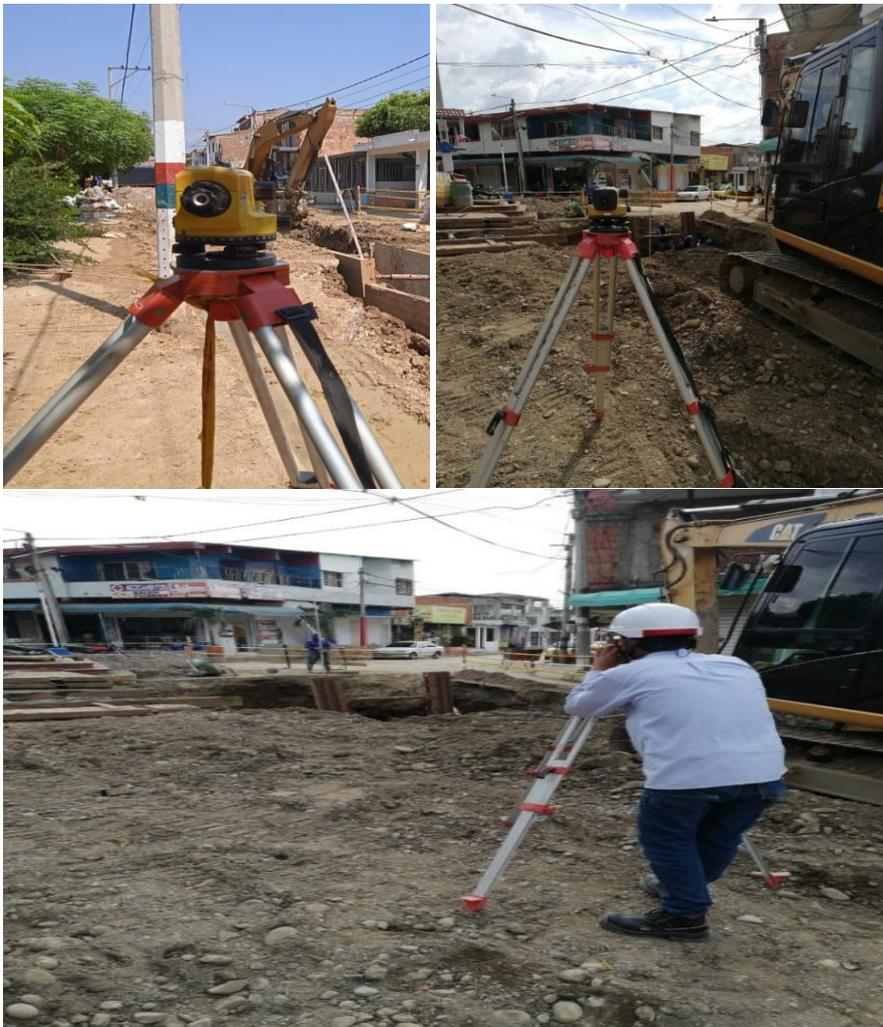
**Figura 8.** Nivel de precisión, nivelación del tubo y comprobación de la cota clave y cota batea.
