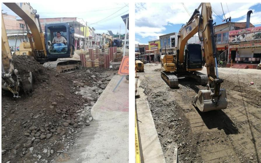
**Figura 24. Retroexcavadora 312 rellenando con subbase y relleno de subbase terminado**
