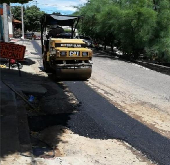
**Figura 44. Extendida de asfalto manual y compactación de mezcla asfáltica**
