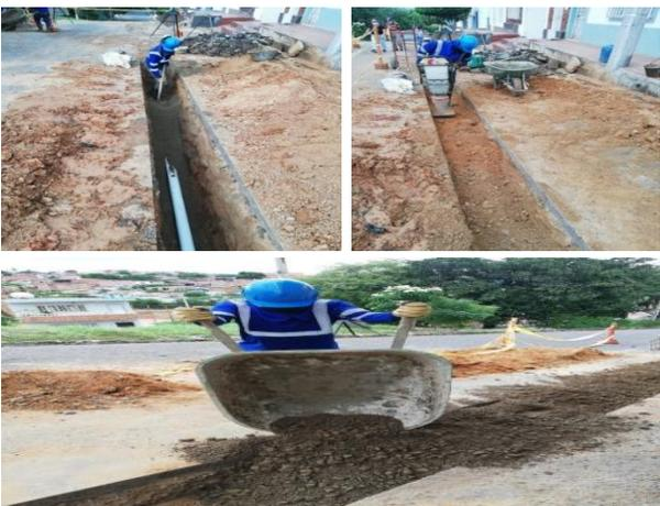
**Figura 40. Primera capa (colchón), compactando material común y ultima capa (base granular)**
