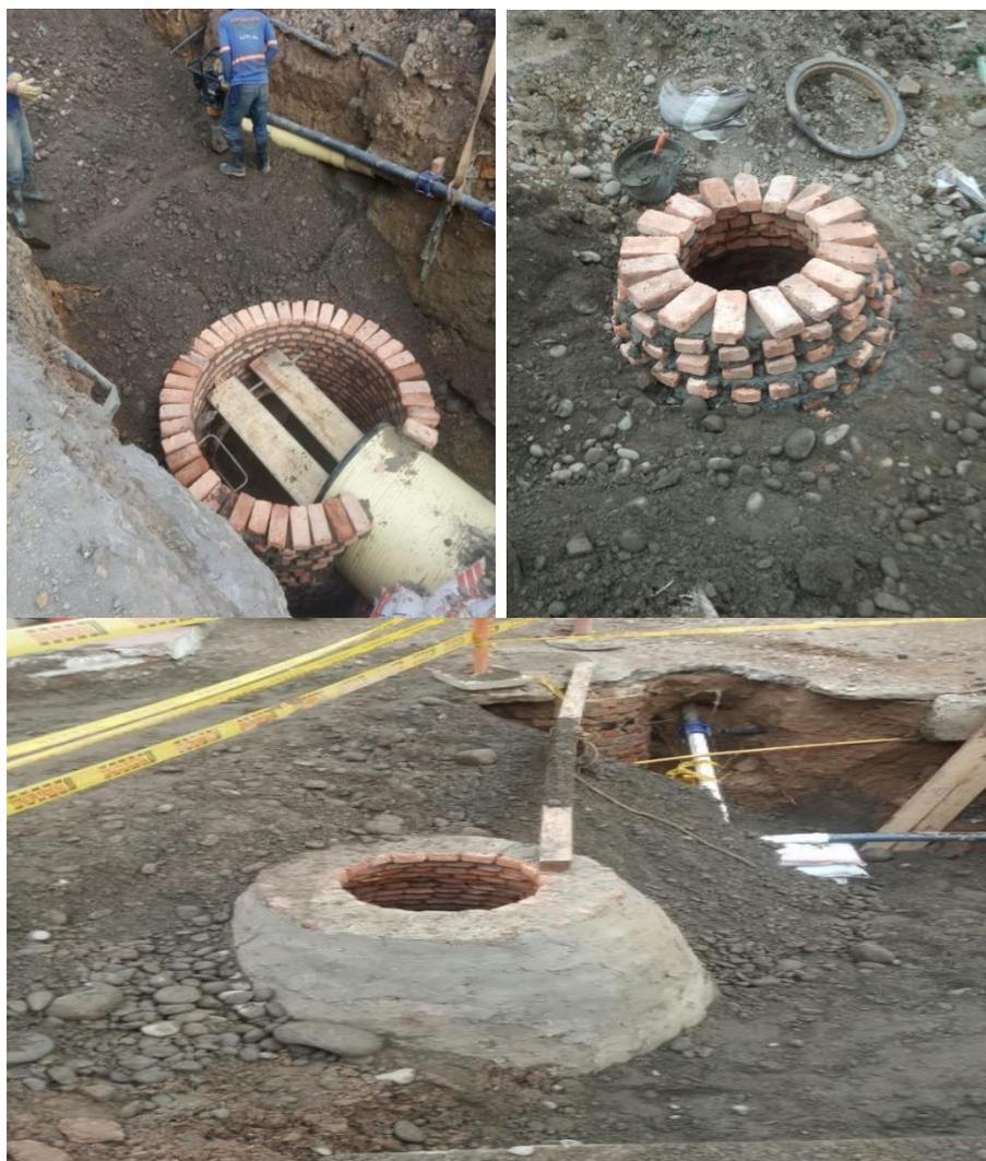
**Figura 18. Inicio de levantamiento de pozo**
