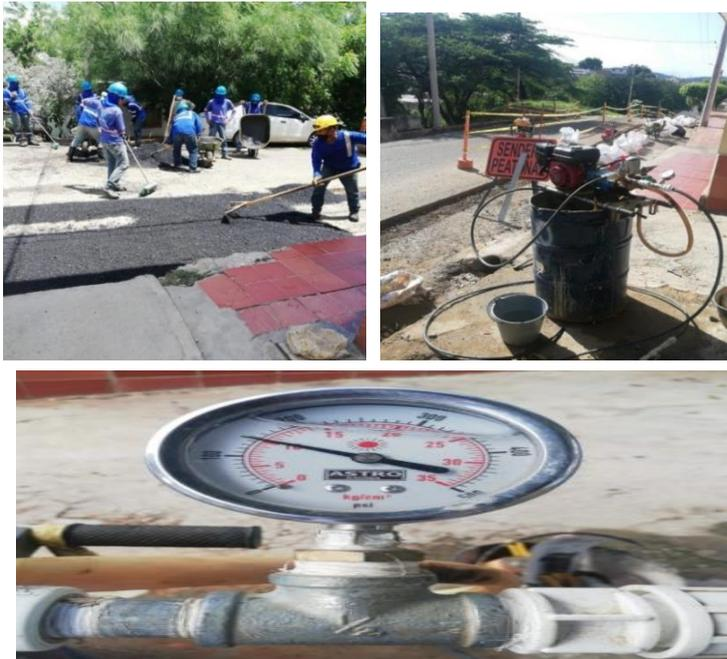
**Figura 43. Máquina de prueba hidráulica y Manómetro**
