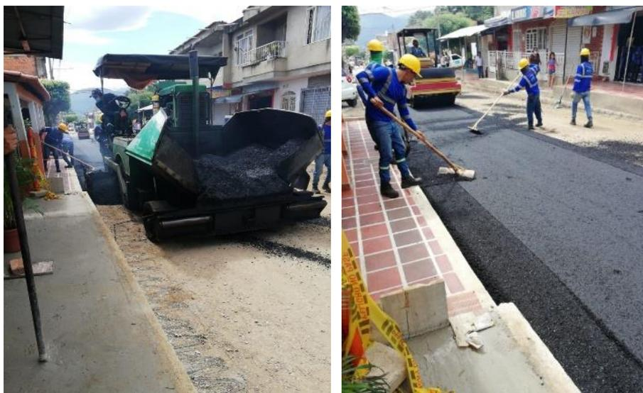
**Figura 28. Mezcla asfáltica extendida con la asfaltadora (Finisher) y extendido manual (Rastrillar)**
