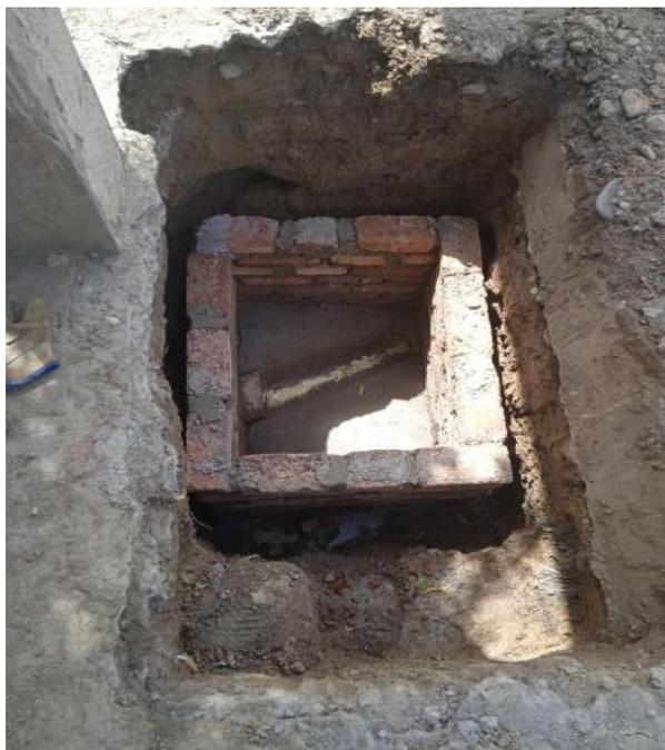
**Figura 20. Caja de inspección**
