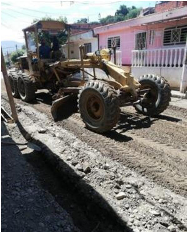
**Figura 25. Replanteo del terreno con motoniveladora**
