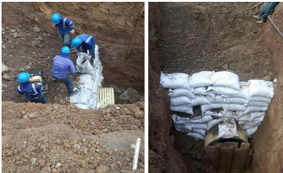
**Figura 23. Armazón de barricada con costales y Barricada finalizada**
