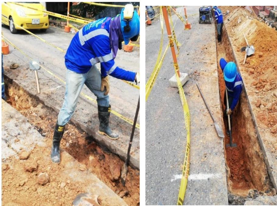
**Figura 34. Excavación manual y Extracción de material**
