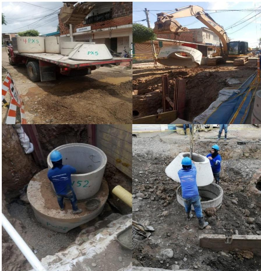
**Figura 17. Transporte e introducción de anillos instalado**
