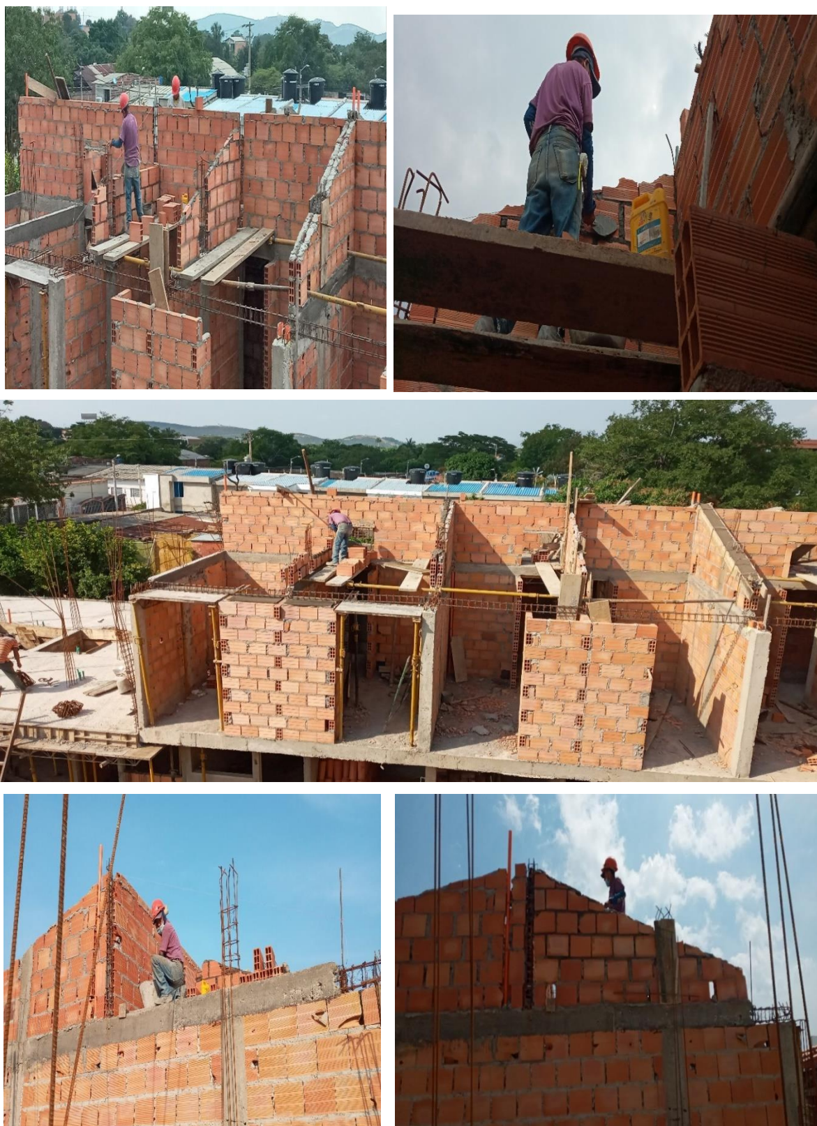
Figura 12. Registro fotográfico mampostería
