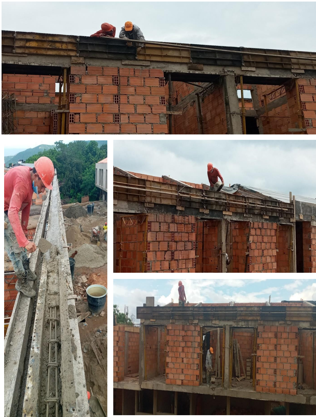
Figura 9. Registro fotográfico estructura
