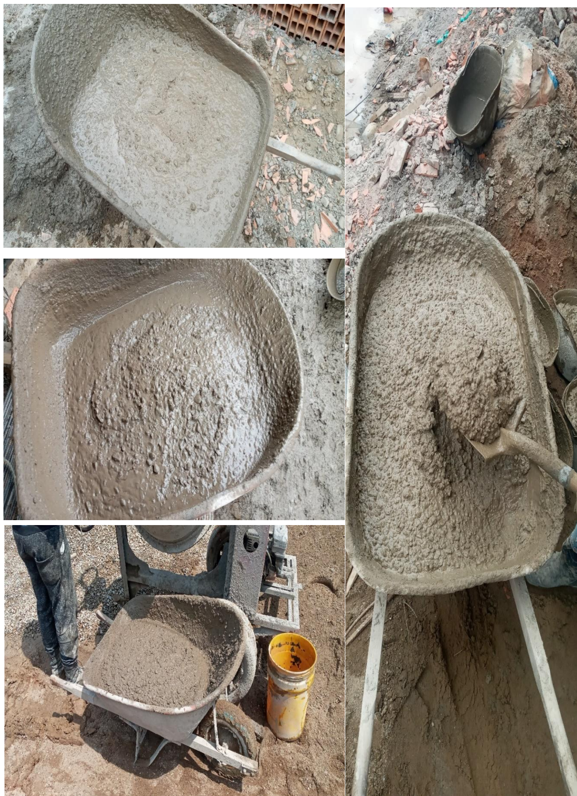
Figura 8. Registro fotográfico cimentación
