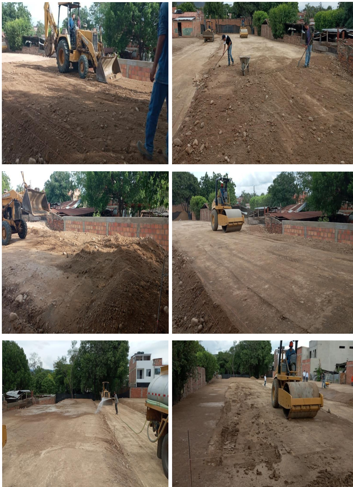
Figura 4. Registro fotográfico movimiento de tierras
