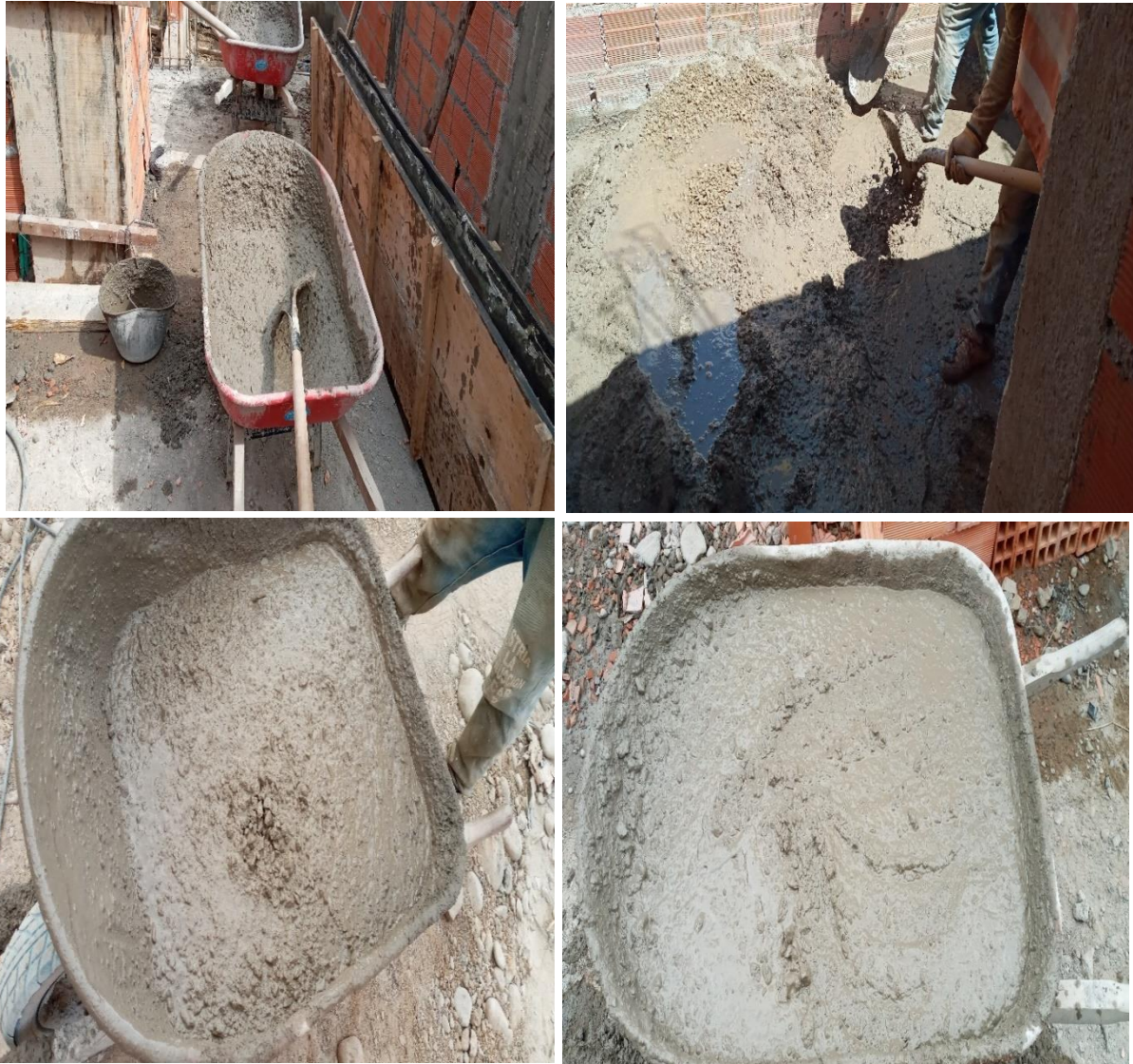
Figura 11. Registro fotográfico de estructura
