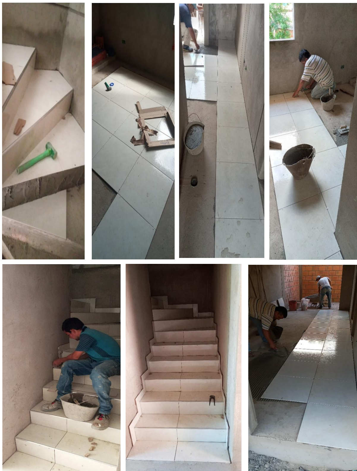
Figura 18. Registro fotográfico de pisos
