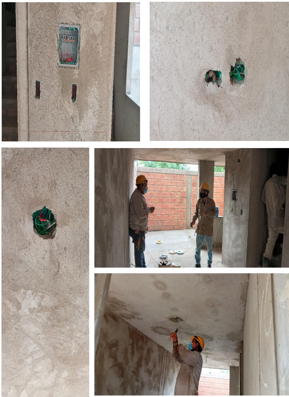
Figura 14. Registro fotográfico instalaciones eléctricas, hidráulicas y sanitarias
