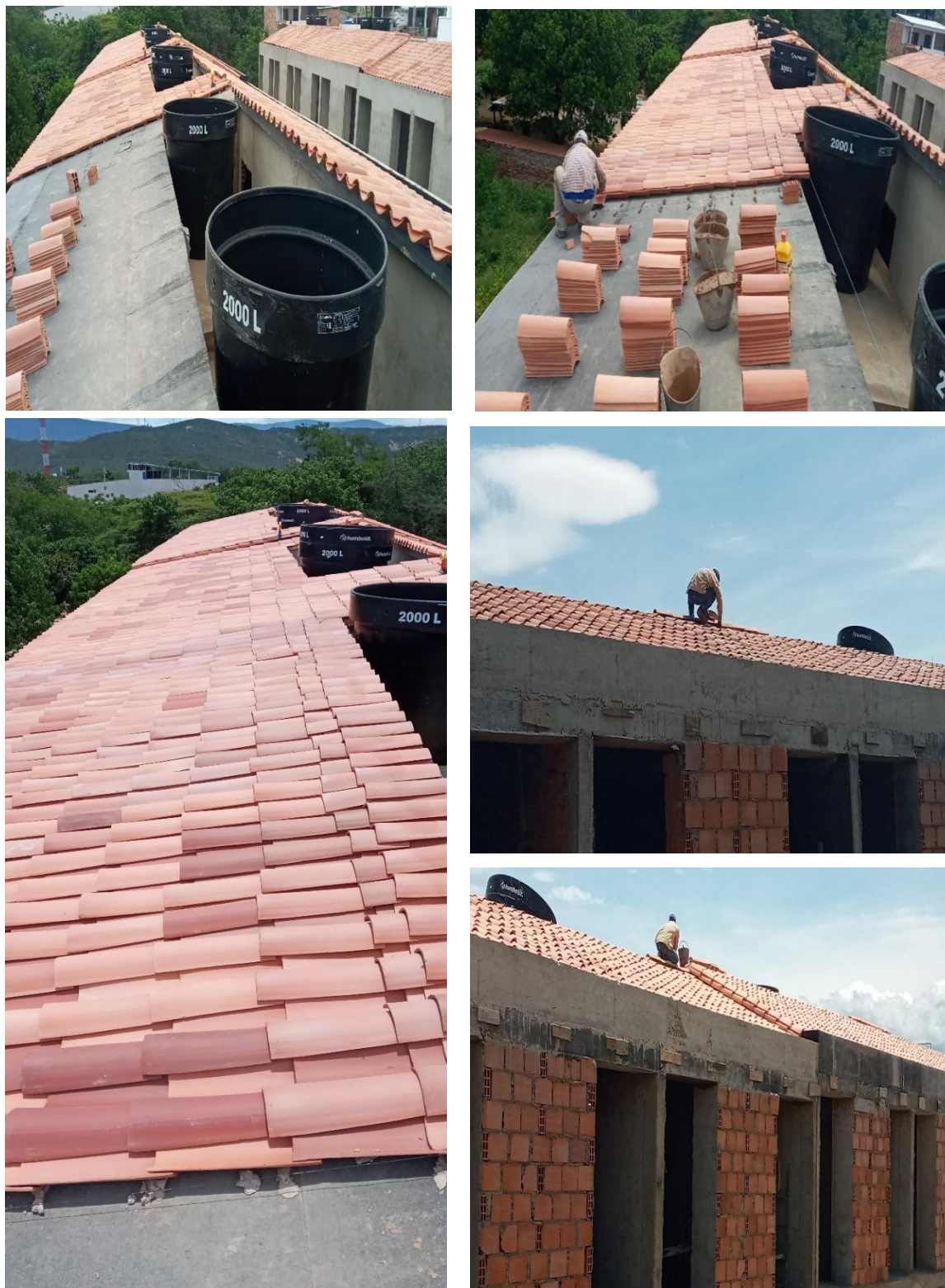
Figura 16. Registro fotográfico cubierta
