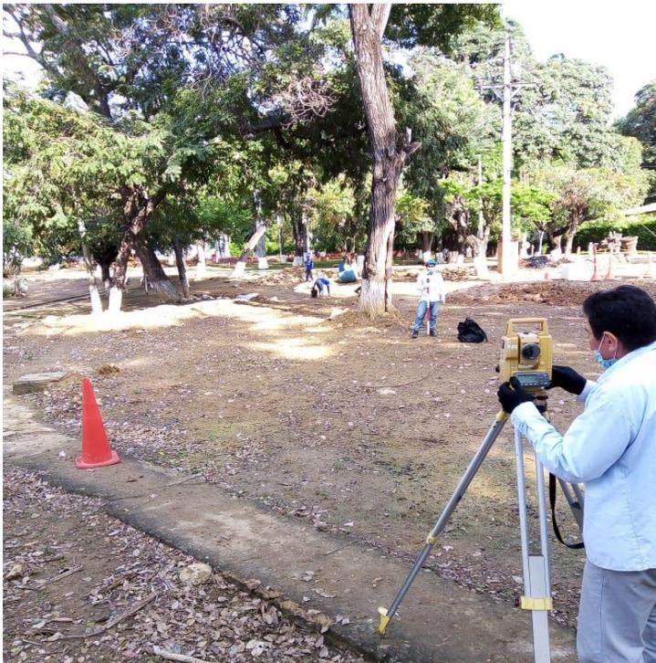
**Figura 7. Verificación topográfica para absisado**
