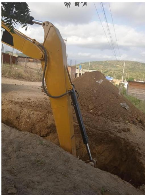
**Figura 10. Excavación para instalación de tubo polietileno.**
