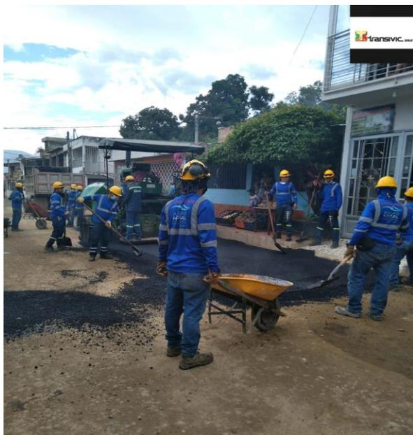
**Figura 26. Recuperación de pavimento en asfalto**
