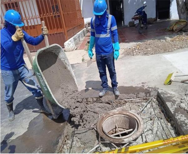
**Figura 42. Vaciado de concreto**
