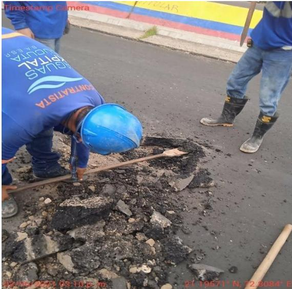
**Figura 36. Demolición de asfalto**
