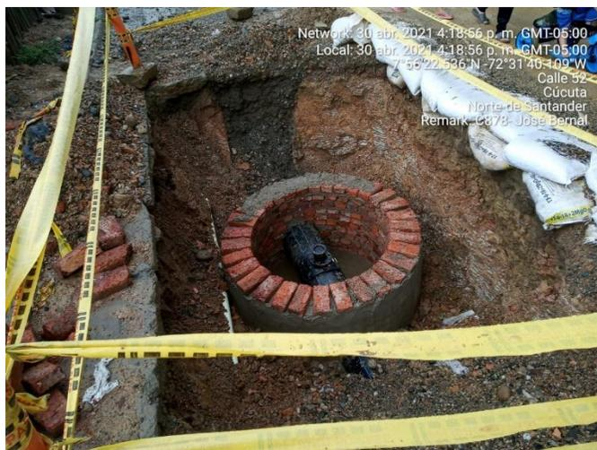
**Figura 21. Comprobar la instalación de la válvula de ventosa**
