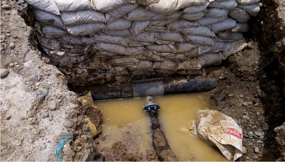
**Figura 12. Instalación de la válvula de ventosa**
