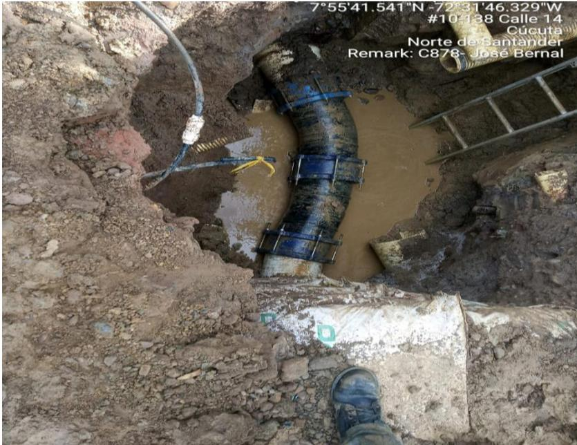
**Figura 13. Instalación de codo con brida y empalmando de polietileno a PVC.**
