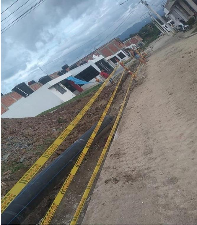
**Figura 8. Demarcación en la zanja para evitar accidentes de terceros.**
