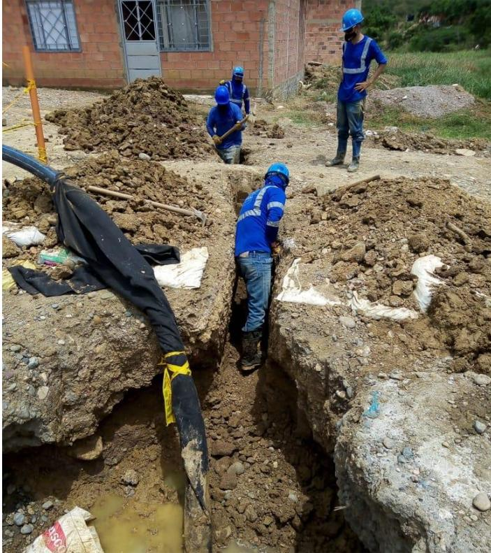
**Figura 11. Excavación manual para purgas con hidrantes**
