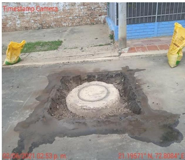
**Figura 35. Corte de pavimento.**
