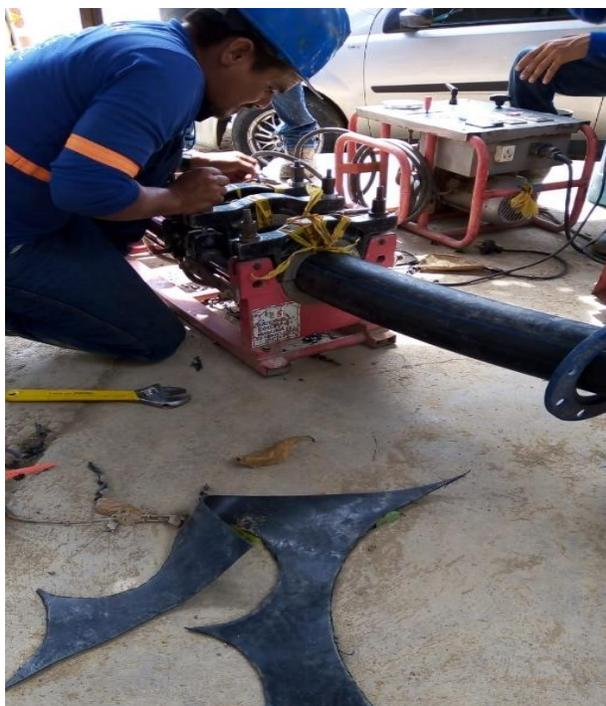
**Figura 15. Inicio de instalación por termofusión para tubería polietileno 14**
