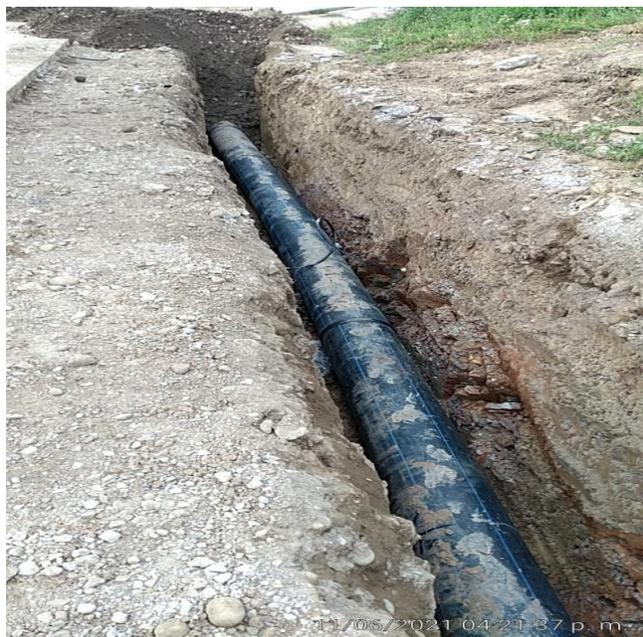
**Figura 16. Instalación de tubería de polietileno**
