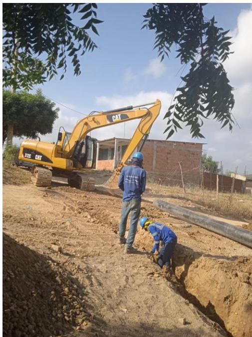
**Figura 9. Excavación mecánica de la zanja con retroexcavadora 320 sobre oruga**
