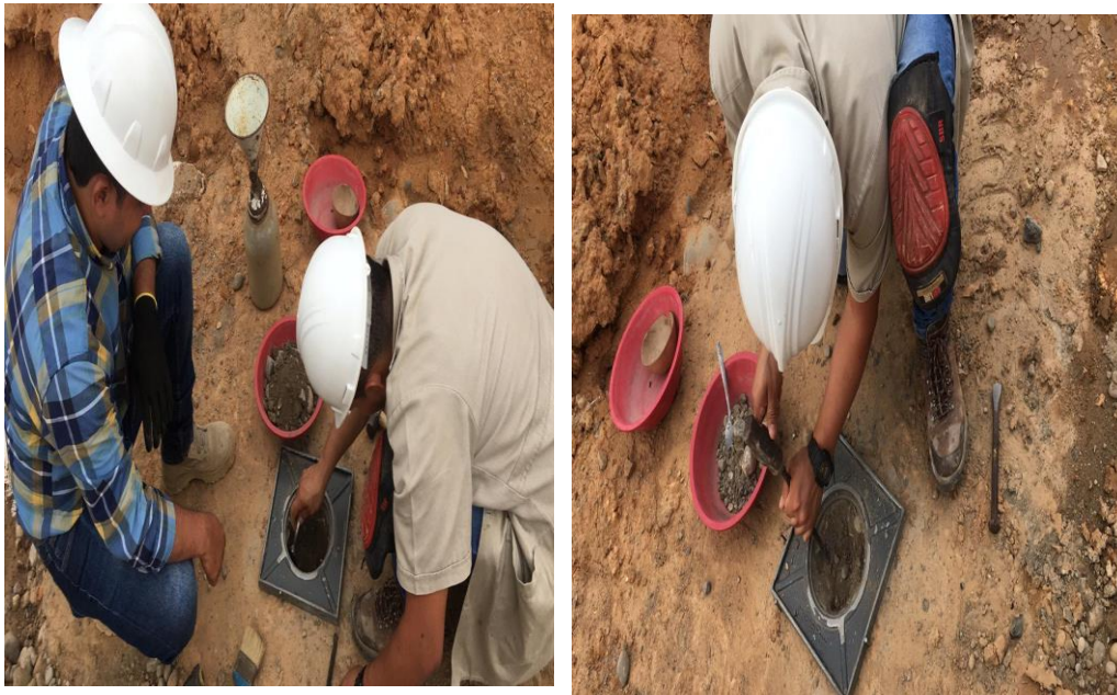
Figura 12. Ensayo Densidad de campo por el método del cono de arena
