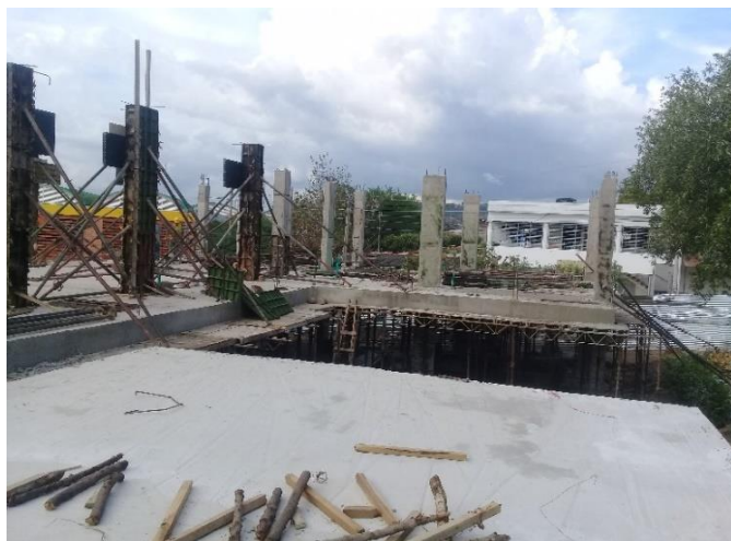
Figura 32. Retiro de formaletas metálicas de columnas 2 nivel salones
