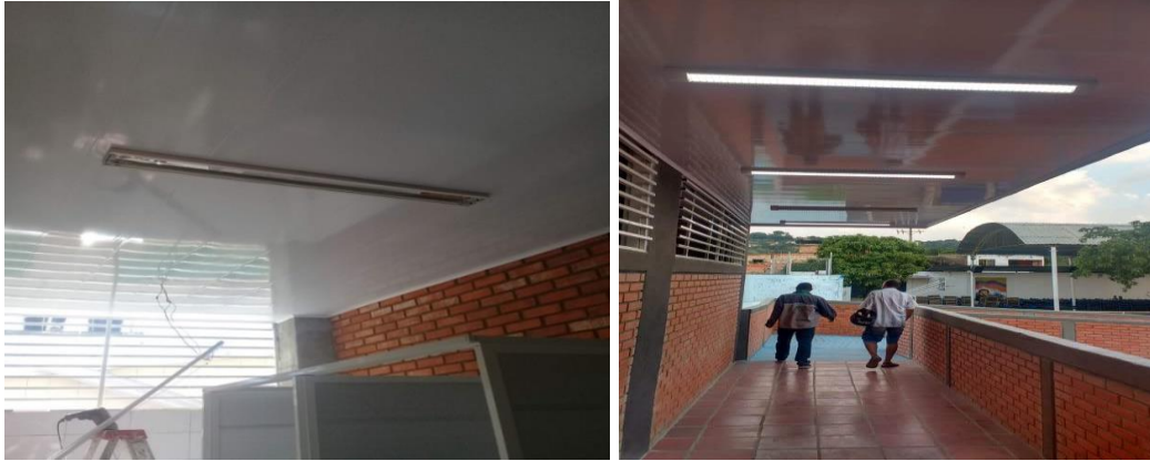
Figura 83. Instalación cielo raso en PVC
