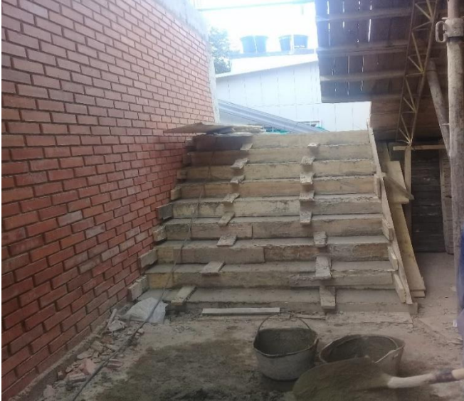
Figura 51. Fundida en concreto escaleras
