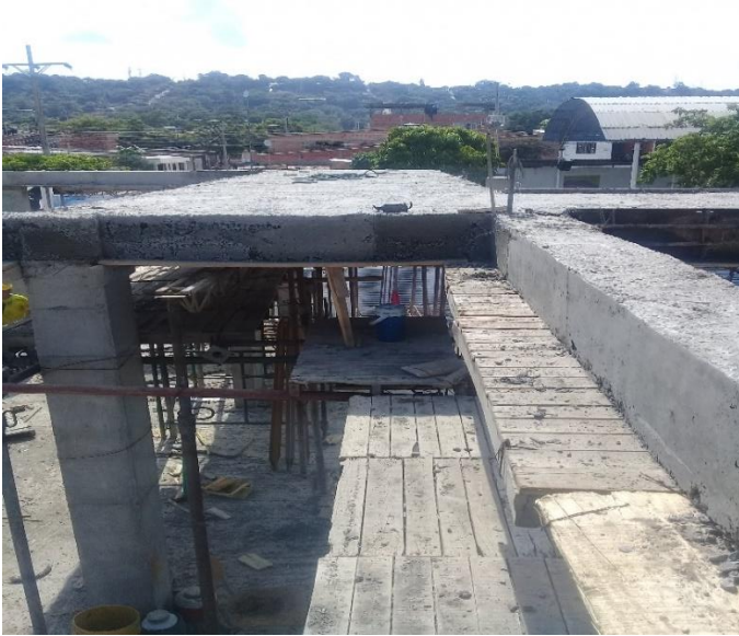
Figura 46. Retiro de formaleta metálica placa cubierta pasillo
