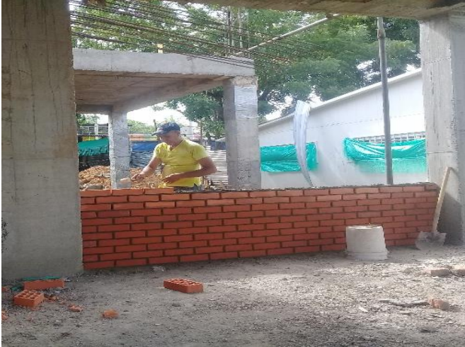
Figura 36. Mampostería primer salón
