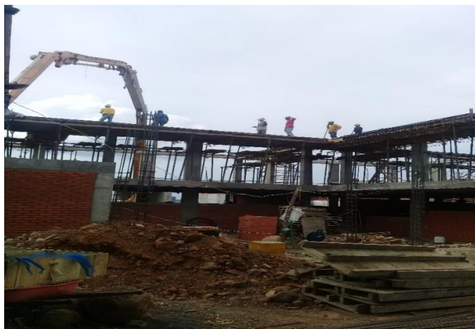
Figura 45. Fundida en concreto de 21 MPa placa cubierta pasillo
