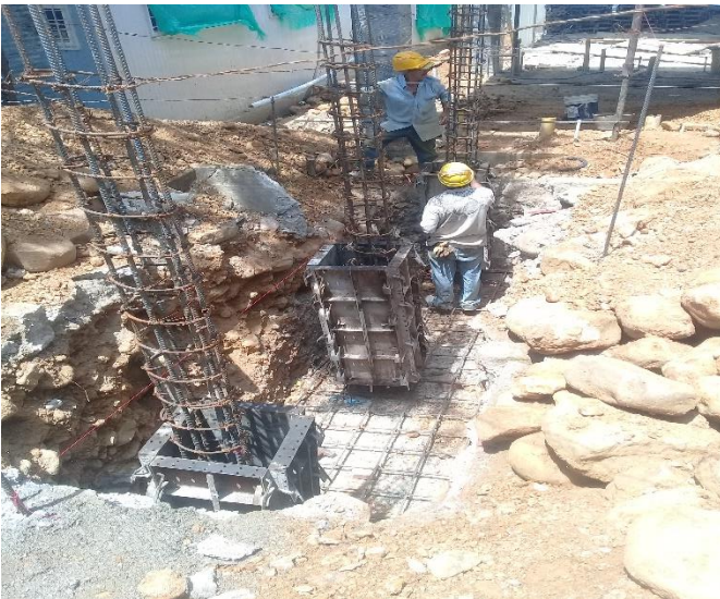
Figura 37. Formaleta para zapatas (rampa)
