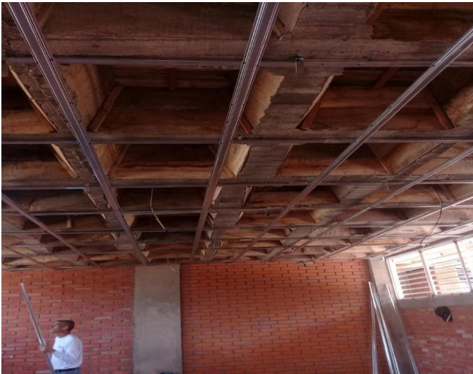
Figura 76. Instalación cielo raso en PVC
