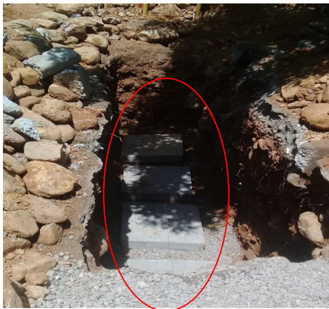
Figura 34. Ret- cel para cimientos rampa
