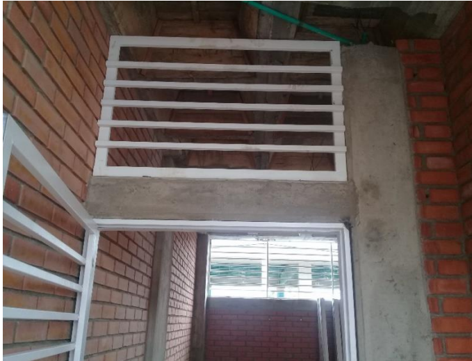
Figura 54. Instalación de carpintería metálica
