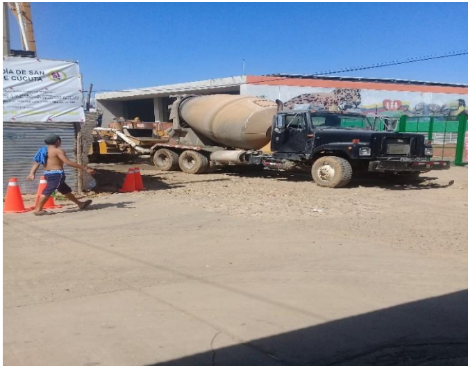
Figura 28. Fundida en concreto de 21 MPa (m3) para columnas 2 nivel (salones)
