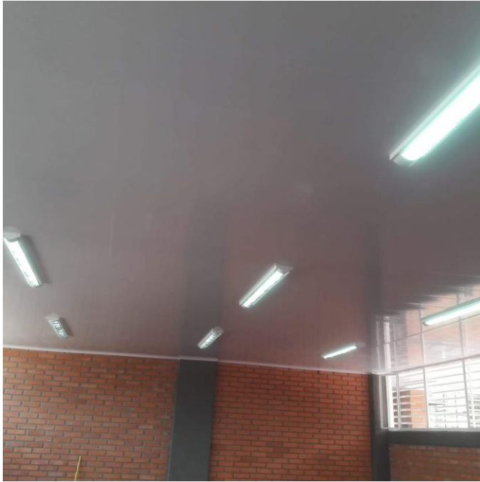
Figura 84. Instalación cielo raso en PVC
