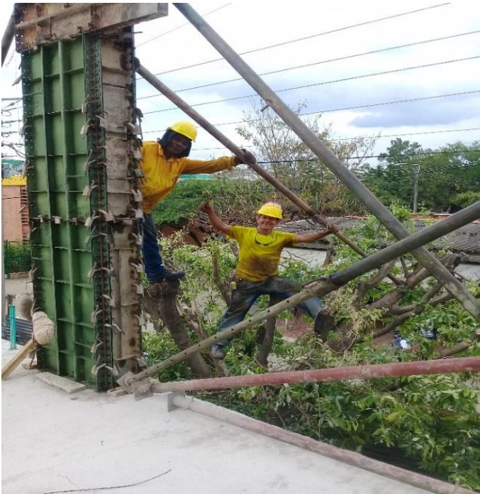
Figura 23. Instalación de formaleta metálica para columnas de 2 nivel
