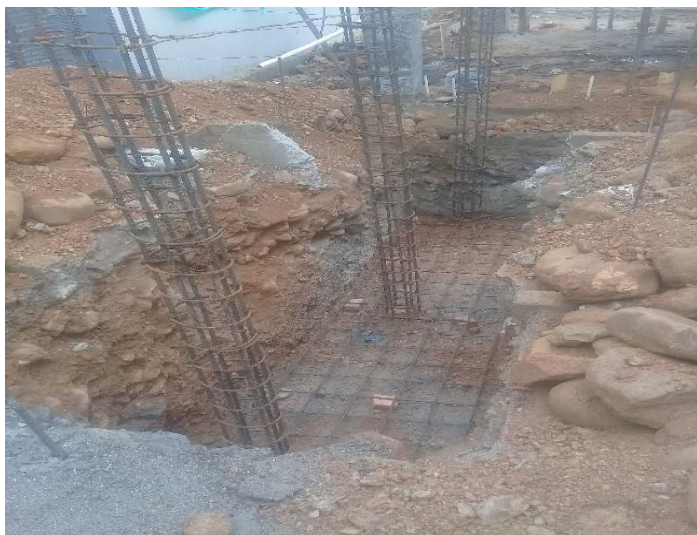
Figura 35. Relleno del mismo material para cimientos de rampa
