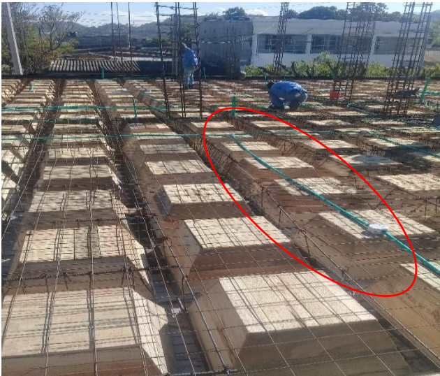
Figura 20. Instalación de tubería PVC puntos eléctricos
