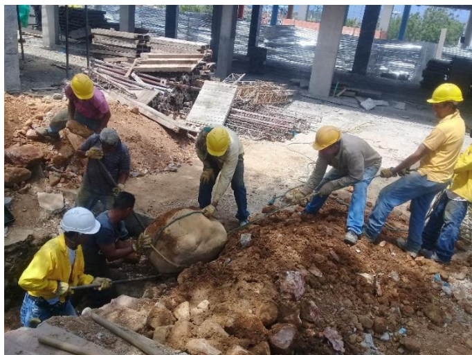
Figura 30. Excavación en tierra o material común y/o conglomerado a mano, incluye transporte interno (m3) (rampa)
