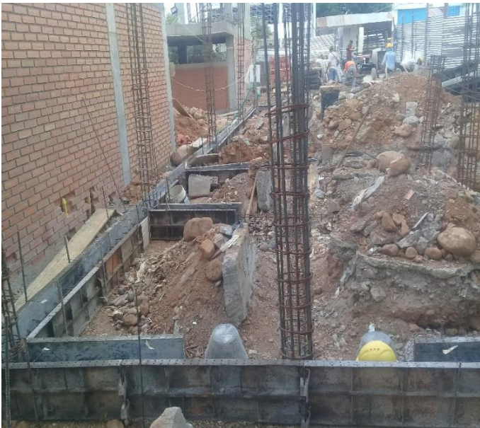
Figura 48. Instalación de formaleta metálica para viga rampa
