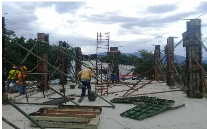
Figura 24. Instalación de formaleta metálica para columnas de 2 nivel
