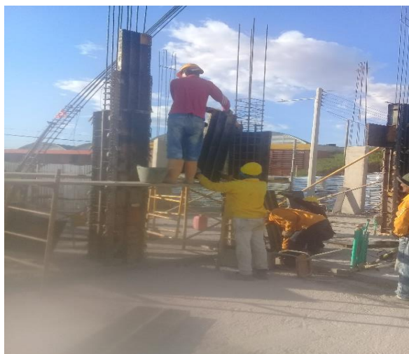
Figura 7. Instalación de formaleta metálica para columnas (salones y baterías sanitarias)
