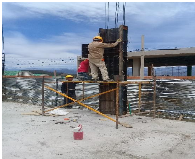
Figura 4. Instalación de formaleta metálica para columnas (salones y baterías sanitarias)
