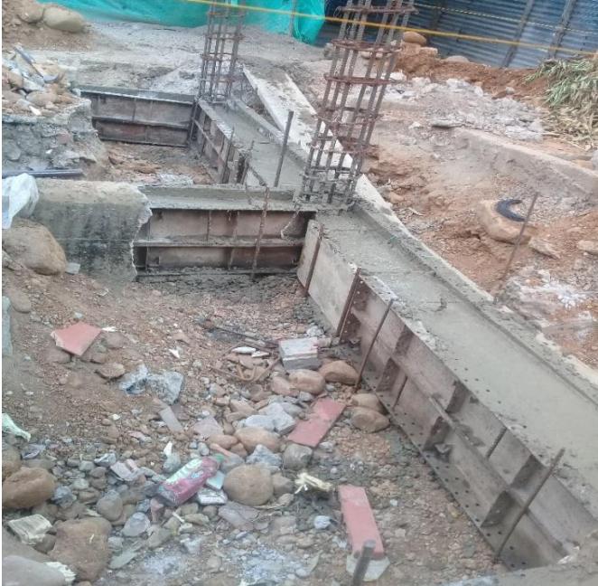
Figura 50. Fundida concreto para vigas rampa
