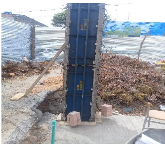
Figura 8. Instalación de formaleta metálica para columnas (salones y baterías sanitarias)
