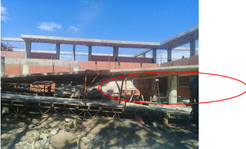
Figura 67. Retiro de tableros, cerchas y parales (rampa)
