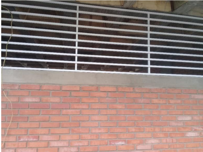
Figura 55. Instalación de carpintería metálica
