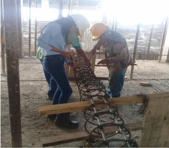
Figura 33. Acero para columnas de rampa (especificaciones columnas redondas)
