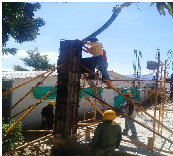
Figura 9. Fundida en concreto de 21 MPa para columnas (m3) (21 columnas)
