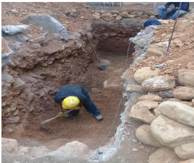
Figura 27. Excavación en tierra o material común y/o conglomerado a mano, incluye transporte interno (m3) (rampa)
