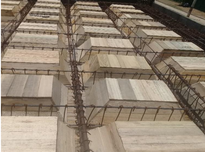
Figura 19. Instalación de casetón de madera
