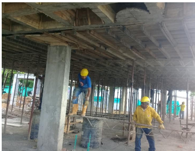
Figura 31. Retiro de cerchas metálicas, parales, tableros
