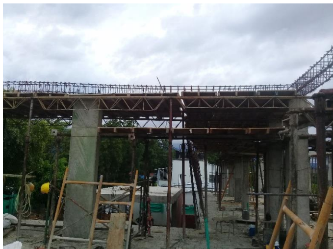
Figura 41. Acero de viga de amarre 2 nivel
