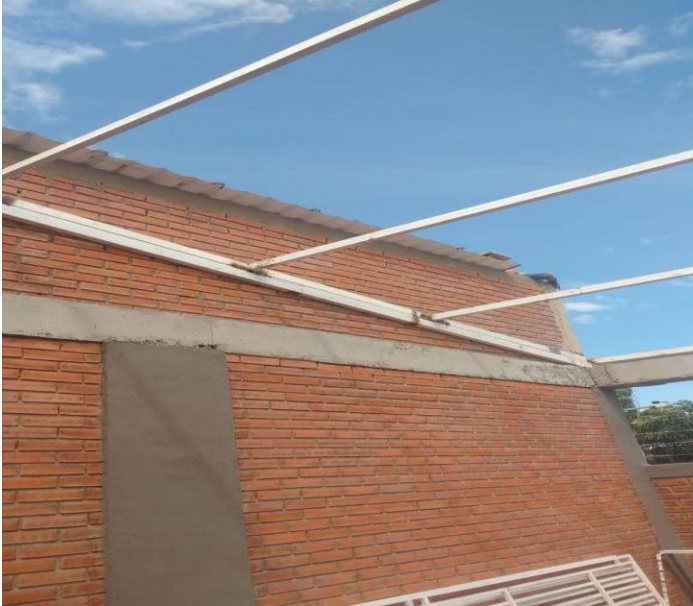
Figura 70. Instalación de estructura metálica (teja thermo acústica)
