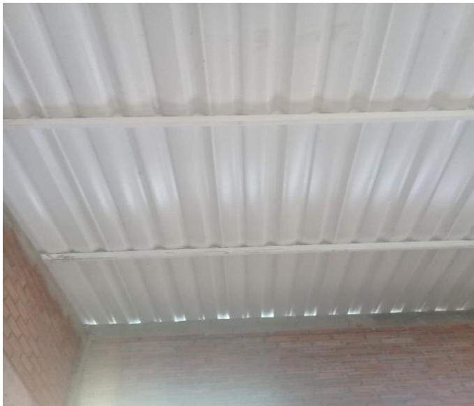
Figura 75. Instalación de estructura metálica (teja thermo acústica)
