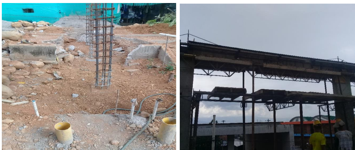
Figura 42. Relleno del mismo material cimentaciones rampa e instalación de formaleta metálica para viga
