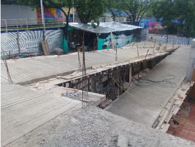
Figura 59. Fundida concreto para rampa
