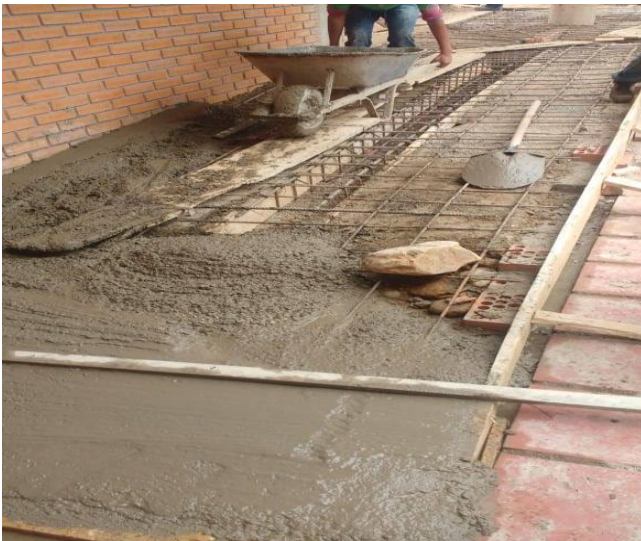
Figura 60. Fundida concreto para rampa
