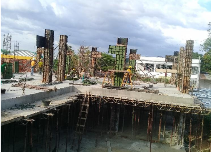
Figura 25. Instalación de formaleta metálica para columnas de 2 nivel
