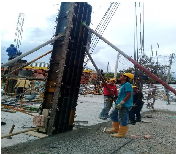
Figura 5. Instalación de formaleta metálica para columnas (salones y baterías sanitarias)
