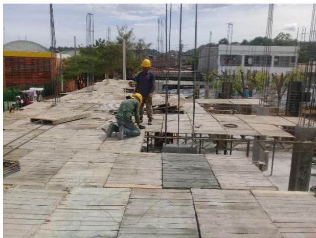
Figura 11. Armada de cama para placa aligerada (m2) - salones
