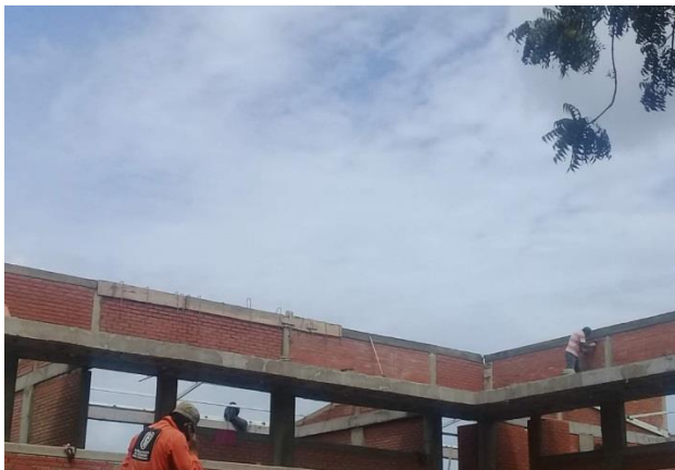
Figura 73. Instalación de estructura metálica (teja thermo acústica)
