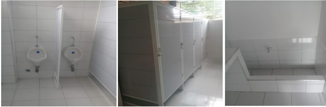
Figura 79. Instalación de equipos sanitarios
