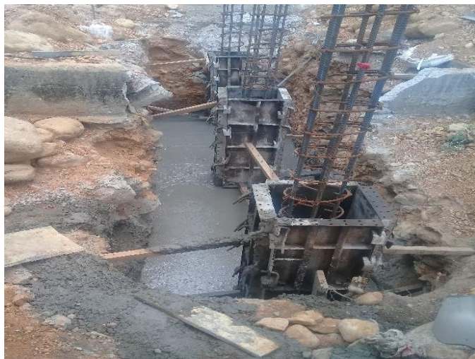
Figura 40. Fundida en concreto ciclópeo para cimientos de rampa
