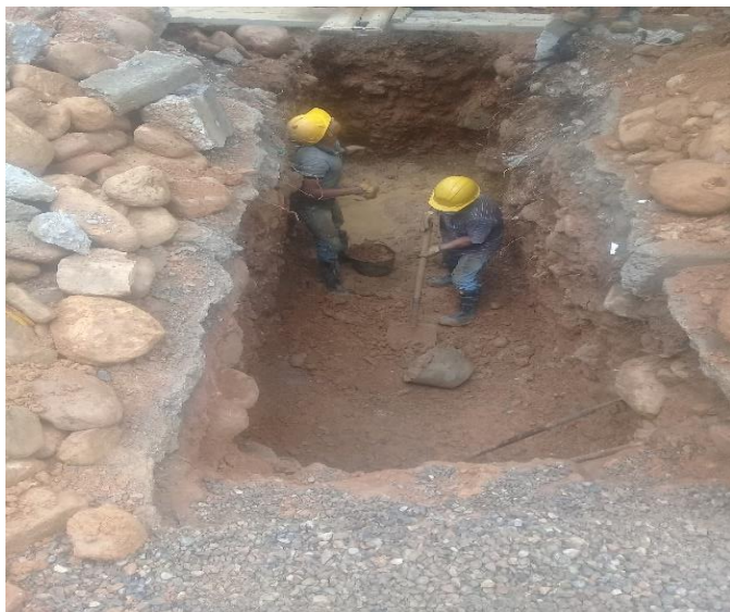
Figura 29. Excavación en tierra o material común y/o conglomerado a mano, incluye transporte interno (m3) (rampa)
