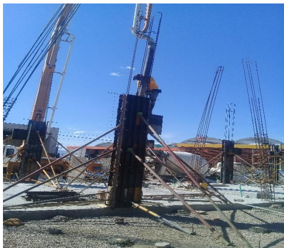
Figura 6. Fundida en concreto de 21 MPa para columnas (m3) (11 columnas)
