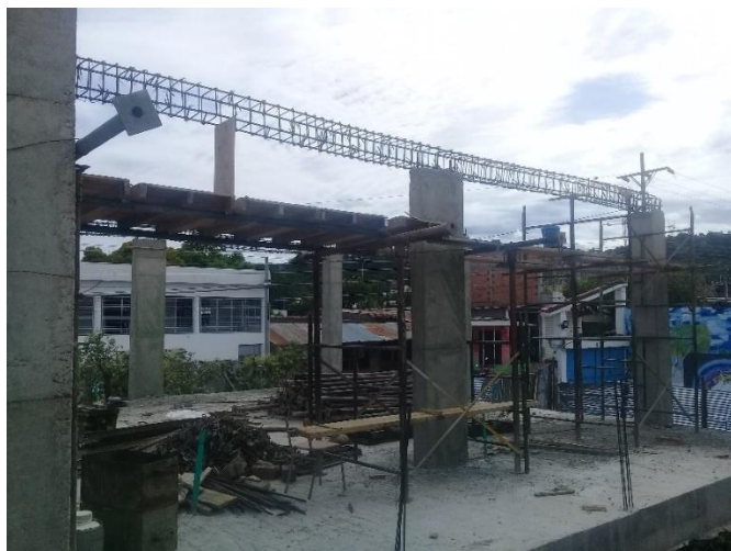
Figura 39. Acero viga de amarre 2 nivel
