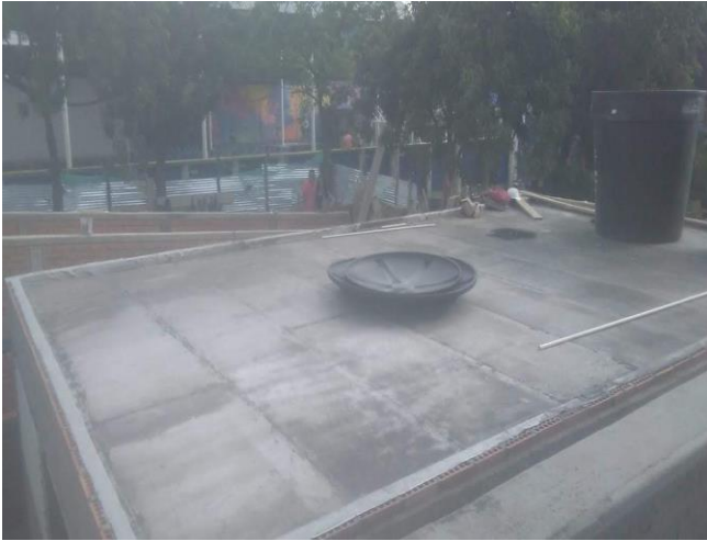
Figura 74. Instalación de tanque de almacenamiento
