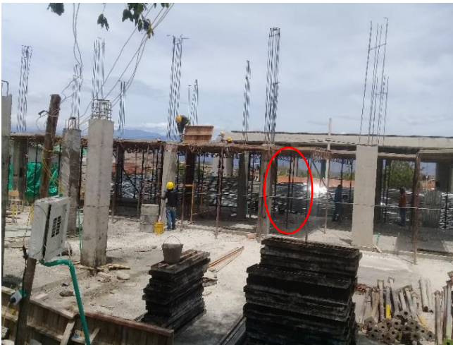
Figura 10. Hidratación de columnas y envolver en envoplast (primer nivel)
