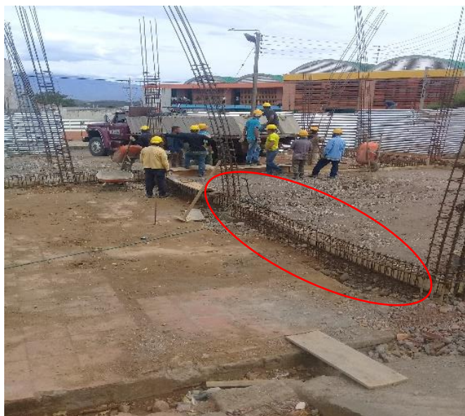
Figura 2. Vigas de cimentación para concreto 21 MPa (m2)
