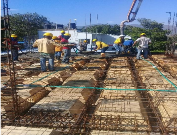
Figura 21. Vaciado de concreto de 21 MPa (m3) para placa aligerada (salones) y placa maciza (baterías sanitarias)
