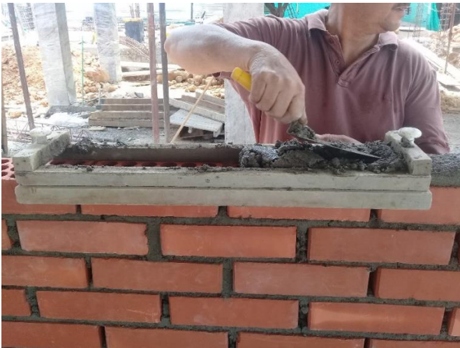
Figura 38. Mampostería primer salón
