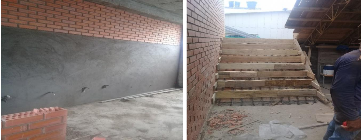
Figura 49. Pañete baterías sanitarias 1.80 mts y acero – nivelación escaleras
