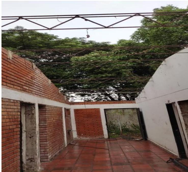
**Figura 7. Desmonte cubierto fibra cemento**
