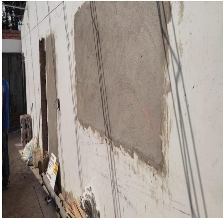
**Figura 9. Desmonte ventanas y puertas**
