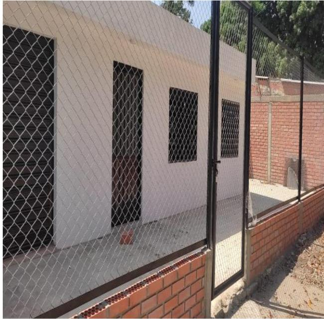
**Figura 18. Muro ladrillo a la vista espesor 10 cm**
