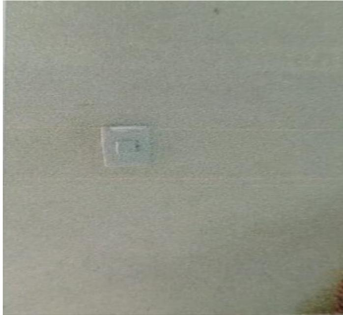
**Figura 26. Salida tomacorriente 110V**
