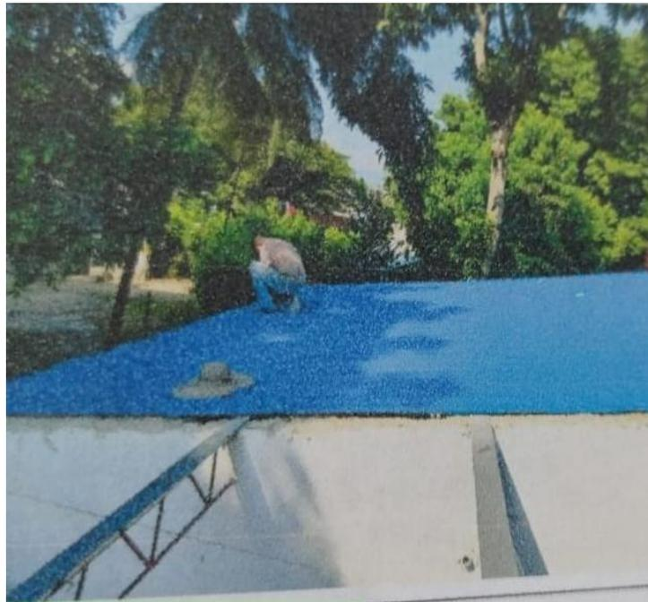
**Figura 23. Cubierta en teja termo acústica**
