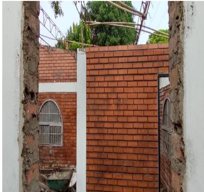
**Figura 3. Demolición manual muro en ladrillo**
