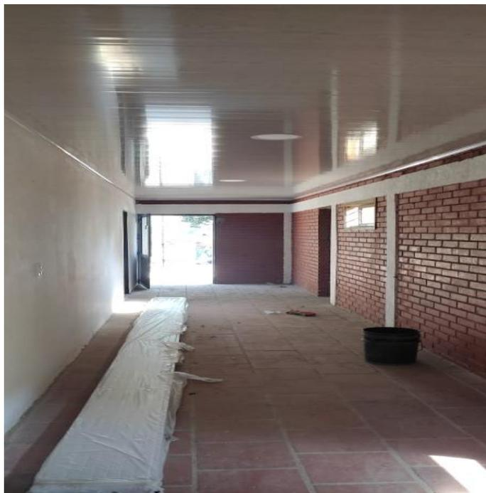
**Figura 24. Cielo raso en lamina de PVC**
