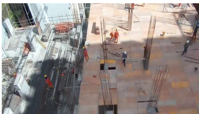
Figura 1. Armado cama y acero
