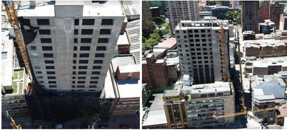
Figura 5. Avance pañete fachada edificio
