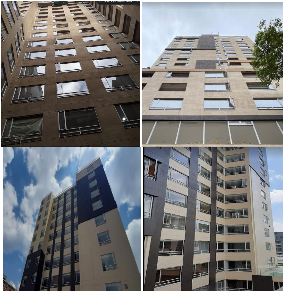
Figura 6. Terminación pintura fachada
