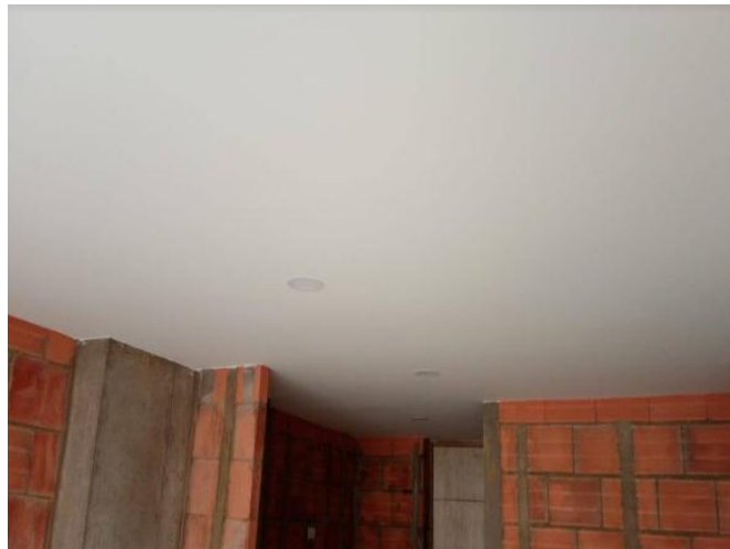
Figura 4. Refleja terminación drywall e instalación iluminación de cada unidad inmobiliaria
