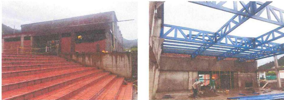
AVANCE DE OBRA
