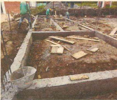
RELLENO CON MATERIAL DE EXCAVACION
