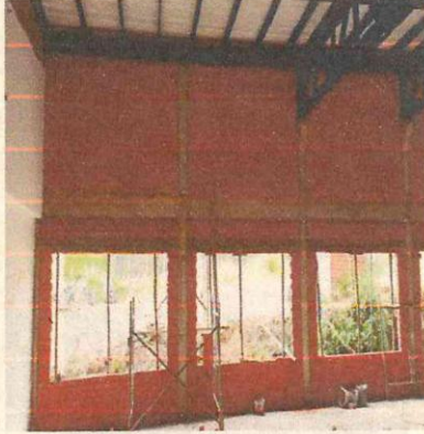
INSTALACIÓN EN TAPAS EN REGATAS
