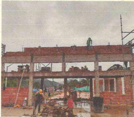
CONCRETO REFORZADO COLUMNETAS
