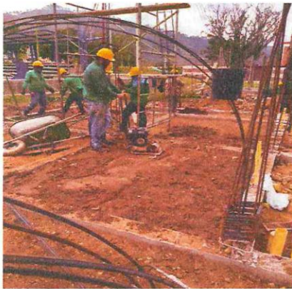
RELLENO GRAVA TRITURADA VIBROCOMPACTADA
