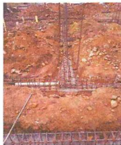
ACERO DE REFUERZO PLACA ALIGERADA H.30
