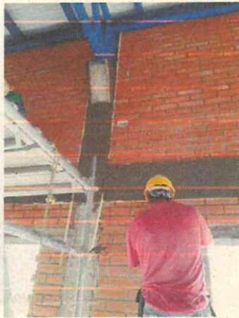
PAÑETE VIGAS Y COLUMNAS
