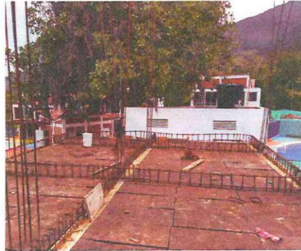
CONCRETO COLUMNAS CONCRETO VIGAS ENTREPISO
