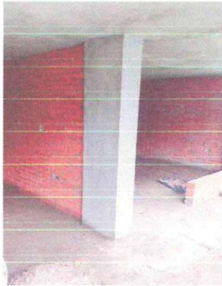
PAÑETE COLUMNAS -FILO TABLERO GENERAL 30 CIRCUITOS
