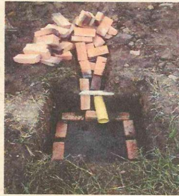
RELLENO GRAVA TRITURADA VIBROCOMPACTADA CAJA INSPECCION 0.70X0.70
