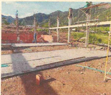
CONCRETO ANTEPISO MALLA ELECTROS E.00 CONCRETO ANTEPISO MALLA ELECTROS E.00
