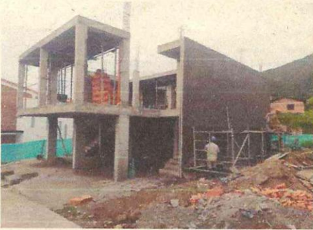
PAÑETE MUROS EXTERIORES
