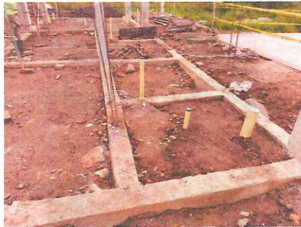
CONCRETO VIGAS DE ENLACE
