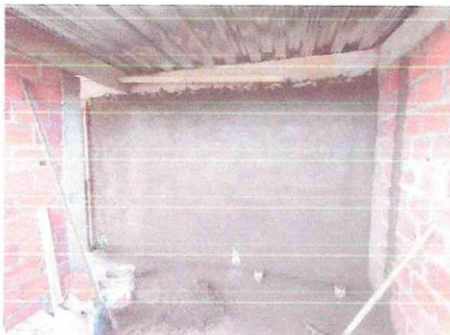
CUBIERTA TERMOACUSTICA UPVC 3MMS PAÑETE MUROS INTERIORES
