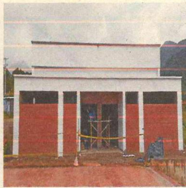
ESTUCO PLASTICO MUROS EXTERIORES
