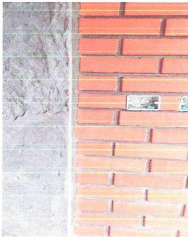
SALIDA TOMA CORRIENTE COMUN 220V SALIDA TOMA CORRIENTE GFCI
