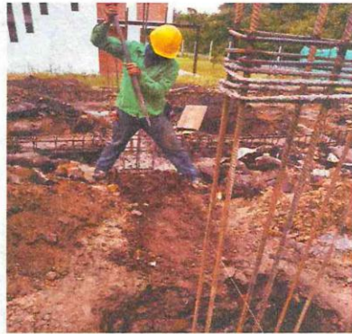
EXCAVACION MANUAL VIGAS DE ENLACE
