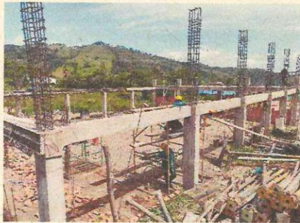
CONCRETO VIGAS AEREAS
