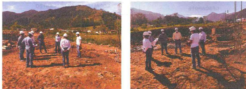
COMITES DE OBRA
