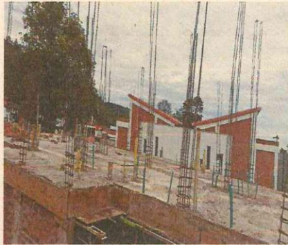
ACERO DE REFUERZO
