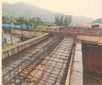
ACERO DE REFUERZO
