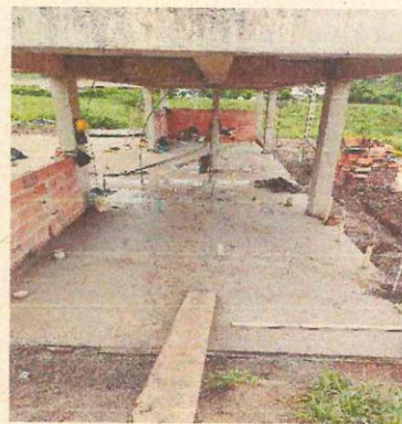
CONCRETO ANTEPISO MALLA ELECTROS E.00 CONCRETO ANTEPISO MALLA ELECTROS E.00
