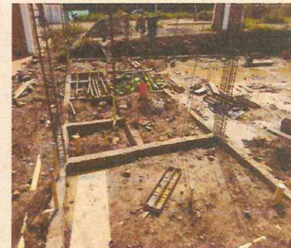
RELLENO CON MATERIAL DE EXCAVACION
