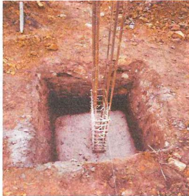
CONCRETO ZAPATAS CONCRETO VIGA DE ENLACE
