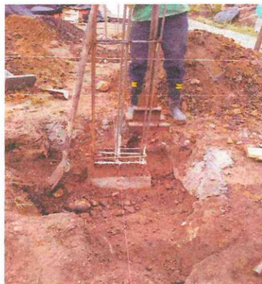
CONCRETO PEDESTALES RELLENO MATERIAL EXCAVACION
