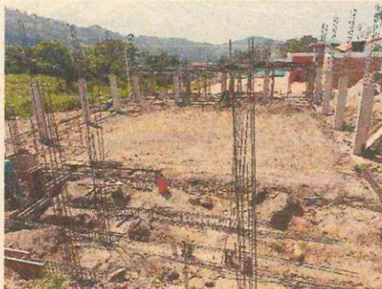
RELLENO GRAVA TRITURADA VIBROCOMPACTADA
