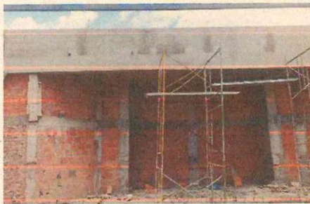
PAÑETE MUROS EXTERIORES PAÑETE VIGAS Y COLUMNAS
