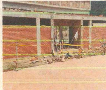
MURO LADRILLO VISTO E. 12,5CM
