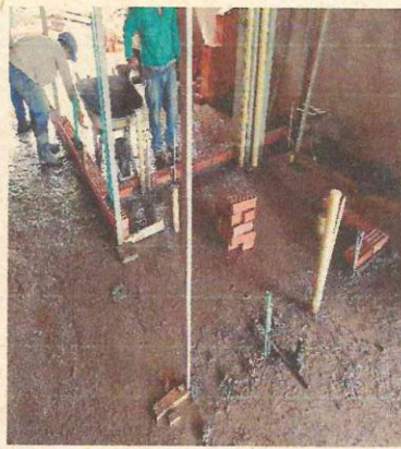
TUBERIA PVC/SANT ENTRE PLACA Ø 2" PUNTO AGUA FRIA PVC
