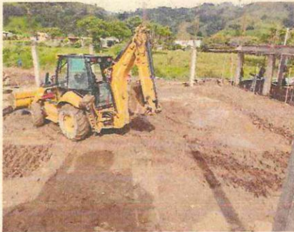
RELLENO GRAVA TRITURADA VIBROCOMPACTADA
