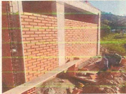
MURO LADRILLO VISTO E. 12,5CM
