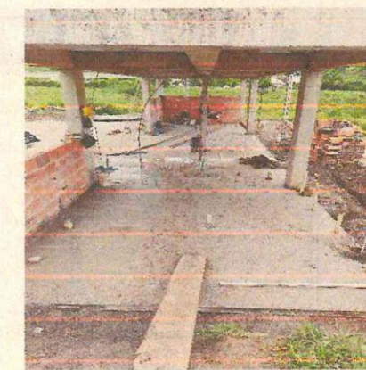
CONCRETO ANTEPISO MALLA ELECTROSOL
