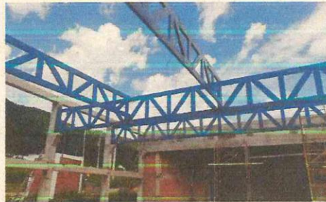
ESTRUCTURA METALICA CUBIERTA ESTRUCTURA METALICA CUBIERTA
