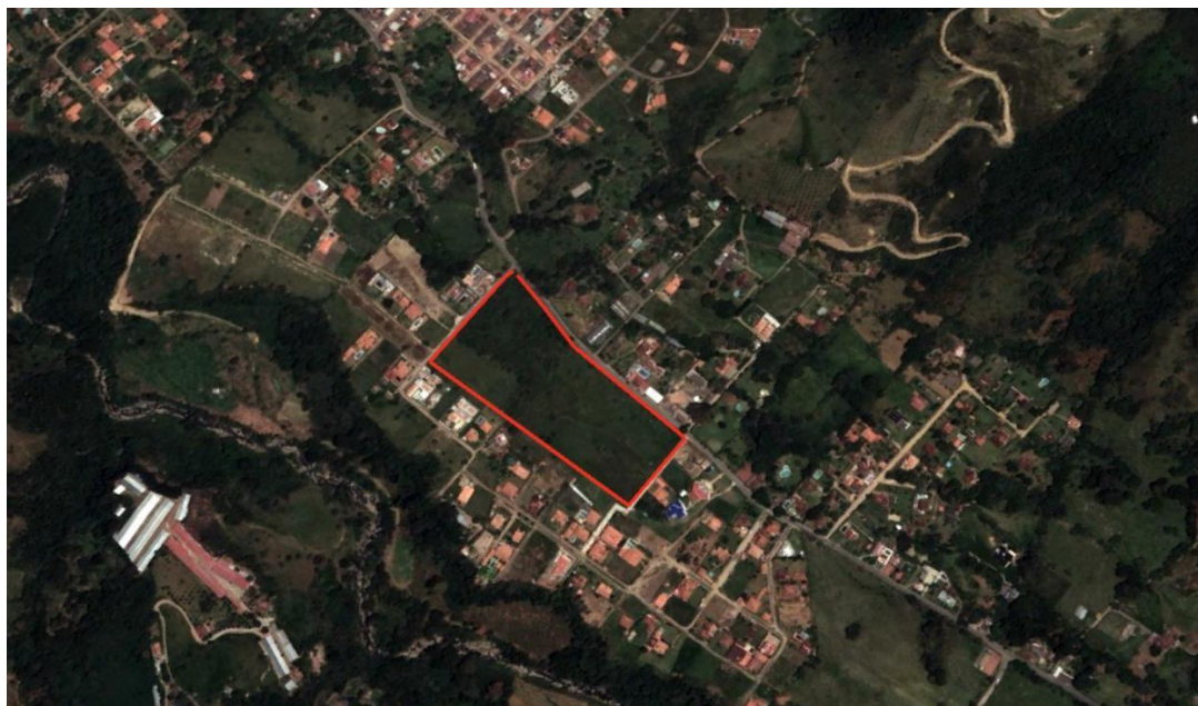
Figura 1. Localización donde se llevo acabo la ejecución de la obra civil para la ampliación de la infraestructura del centro recreacional y vacacional Comfaoriente en el municipio de Chinacota, departamento norte de Santander
