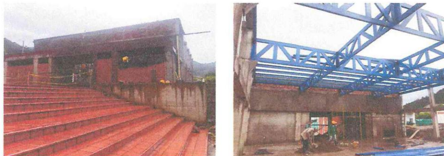
AVANCE DE OBRA
