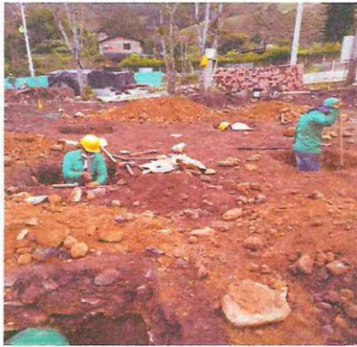
EXCAVACION MANUAL ZAPATAS
