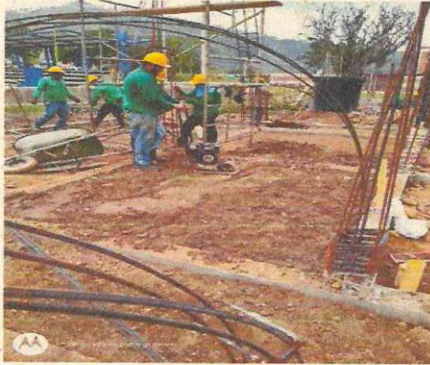
COLCHON GRAVA TRITURADA VIBROCOMPACTADA
