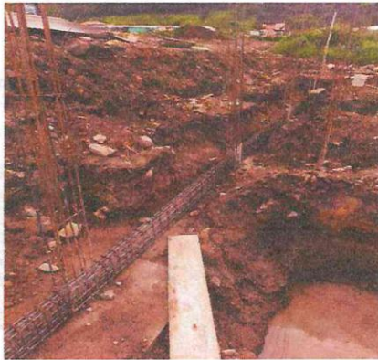
ACERO DE REFUERZO
