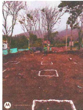
LOCALIZACION Y REPLANTEO
