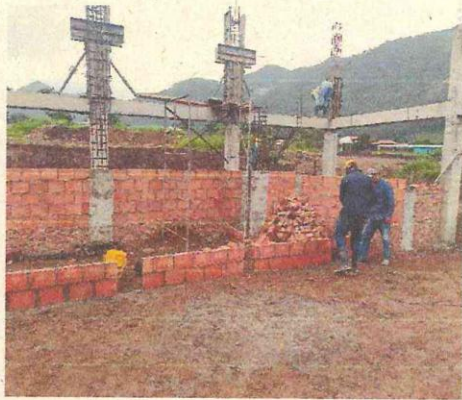
CONCRETO REFORZADO COLUMNETAS
