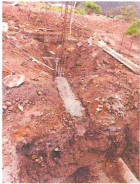
SOLADO CONCRETO DE SANEAMIENTO
