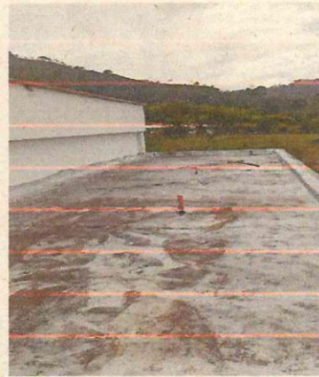
MANTO IMPERMEABILIZADO
