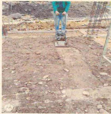
RELLENO GRAVA TRITURADA VIBROCOMPACTADA CAJA INSPECCION 0.70X0.70
