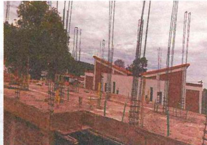
ACERO DE REFUERZO PLACA ALIGERADA H.30
