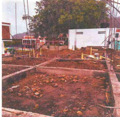
CONCRETO ZAPATAS CONCRETO VIGA DE ENLACE
