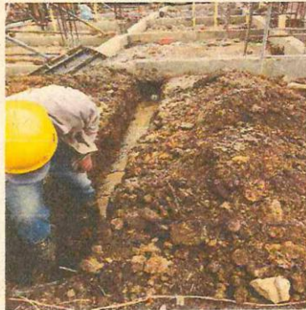
EXCAVACION Y RELLENO DESAGUES
