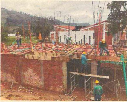
TUBERIA PVC/SANT ENTRE PLACA Ø 4"
