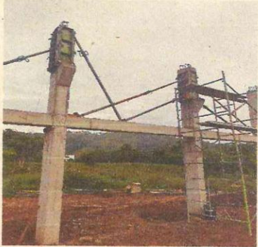
CONCRETO VIGAS AEREAS
