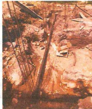
EXCAVACION ZAPATAS EXCAVACION MANUAL VIGAS DE ENLACE
