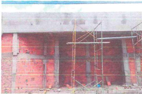
PAÑETE MUROS EXTERIORES PAÑETE VIGAS Y COLUMNAS
