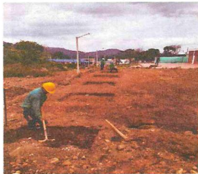
EXCAVACION ZAPATAS EXCAVACION MANUAL VIGAS DE ENLACE
