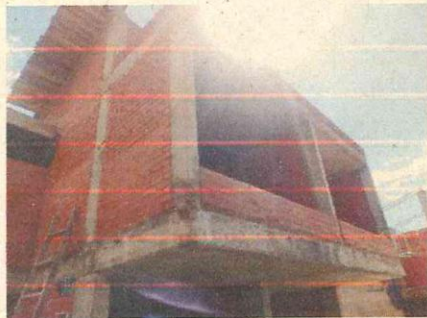
MURO LADRILLO VISTO DOBLE CARA E. 12,5CM
