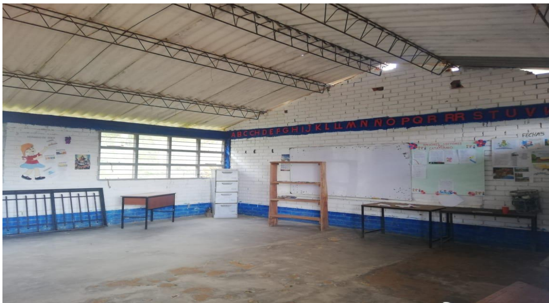
Fotografía del Salón 2
