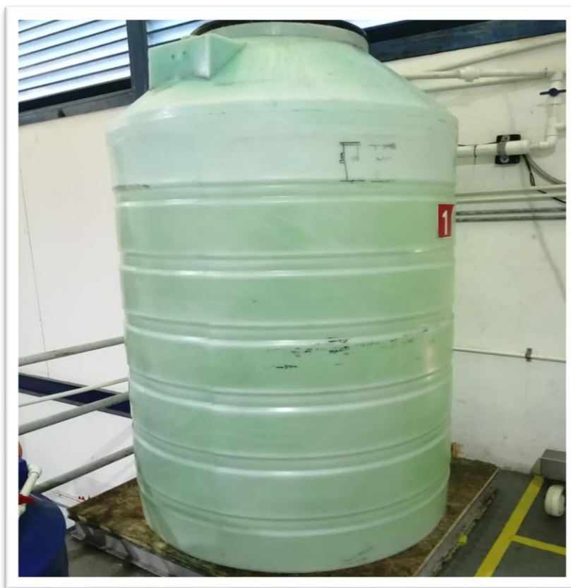
Figura 2. Tanque De Mezcla Del Cloro Denso
