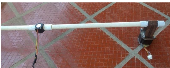
Figura 115. Instalación válvula y caudalímetro
