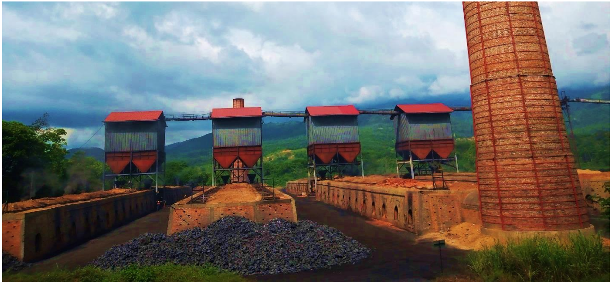
Figura 7. Tolvas de almacenamiento de carbón molido
