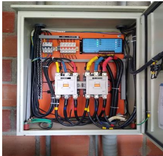
Figura 6. Planta eléctrica tablero de conexión
