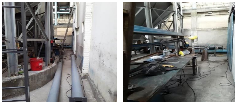
Figura 6. Zona de almacenamiento donde se ubican los silos
