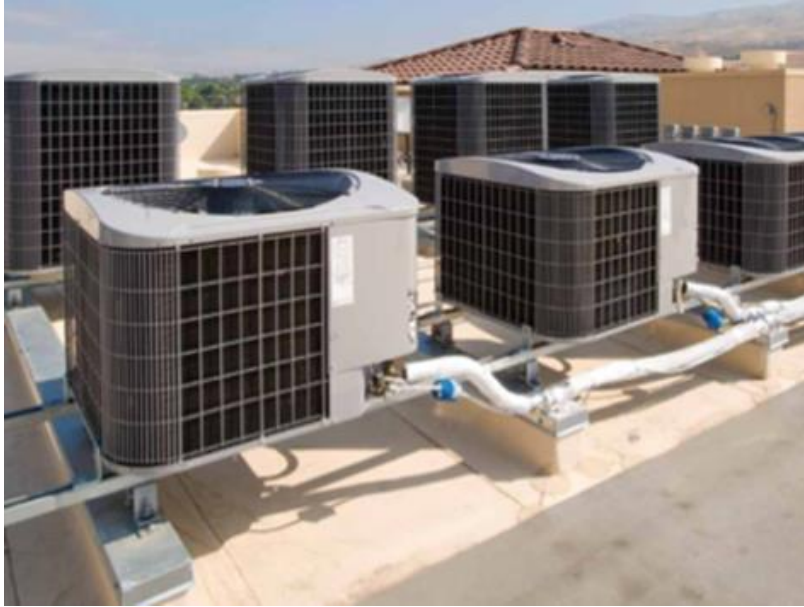
Figura 3. Unidad condensadora
