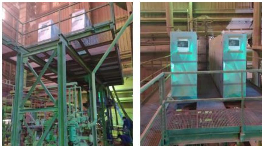
**Figura 96.** Intercambiadores para precalentamiento de barbotina
