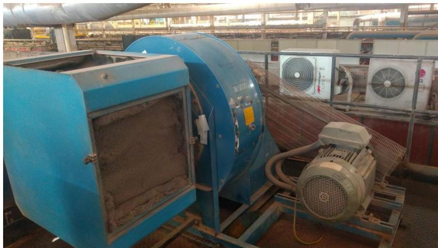
**Figura 33.** Ventilador aire de combustión
