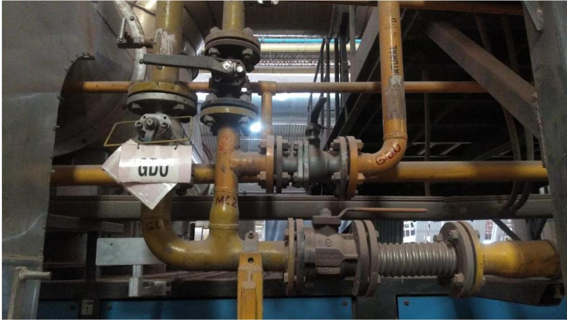
**Figura 19.** Bypass tubería de gas natural o GLP
