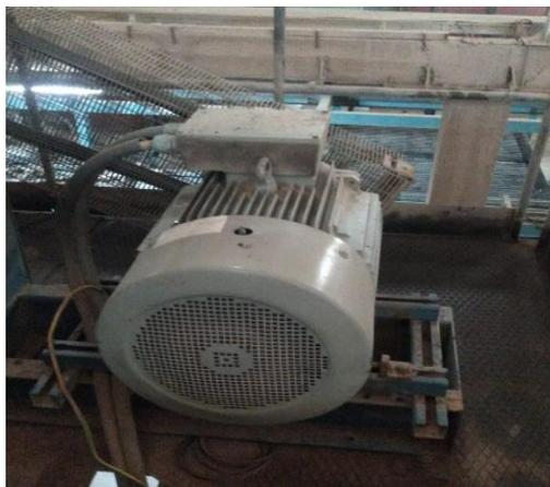
**Figura 54.** Motor ventilador de aspiración de humos y aire caliente
