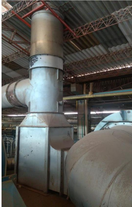
**Figura 81.** Chimenea de gases de refrigeración
