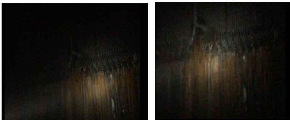
**Figura 11.** Fuga de agua en la tubería de la caldera.
