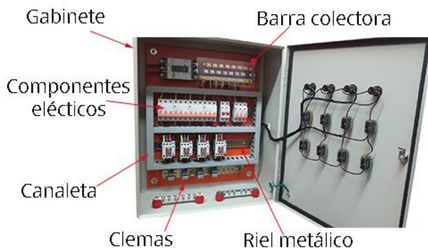
figura 1 Tablero de distribución BT
