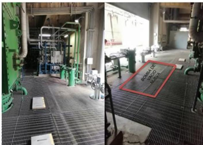
**Figura 10.** Ubicación de izaje bomba de vacío (nueva).
