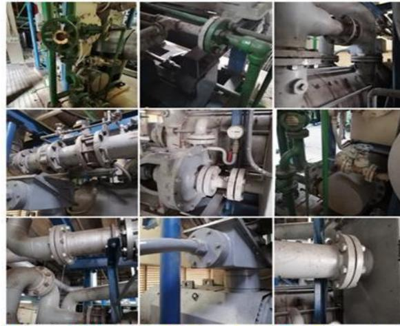
**Figura 6.** Bridas y tuberías (desconexión)
