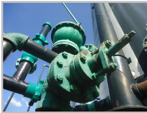
Foto 2. Válvula de compuerta 2''x250 sin volante
