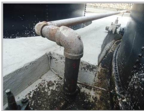
Foto 6. Fin de inspección
