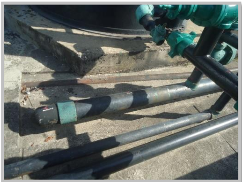
Foto 1. Inicio de la inspección
