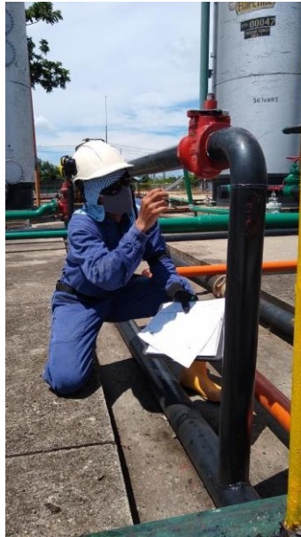
Figura 7. Inspección visual aplicada a la tubería de transporte de hidrocarburo desde tratadores térmicos a tanques de almacenamiento.
