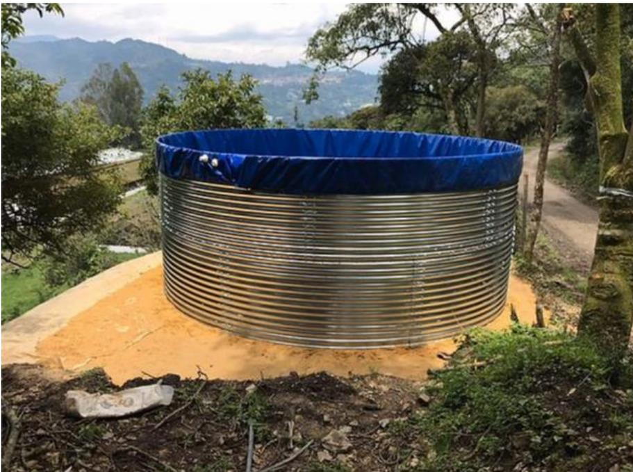
**Ilustración 8. Tanque Doble de 55.300 Litros**
