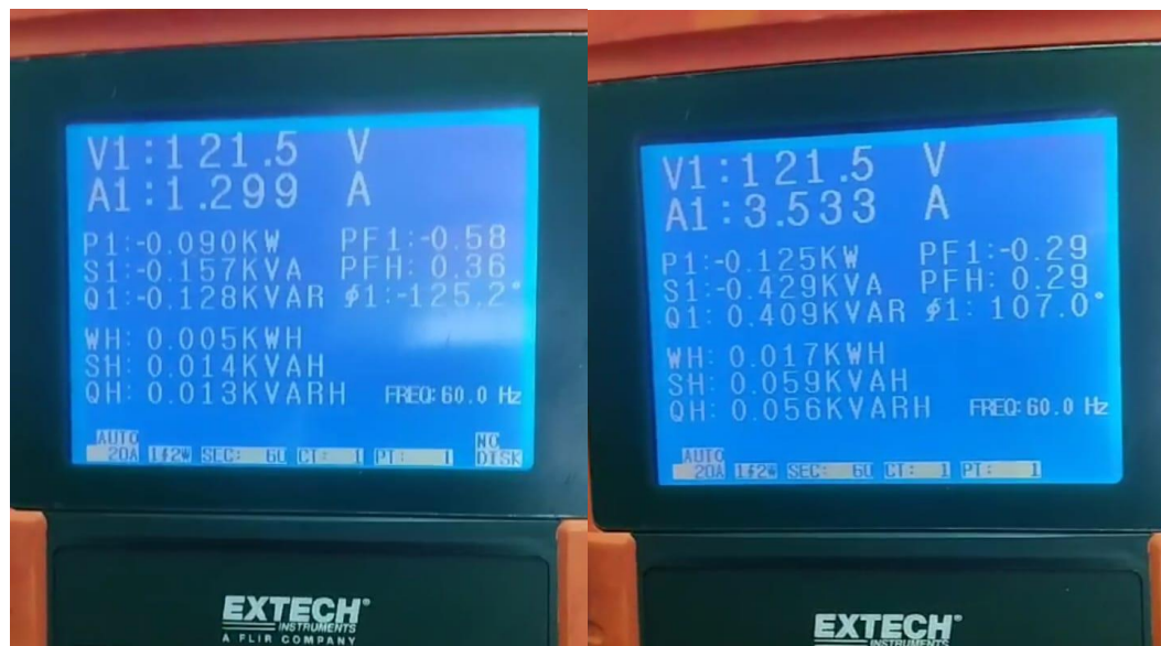
Figura 21. Medidas del analizador de potencia antes y después de la compensación de luminaria led.
