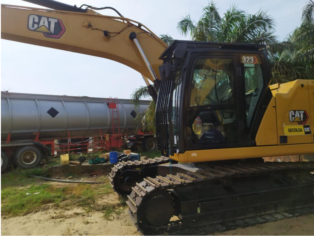
Retroexcavadora 323 para excavación.
