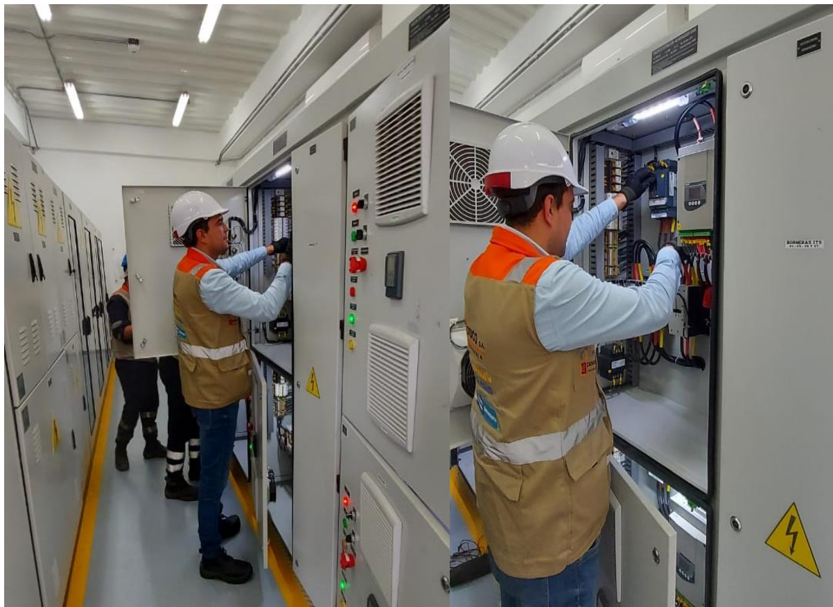
Figura 11. Mantenimiento de tableros ccm y equipos eléctricos
