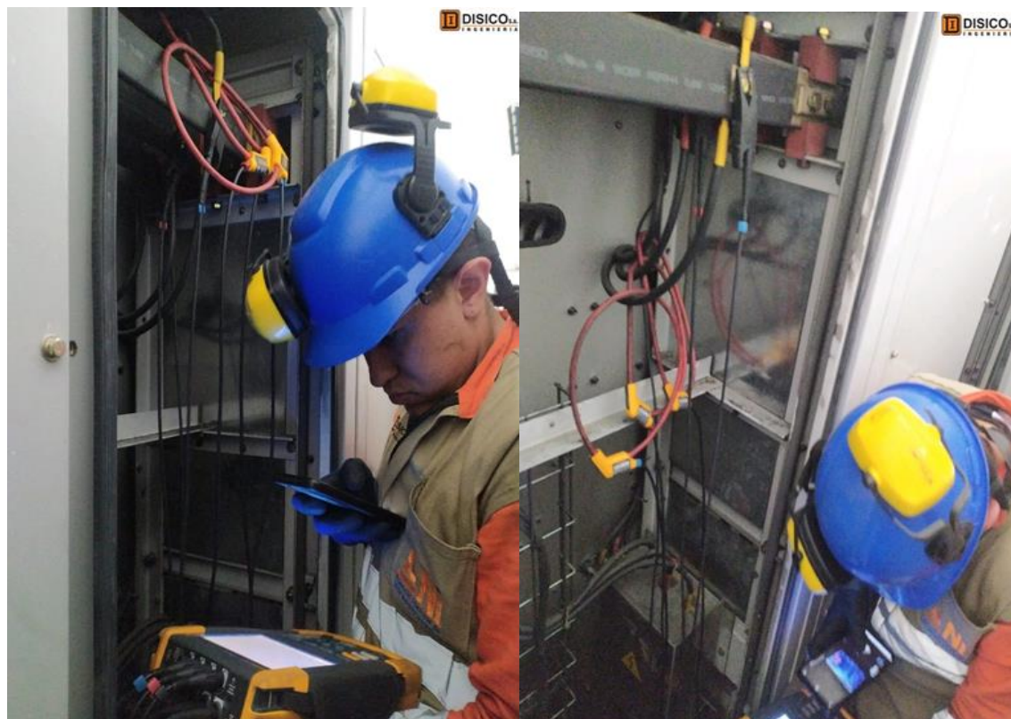
Figura 14. Medición de aislamiento de motores
