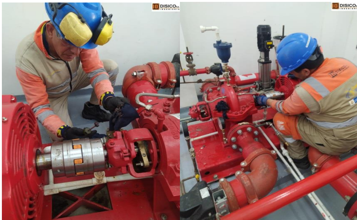
Figura 10. Análisis y mantenimiento al sistema de red contra incendios
