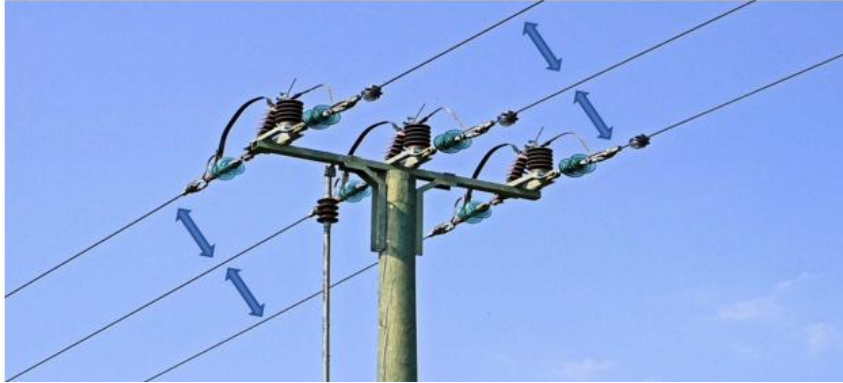
Figura 2. Distancia entre conductores
