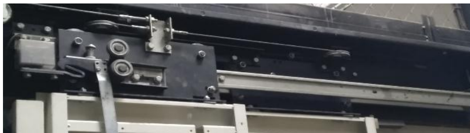
Figura 10. Mecanismo de apertura telescópica lateral
