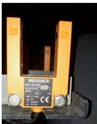
Figura 45. Inductores magnéticos para pulsos y señales de corte (cambio de velocidad) y nivelación
