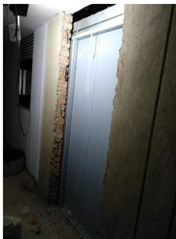
Figura 69. Instalación de marcos y puertas
