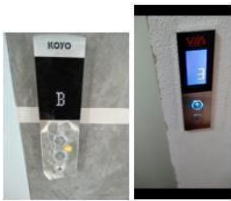
Figura 40. Botonera de piso con Display
