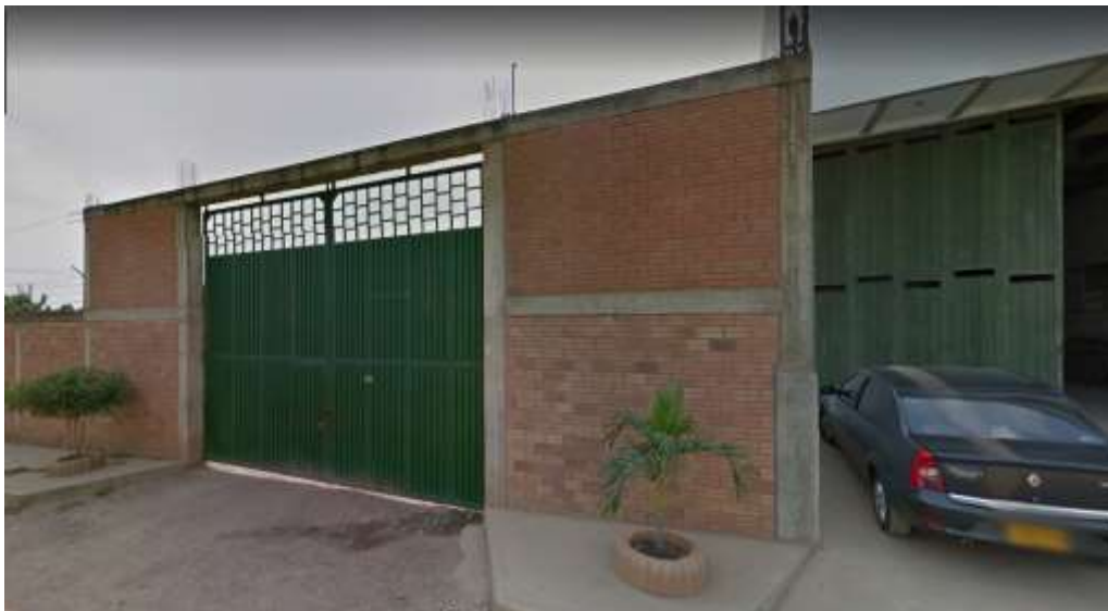
Figura 3. Vista exterior de Montacargas Moreno Botello.
