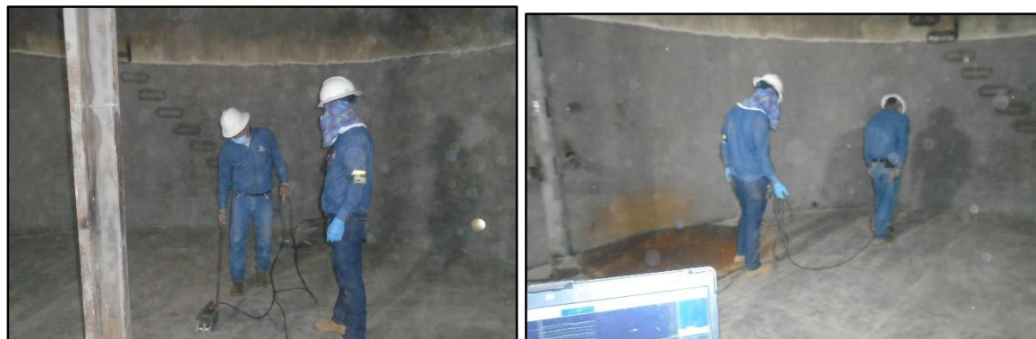
Fotografía 22. Inspección mediante MFL.
