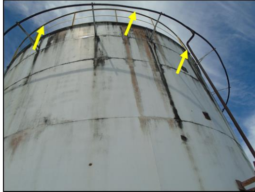
Fotografía 9. Sistema de contraincendios.
