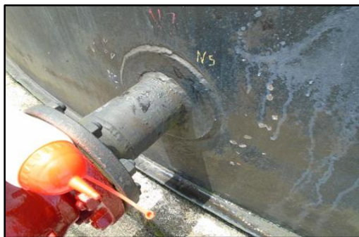
Fotografía 17. Boquillas en buen estado.
