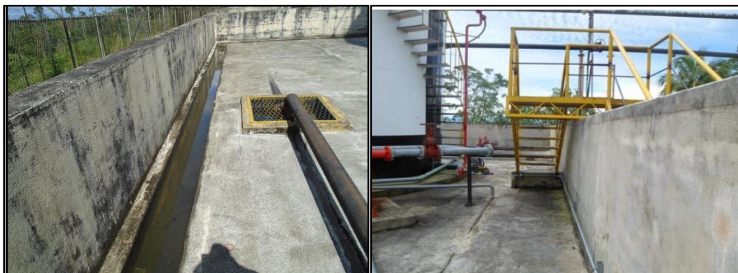
Fotografía 1. Estado del dique del tanque.
