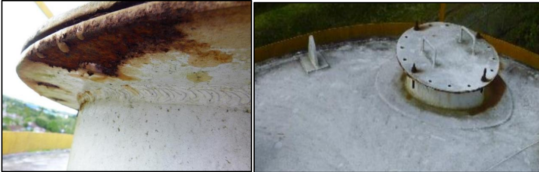
Fotografía 20. Manhole del techo.
