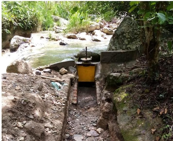
**Figura 12.** Compuerta de captación luego del montaje
