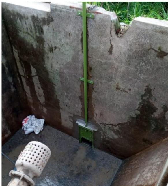
**Figura 13.** Compuerta del tanque de almacenamiento luego del montaje
