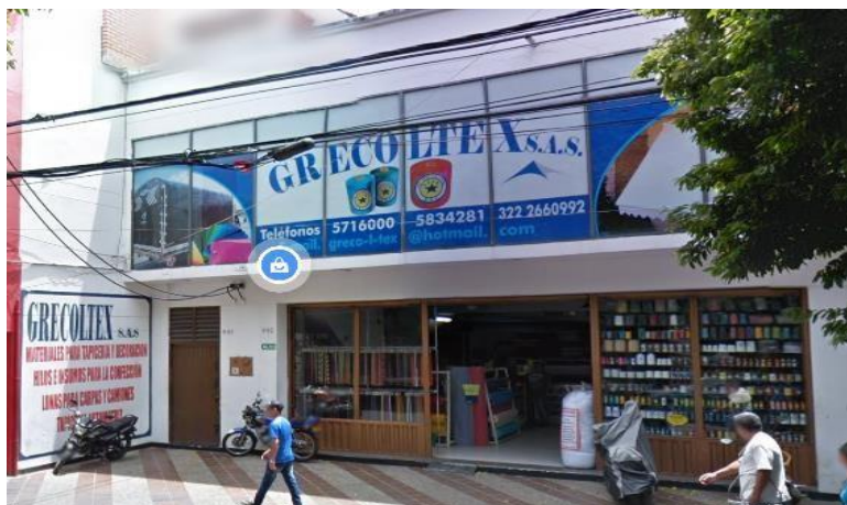
Figura 36. Entradas de la empresa para primer y tercer piso.
