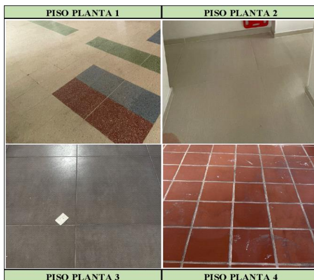
Figura 40. Imágenes de los pisos en cada planta del edificio
