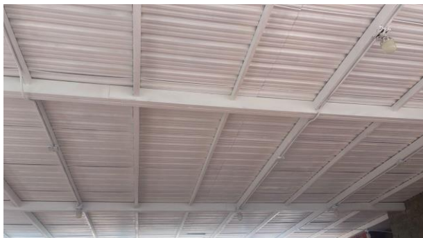
Figura 42. Imagen del techo del área de producción
