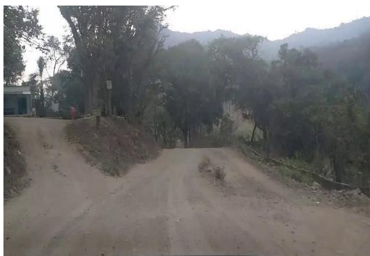
Hundimientos y perdidas de banca en el tramo
