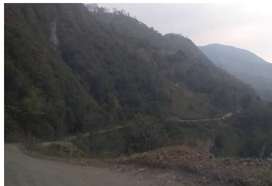
Superficie de rodadura en afirmado
