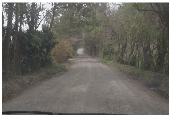
Superficie de rodadura en afirmado
