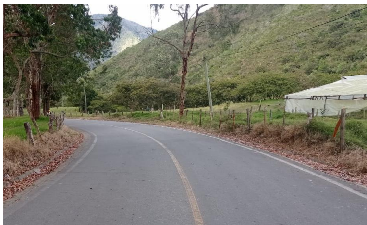
Figura 8. Vista tramo critico #1
