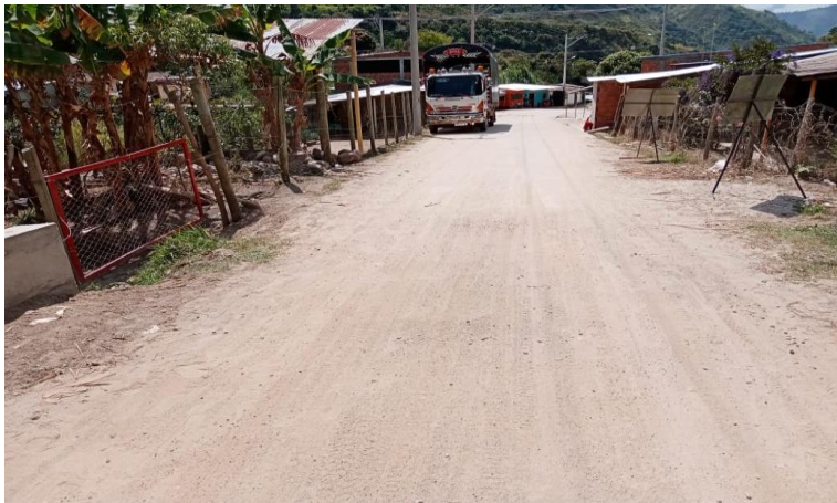
Figura 14. Vista tramo crítico #4
