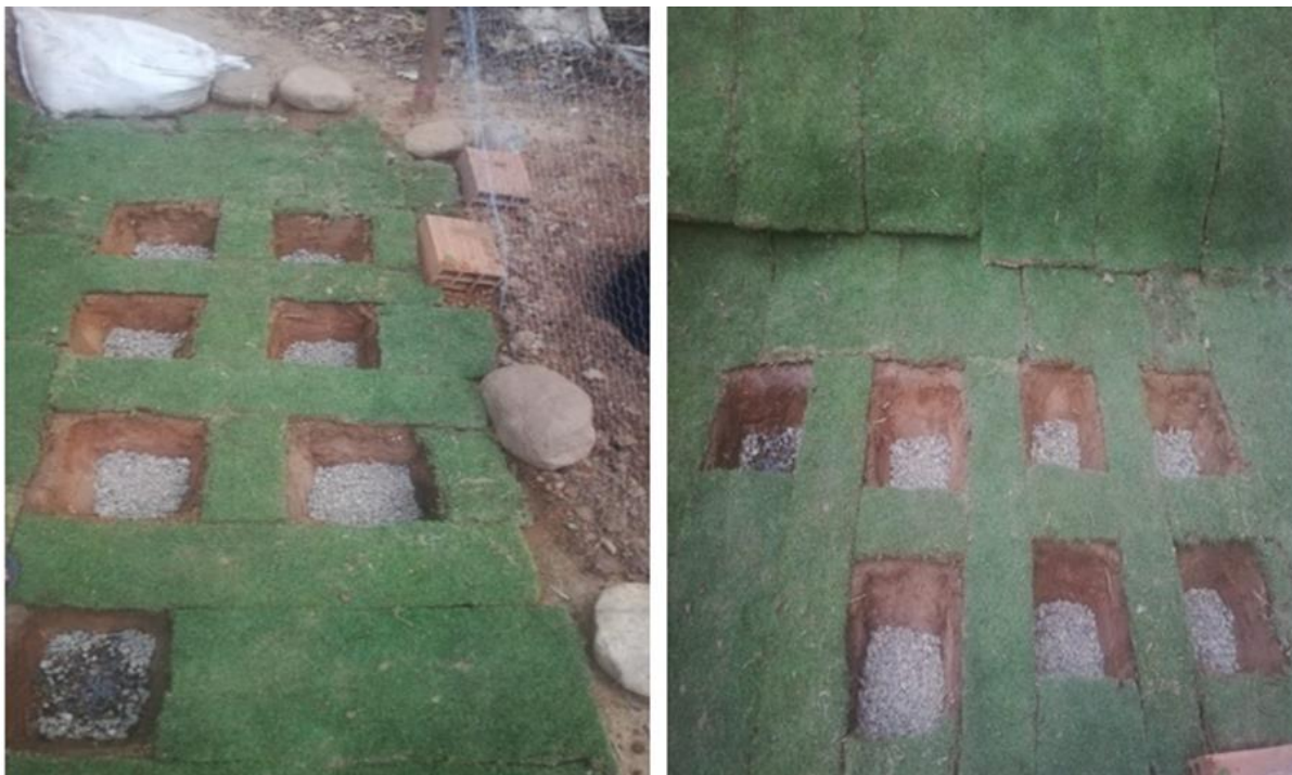
Figura 8 Instalación de la grava.
