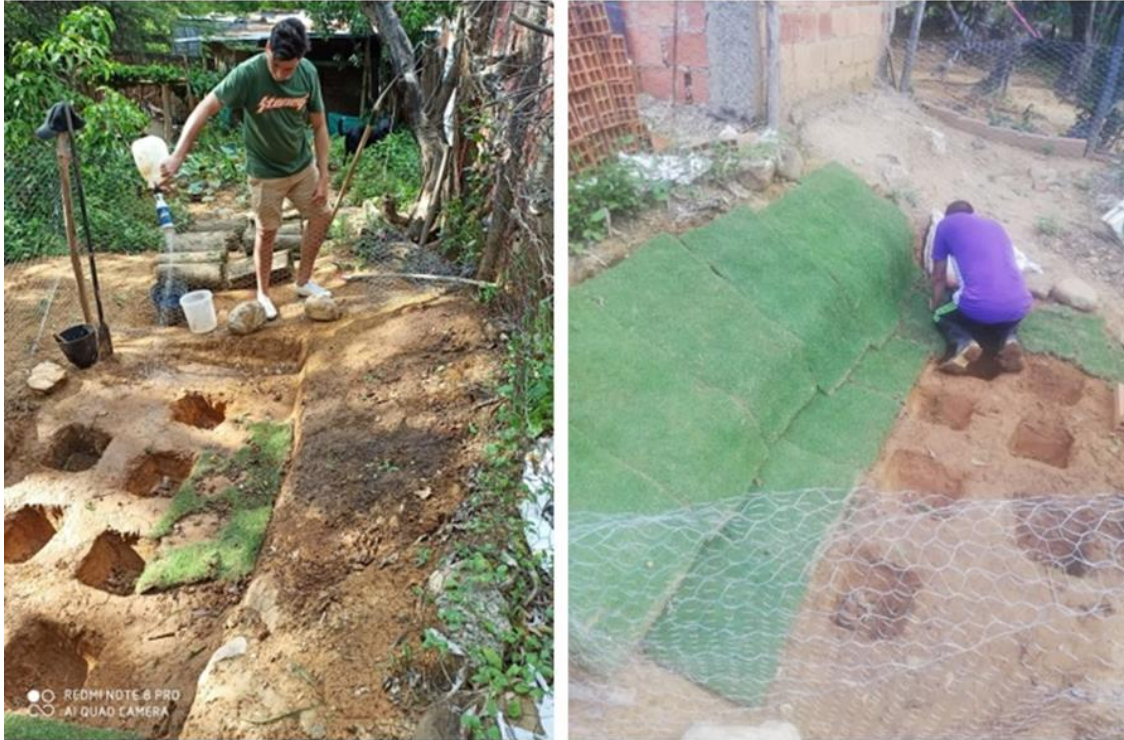
Figura 7 Instalación del césped.
