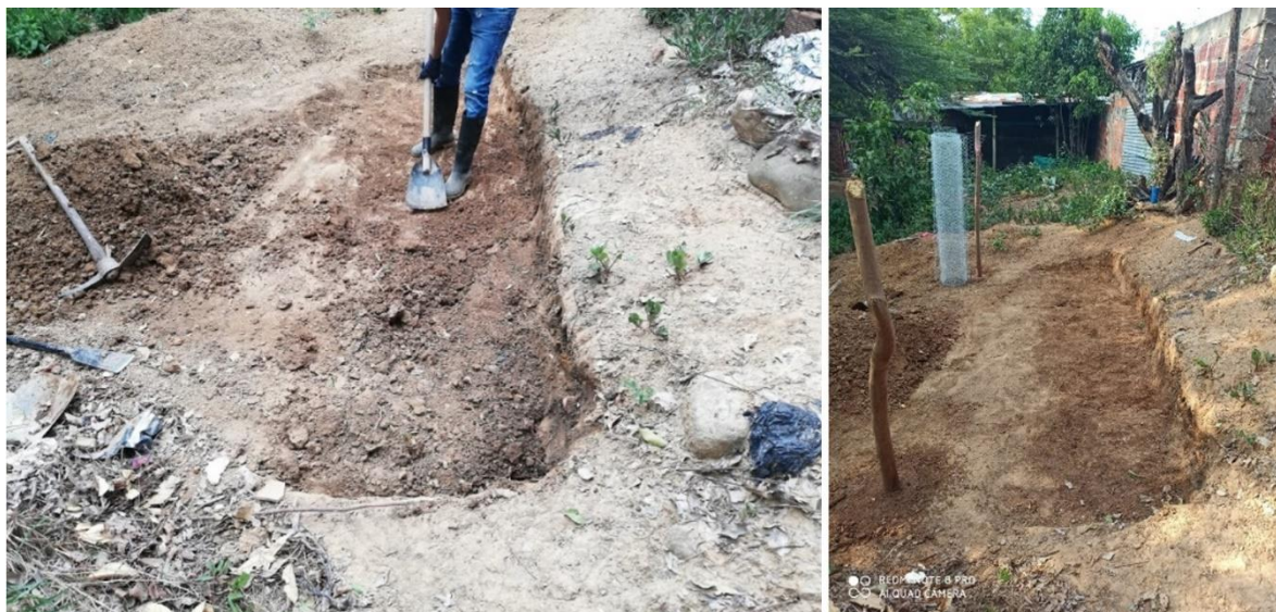
Figura 4 Corte de Nivelación de Terreno
