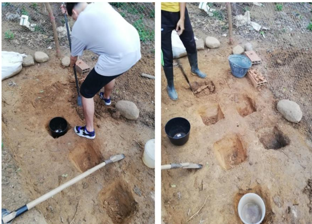
Figura 6 Excavación para la instalación de los recipientes
