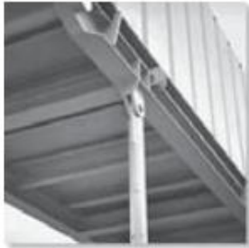
Figura 76. Ilustración real de apoyos o soportes enfrentados a fuerzas bidimensionales
