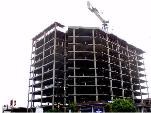
Figura 11. Representación estructura entramada o de armazón
