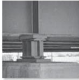
El soporte de mecedora para esta trabe de puente permite el movimiento horizontal de manera que el puente pueda dilatarse y contraerse por cambios en la temperatura. (5)
